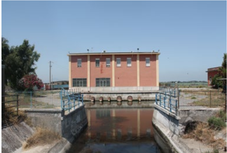
3.6 Litorale Domizio, impianto di sollevamento acque foto dell'autore
