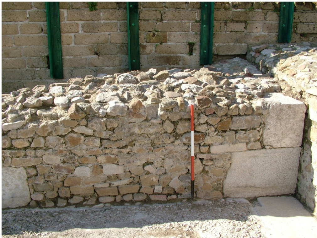
Fig. 15. Conza della Campania ( Compsa ). Foro. Cantonale est edificio A ( Capitolium ).
