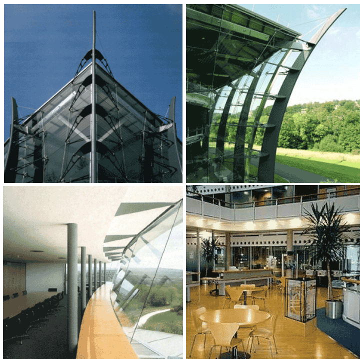
Fig. 1.11 - Western Morning News, particolari costruttivi e interni
