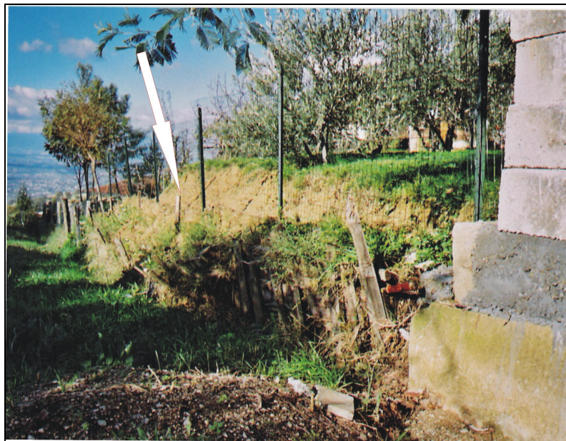
Fig. 7.33: Lesioni alla recinzione di un'abitazione limitrofa a quella crollata.
