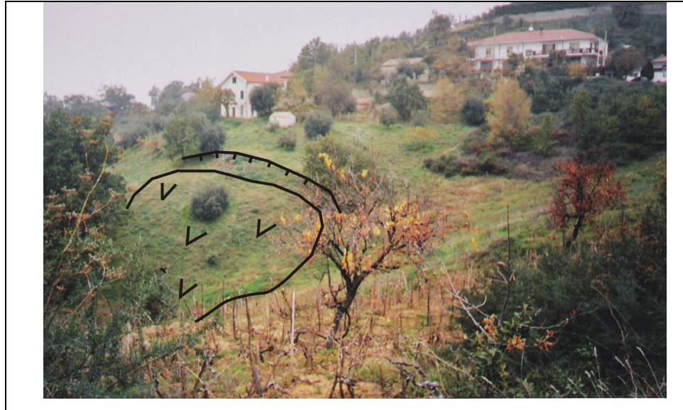
Fig. 7.31: Panoramica dalla strada provinciale in loc. Santo Miele.
