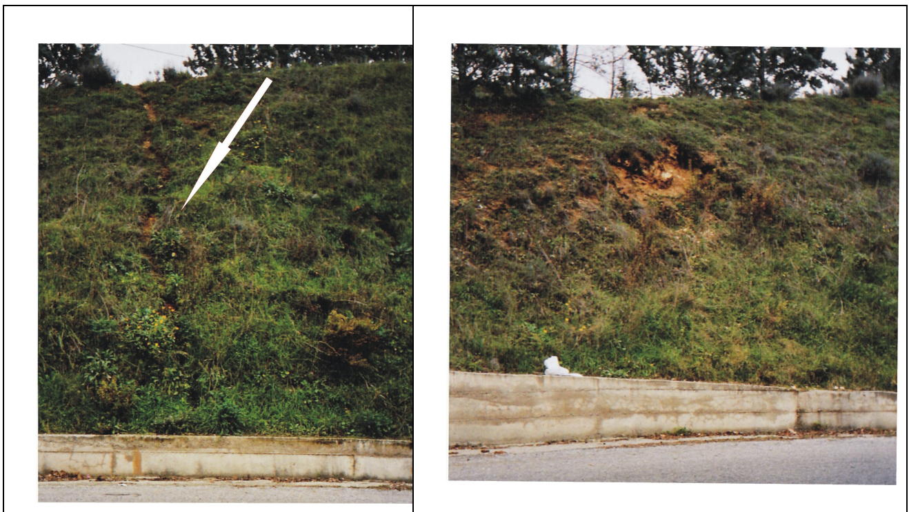
Fig. 7.28: Rill lungo la S.S. 559.
