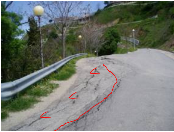
Fig. 7.20: Strada comunale in dissesto nei pressi del centro abitato.
