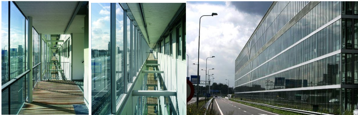
Immagini relative alla situazione dopo gli interventi (fonte: Renovatie woongebouw De Leeuwan Vlandern Amsterdam, Bouwen met Staal 2006)
