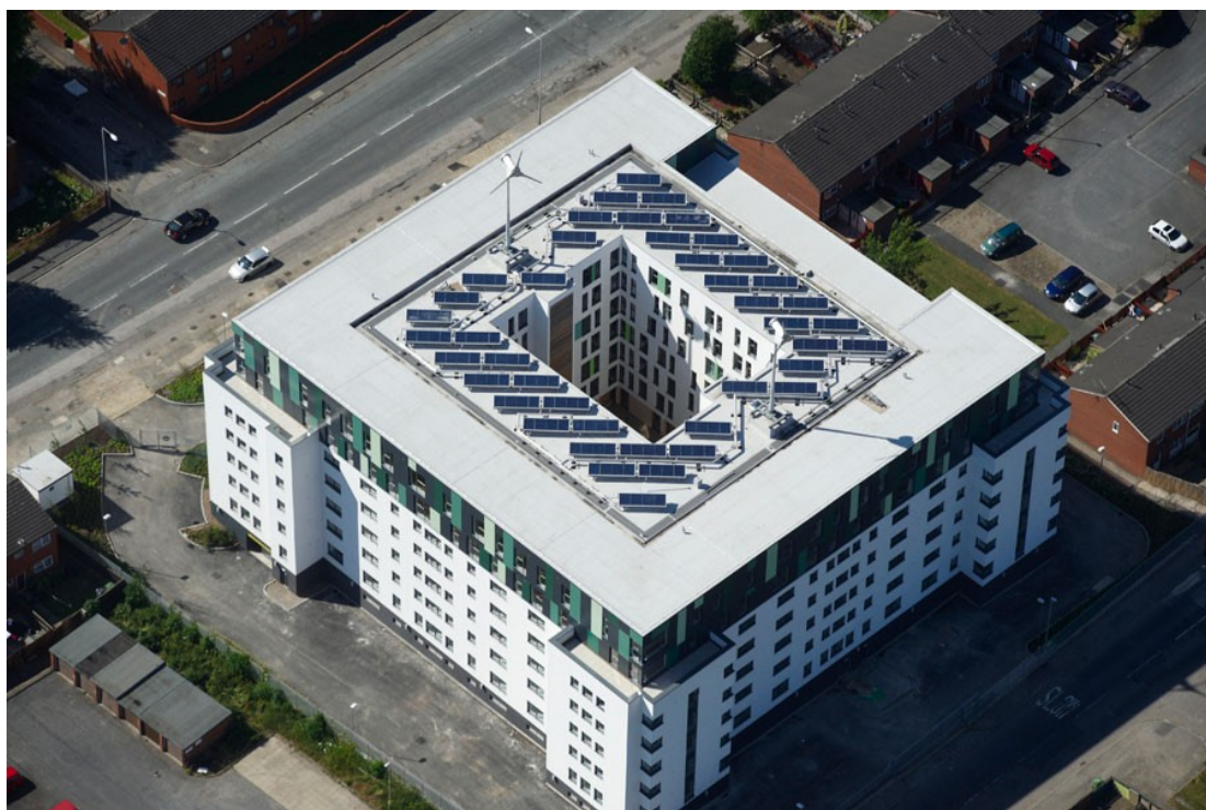
Veduta complessiva (fonte http://www.protechroofing.co.uk/ )
