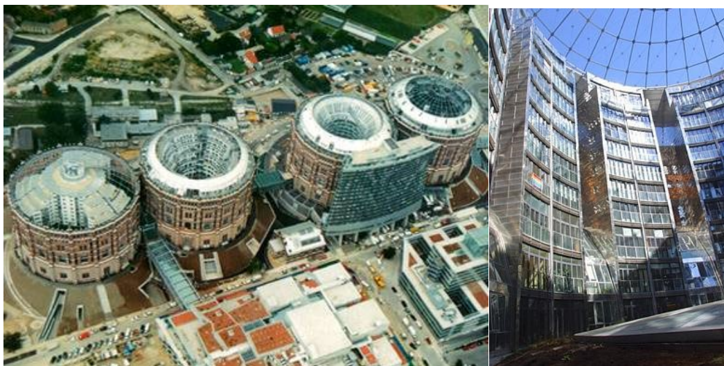
I Gasometri di Vienna, convertiti in edifici residenziale misto, commerciale, auditorium, direzionale (fonte http://www.floornature.it/ , http://www.luxury24.ilsole24ore.com/ Jean Nouvel, Coop Himmelb(l)au, Manfred Wedhorn, Wilhelm Holzbauer Datazione costruzione edifici originari: 1896-1899, Datazione concorso per la riconversione: 1995 Datazione progetto e realizzazione: 1999-2001
