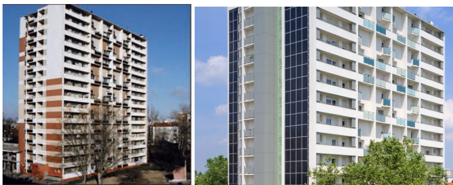
La torre C prima e dopo l'intervento (fonte Celentano e Terzigni; www.grandlyonhabitat.fr )
