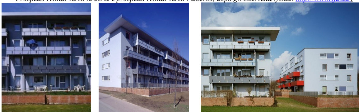
Particolari del prospetto esterno, dopo gli interventi; sulla dx si scorge il Blocco 04 (fonte http://www.sfa.de/ )
