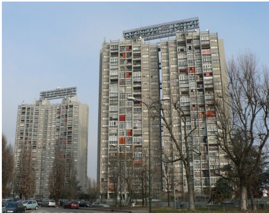
Torino, case-torri Cooperativa di abitazioni Giuseppe Di Vittorio. Fotografia di Michele D'Ottavio, tecnica esecutiva a coffrage tunnel (fonte © MuseoTorino, 2011)
