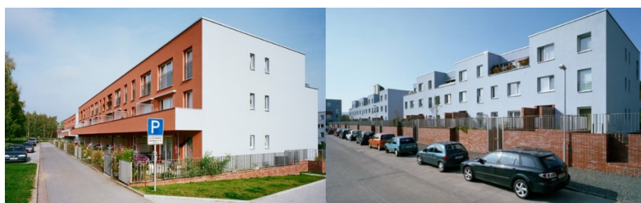
Blocco 05, prospetto verso l'esterno e prospetto verso la grande corte dopo gli interventi (fonte http://www.sfa.de/ )
