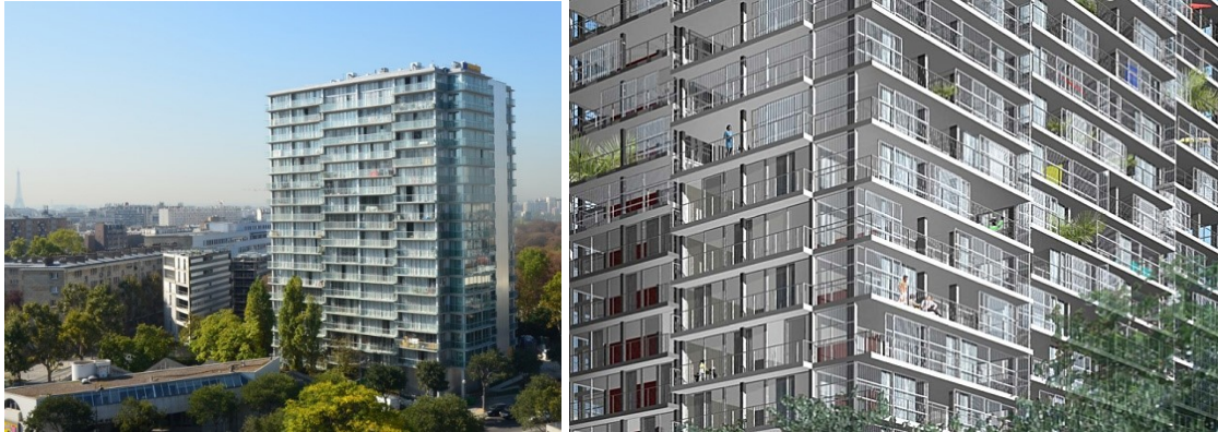
Veduta della torre che traguarda la Tour Eiffel e particolare delle logge climatiche (fonte http://www.architectural-review.com/ )
