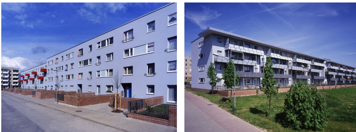
Prospetto rivolto verso la corte e prospetto rivolto verso l'esterno, dopo gli interventi (fonte: http://www.sfa.de/ )
