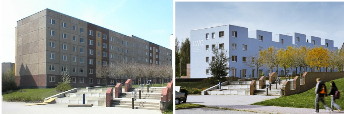
Blocco 06, prospetto prima della trasformazione e prospetto dopo gli interventi del Blocco 06 (fonte http://www.bryla.pl/ )
