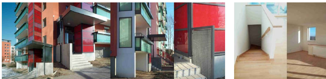
Vedute dopo gli interventi
