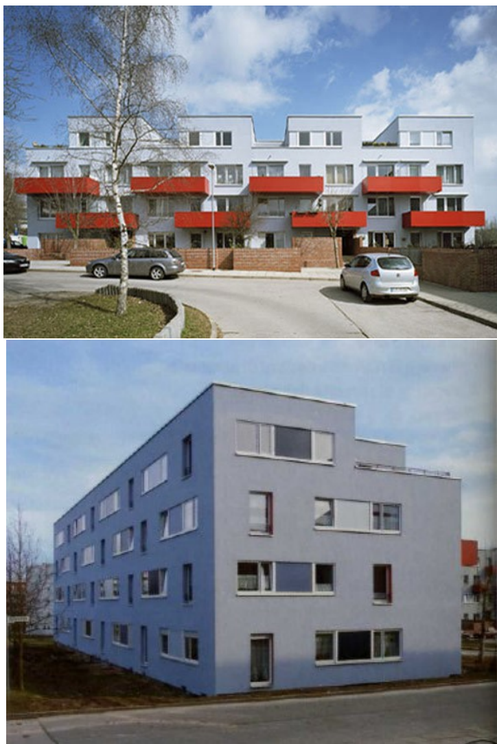
Prospetti del Blocco 04 dopo i lavori (fonte http://www.sfa.de/ )
