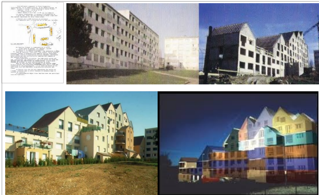
Recupero di Béthoncourt, Demolizione parziale e rimodellamento di una stecca, 1995-98 (fonte http://www.formes-vives.org/ , www.masterecopolis.it )
