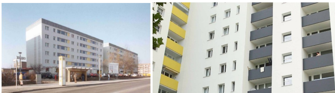
Casa Nova Architekten, Berlino-Hellersdorf, prima e dopo gli interventi (fonte http://www.cnarch.de/intro.swf )
