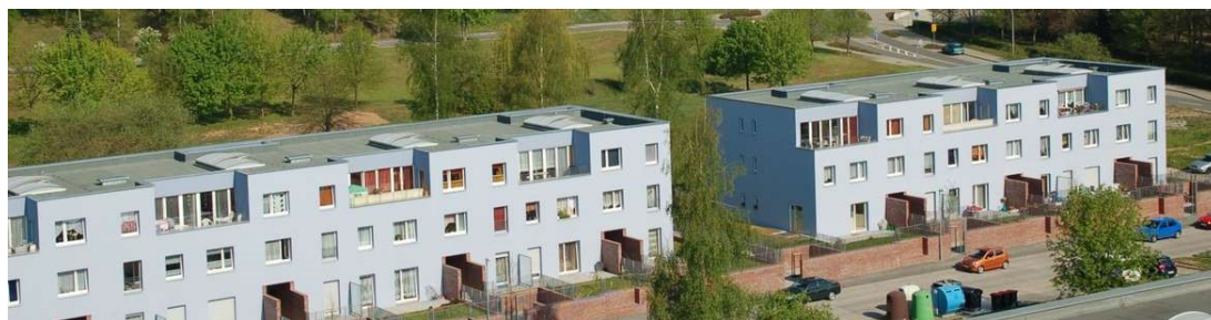
Blocco 0,5, prospetto verso la corte dopo gli interventi (fonte http://www.sfa.de/ )
