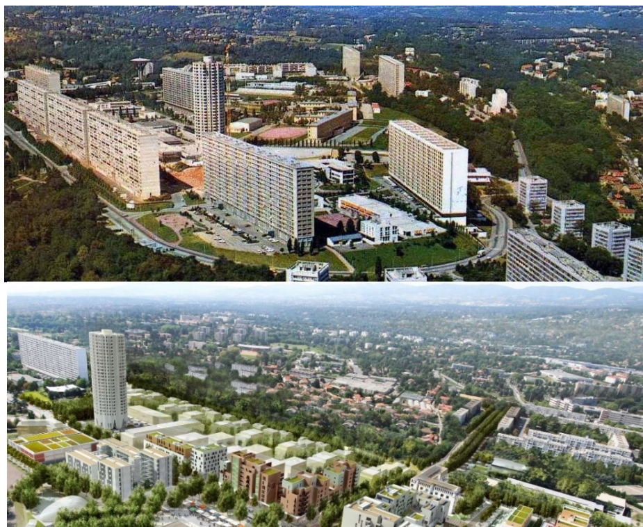
Foto panoramica del quartiere e planivolumetrico (fonte http://projetfrance2012.canalblog.com/albums/les_banlieues/photos/104007456-lyon_quartier_la_duchere.html ; http://www.serl.fr/ )
