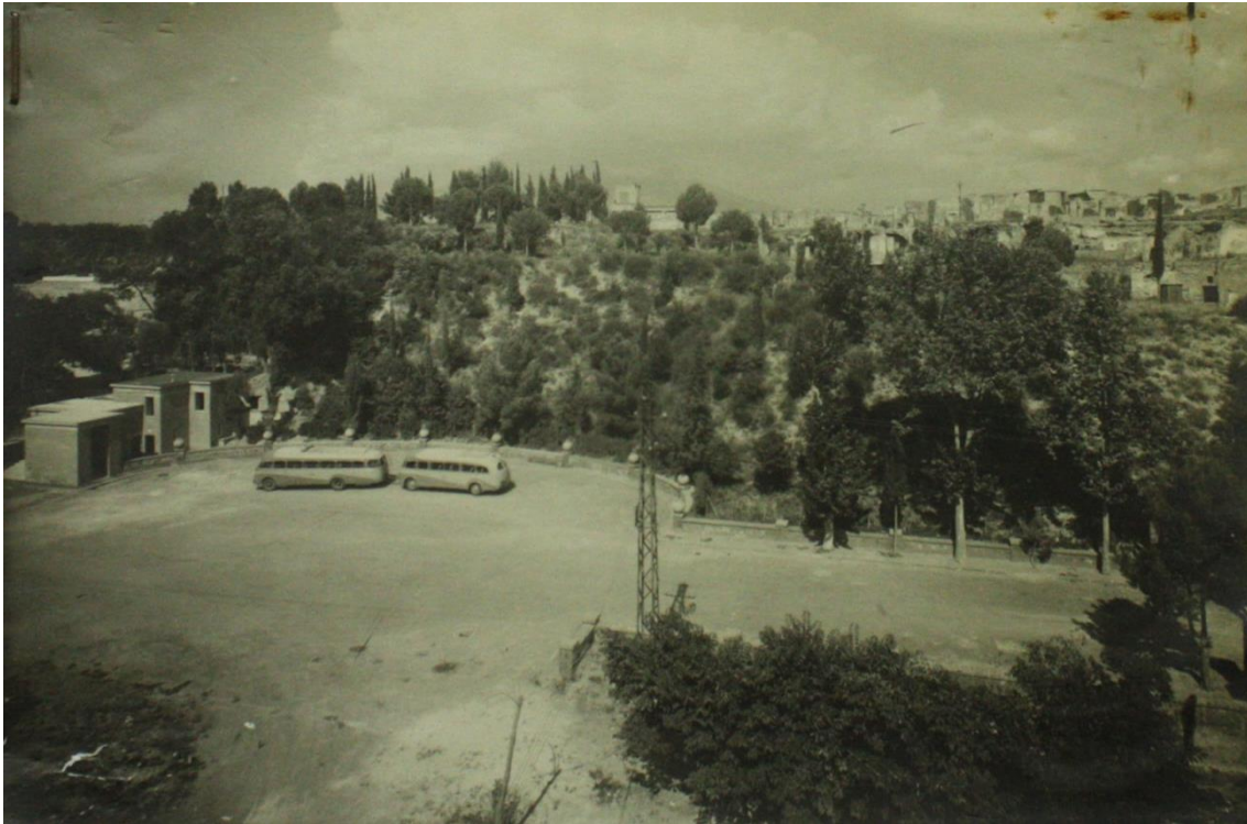
Fig 4: Pompei, piazza Esedra prima della rimozione dei cumuli borbonici
