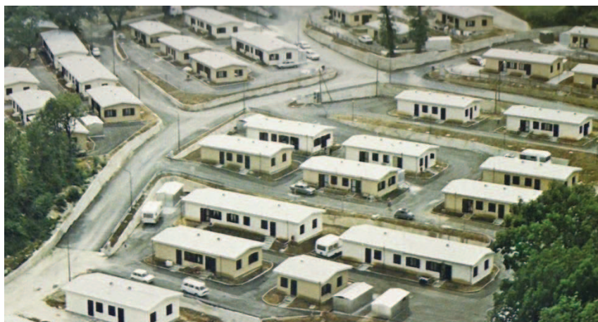
Altro villaggio di prefabbricati nella zona «Boschetto» - Sant'Angelo dei Lombardi
