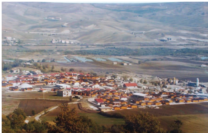
Il villaggio prefabbricati lungo la SS Ofantina
