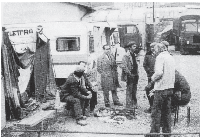
Il campo presso il cantiere della Ferrocemento a Conza della Campania
