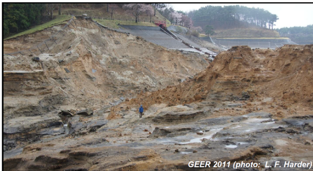
Fig. III.24 – L’asportazione del materiale del corpo diga.
