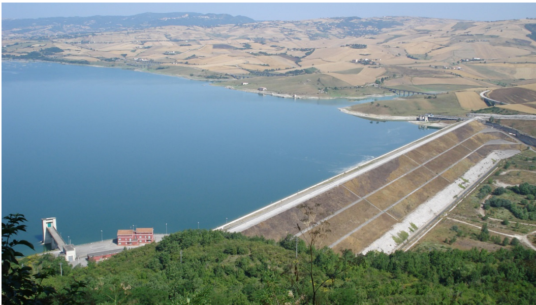
Fig. III.8 – Panoramica della diga di Conza ( http://eipli.it/competenze/dighe/153_diga-di-conza ).
