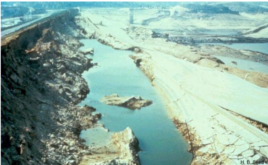
Fig. III.4 - Paramento di monte a seguito dello svasso del serbatoio (Boulanger R.W., sito web: http://cee.engr.ucdavis.edu/faculty/boulanger/ ).
