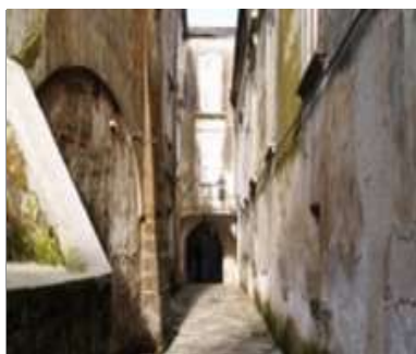
4.15 - Torre lato nord.
