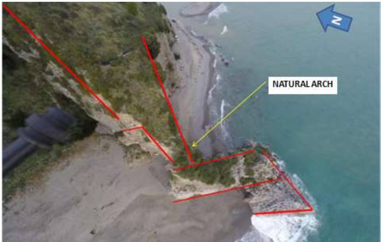
Figura 4-46 Immagine raccolta tramite rilievo UAV, sono bene visibili i principali lineamenti tettonici
