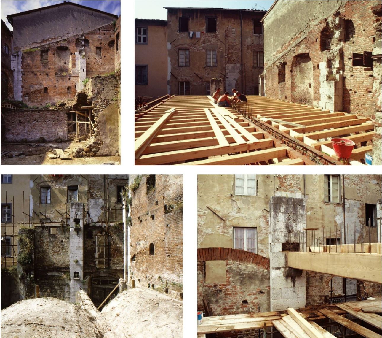
Fig. 3.4.9 – Lo stato ante-operam del blocco Sud ed alcune fasi della realizzazione dei nuovi solai lignei
