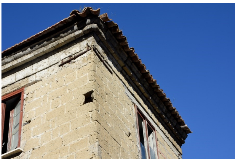
Fig. 4.3.35 – Aggetto della linea di gronda realizzato con blocchi di tufo sagomati
