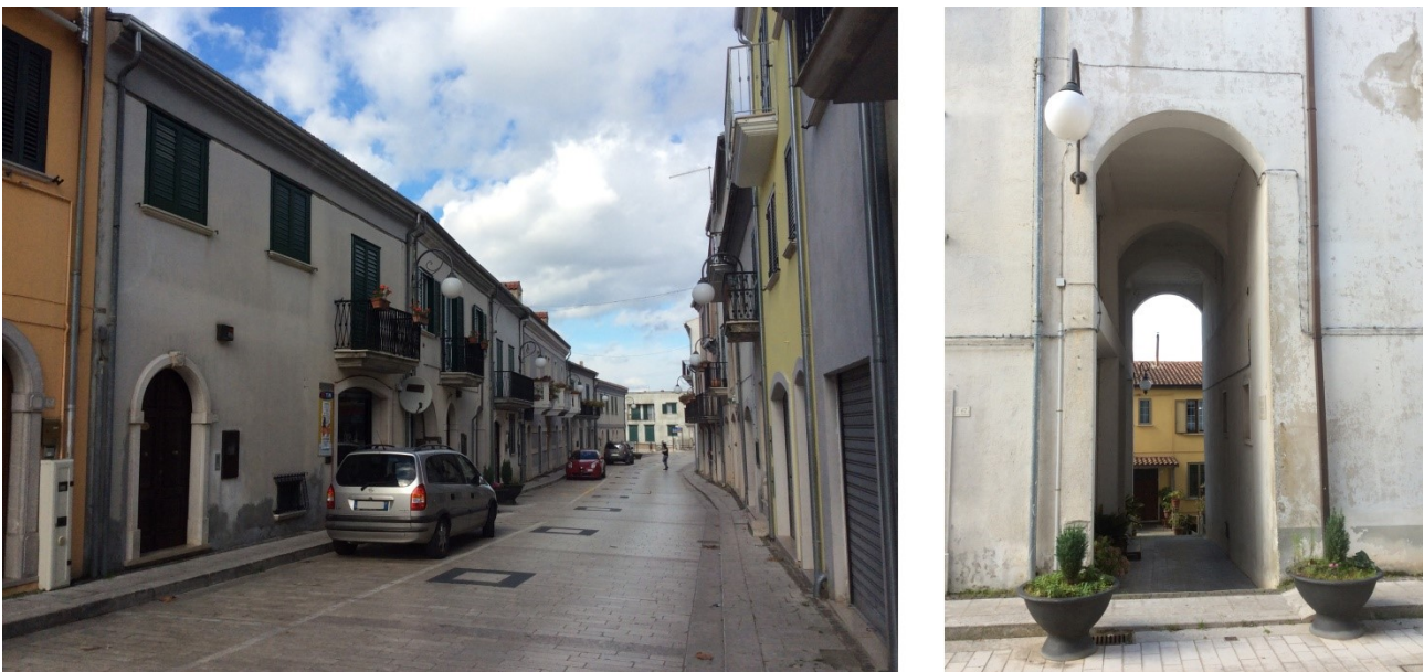
Fig. 3.2.16 – Scorci di Corso Plebiscito come appare oggi, privo del porticato di progetto. Nelle cortine edilizie del lato Ovest sono stati realizzati, seppur in forme più tradizionali, i varchi trasversali passanti, a doppia altezza.
