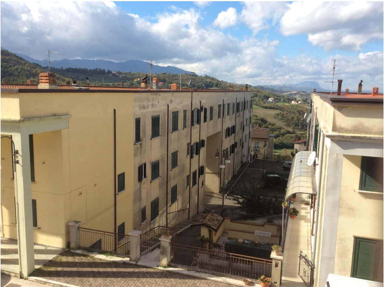
Fig. 3.2.19 – Quartiere Pianistrello: una delle aree pertinenziali degradanti verso valle, poste fra una stecca e l'altra
