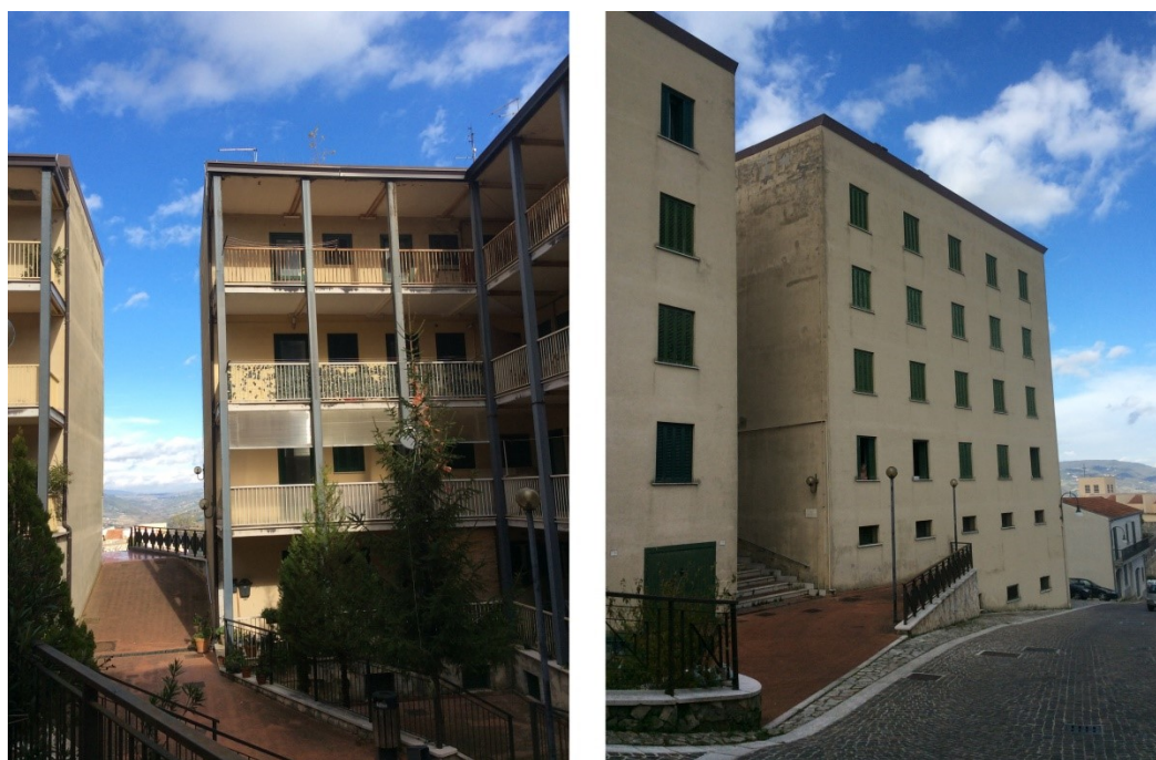
Fig. 3.2.24 – La corte interna con i ballatoi di accesso alle residenze ed uno scorcio lungo Via Roma
