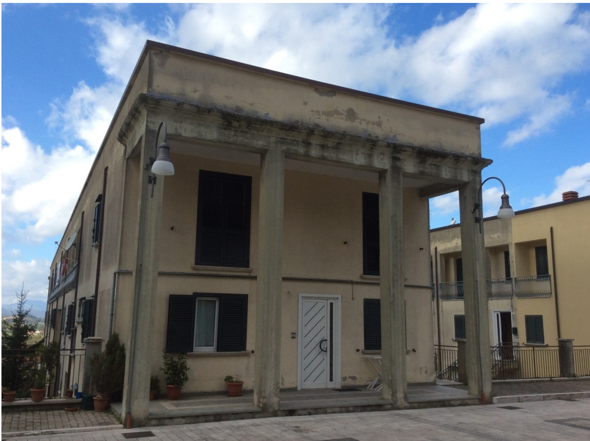
Fig. 3.2.17 – Quartiere Pianistrello: la testata lungo strada di una delle sei stecche residenziali
