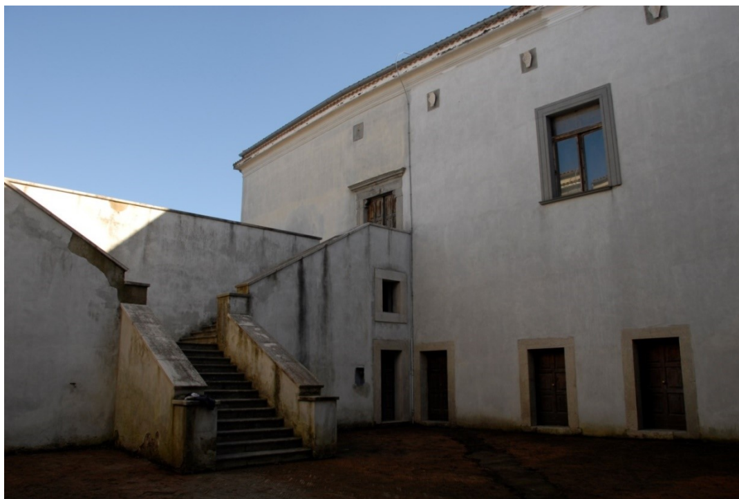
Fig. 4.2.8 – La scala a tre rampe posta sul fondo del cortile d'onore
