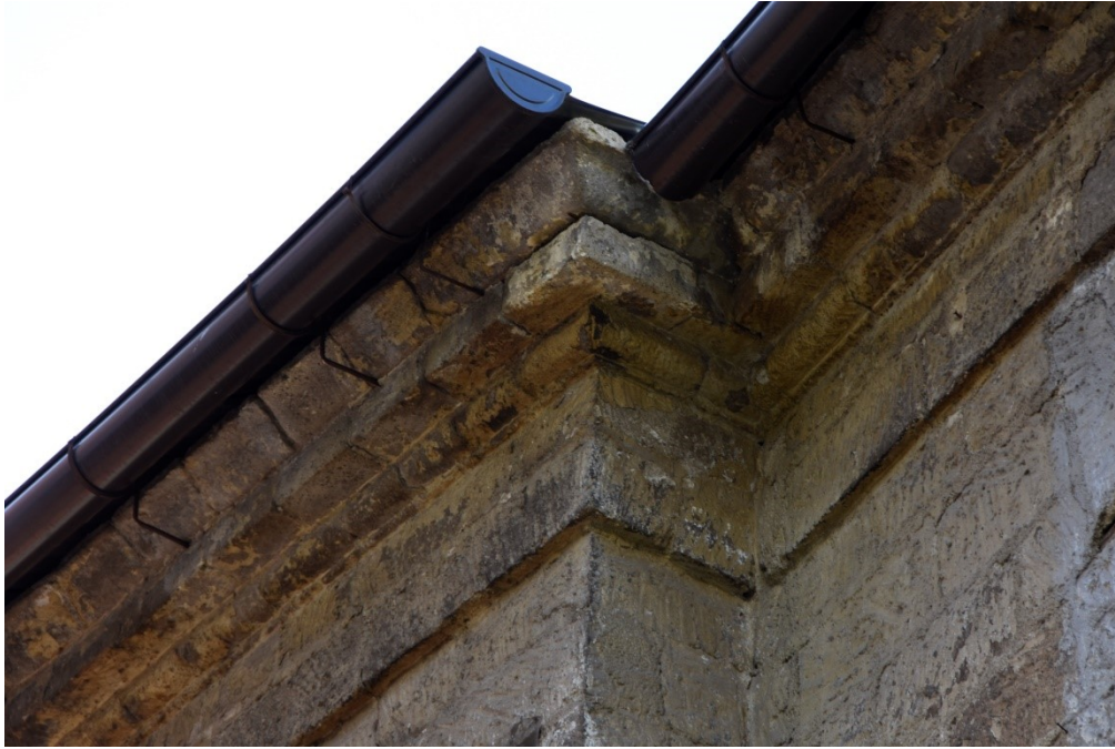
Fig. 4.3.36 – Particolare dell'aggetto della linea di gronda realizzato con blocchi di tufo sagomati
