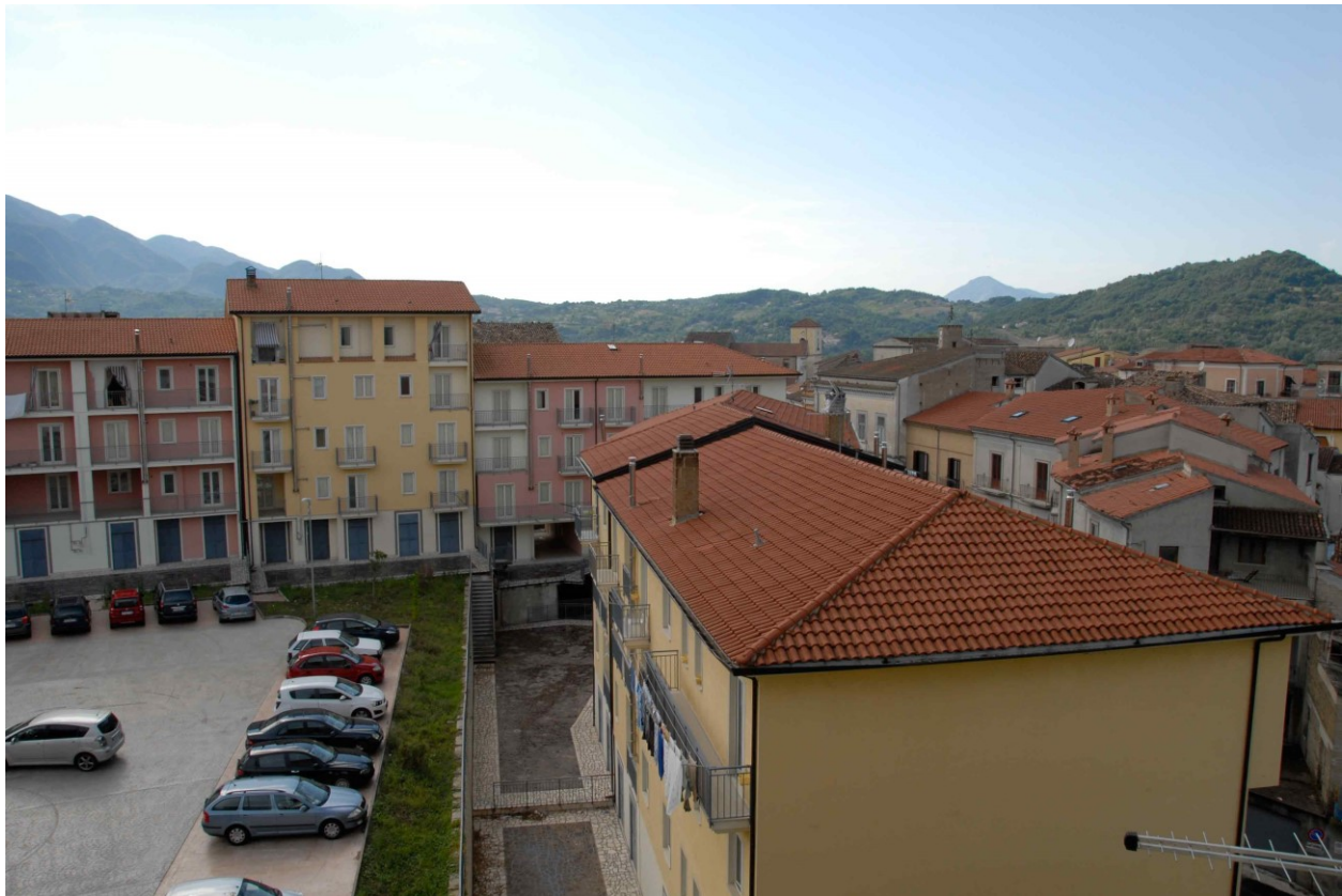
Fig. 4.4.7 – I fronti posteriori degli attuali condomini, affacciati sull'area del parcheggio
