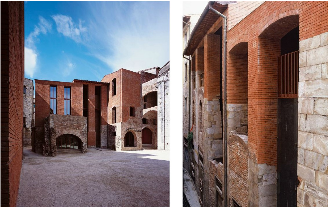
Fig. 3.4.11 – Il blocco Sud visto dalla piazza interna ed uno scorcio lungo Via Vernagalli
