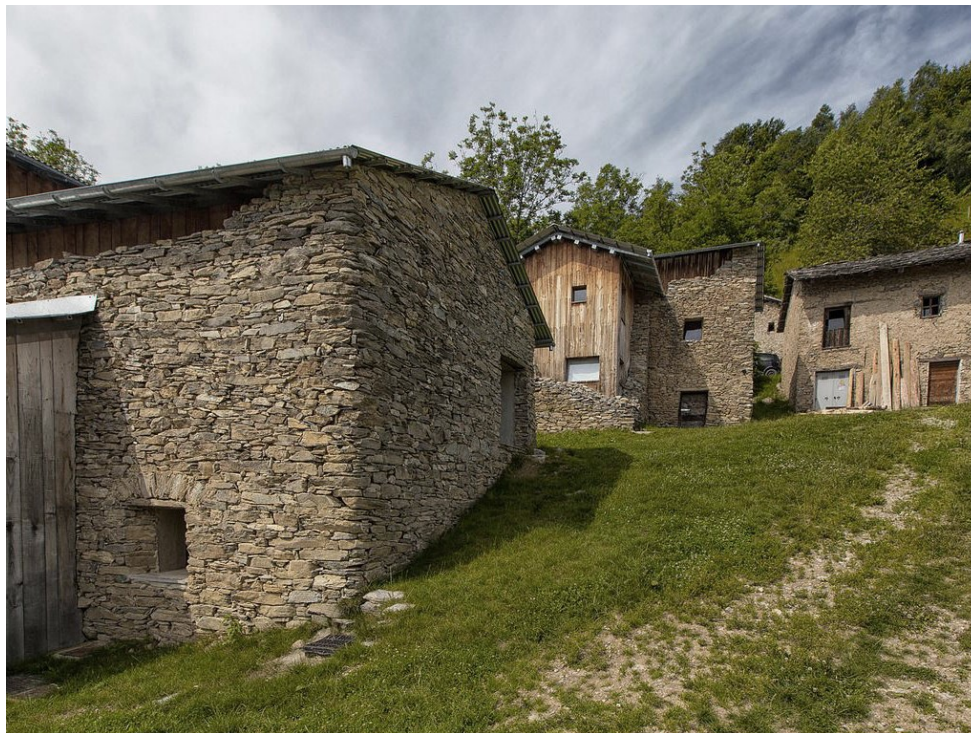
Fig. 3.3.8 – Una veduta dei tre fabbricati che compongono il primo lotto del progetto di recupero
