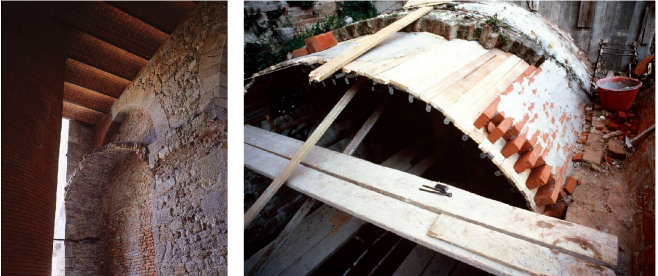
Fig. 3.4.10 – Uno dei nuovi solai in putrelle d'acciaio e voltine di laterizio e la ricostruzione di una volta originale parzialmente crollata
