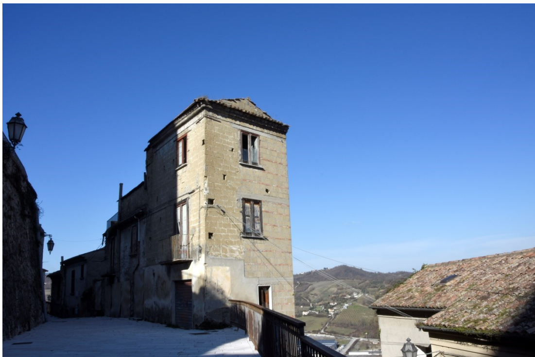
Fig. 4.5.5 – Il fabbricato visto da Sud-est
