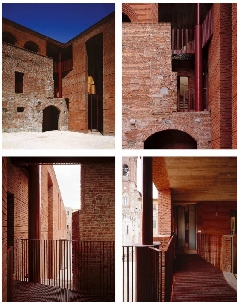
Fig. 3.4.8 – La loggia di distribuzione sviluppata nell'angolo Nord-est
