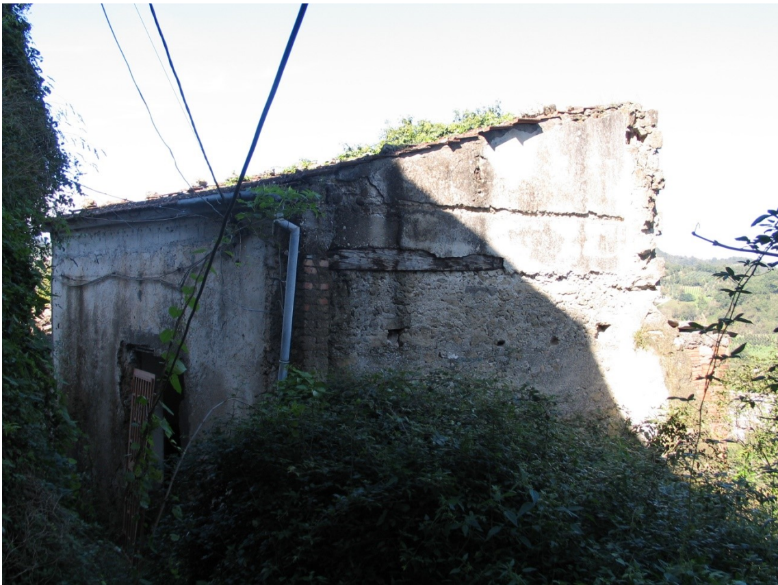
Fig. 4.5.18 – Uno dei volumi superstiti fra quelli interessati dai crolli
