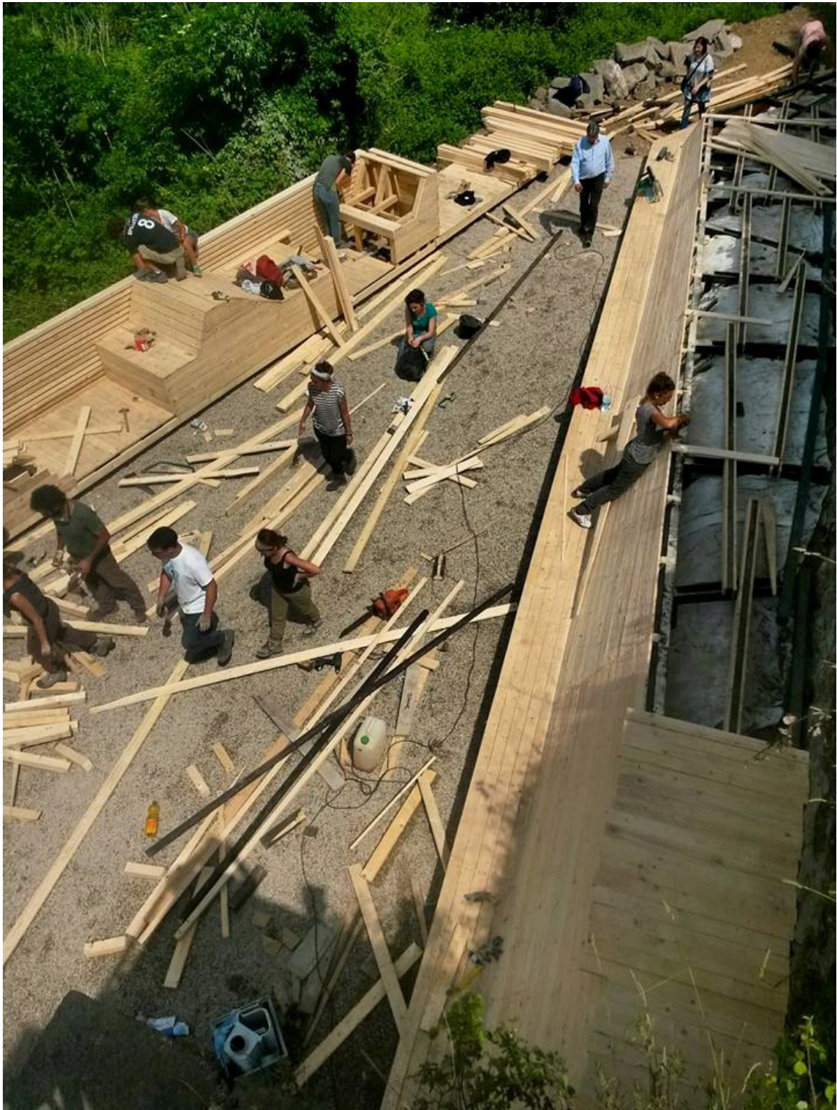
Fig. 4.4.8 – Il cantiere allestito durante il workshop di autoconstruzione
