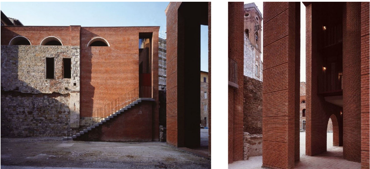
Fig. 3.4.12 – Lo spazio inedito lasciato nell'angolo Sud-est e la piazza vista attraverso i vuoti nei volumi riedificati
