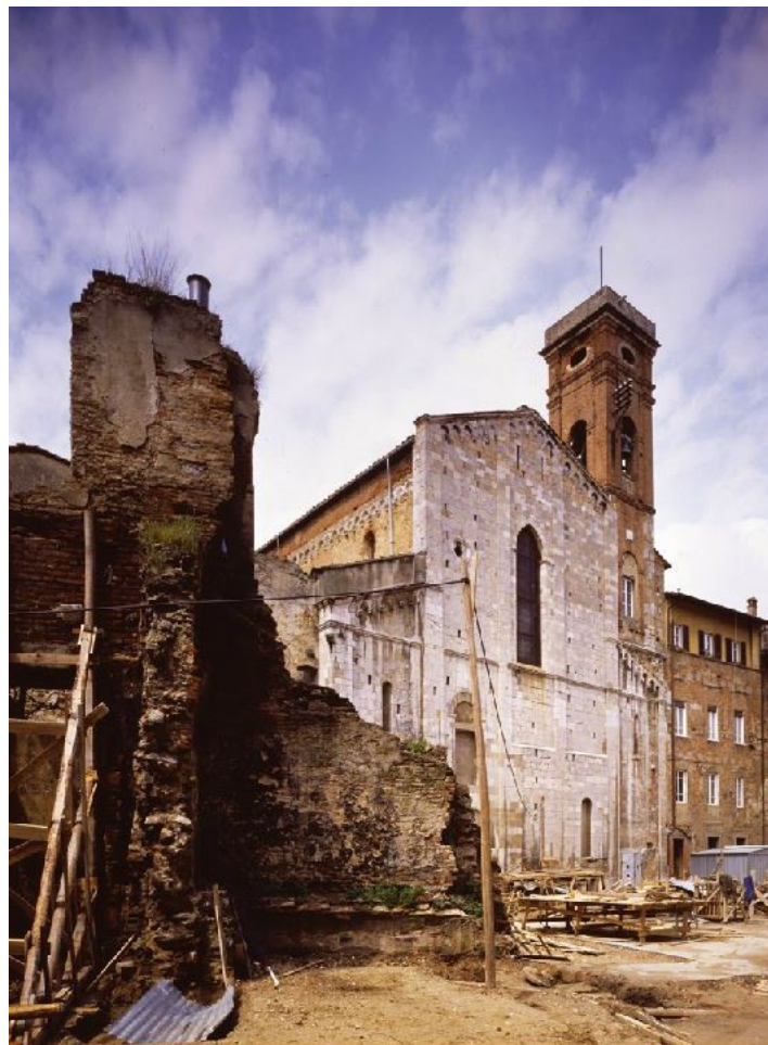
Fig. 3.4.3 – Il fronte absidale della chiesa durante le fasi di cantiere
