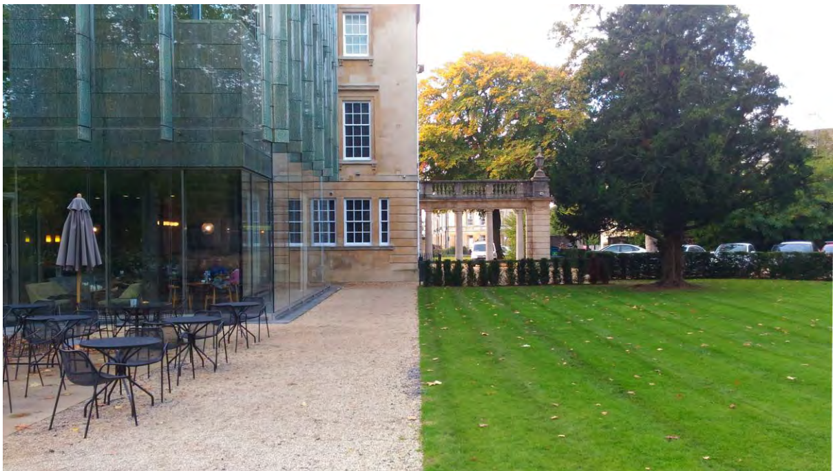
Fig. 4. Holburne Museum, veduta dal giardino retrostante
