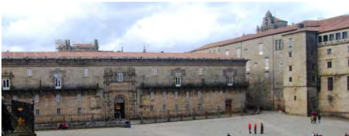
Facciata del Parador di Santiago de Compostela
