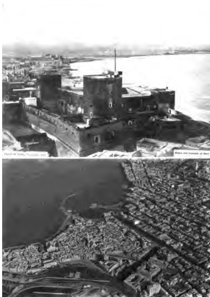
Fig. 4. Le relazioni del Castello con il contesto urbano. In alto, una foto d'epoca che testimonia l'affaccio diretto del Castello sul mare; in basso, il rapporto con la costa mediato dalla realizzazione delle banchine del porto e la relazione con il resto del tessuto urbano (Archivio fotografico Soprintendenza ABAP Città metropolitana di Bari e Fondo Ficarelli-Archivio di Stato di Bari)
