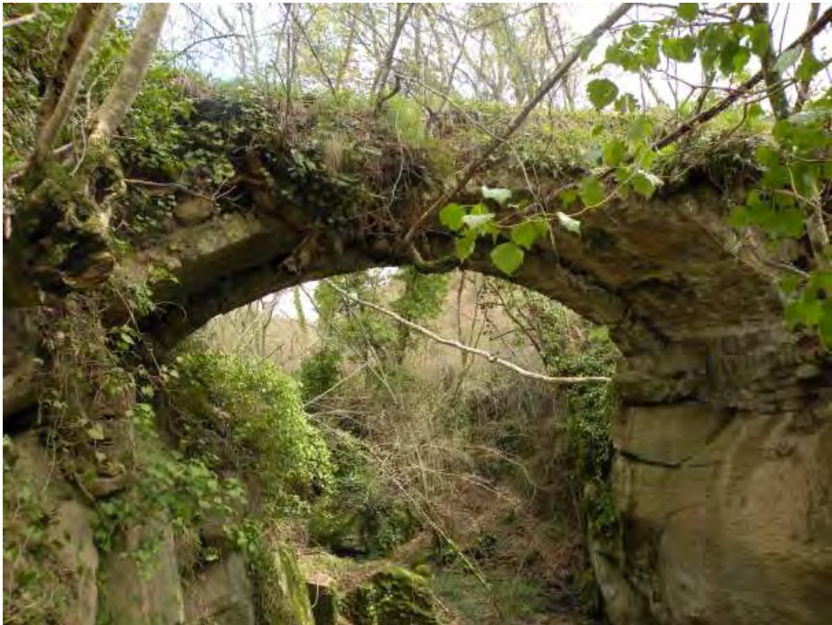
Fig. 2: I resti tardomedievali del cosiddetto Ponte Capello in loc. Macchia dell’Ospedale (veduta da Nord-Ovest)
