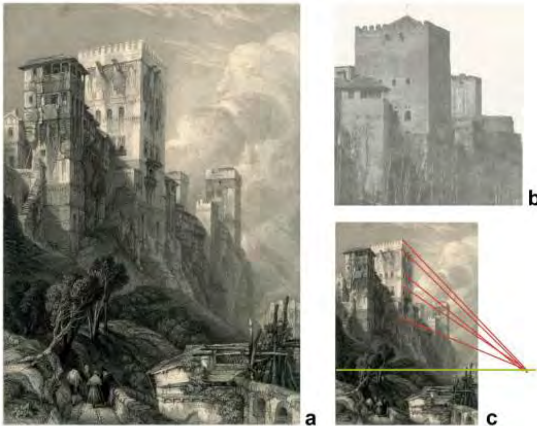
Fig. 1. a. David Roberts, Torre de Comares , 1835. b. Fotografia dell'inizio del secolo XX che evidenzia l'uso alterato delle scale. c. Effetto di prospettiva forzata.
