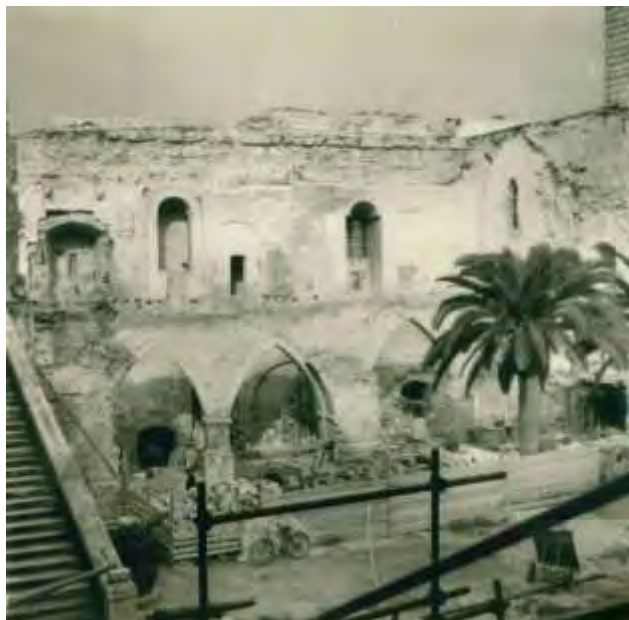
Fig. 1. Le stratificazioni del Castello: la foto del 1960 documenta gli ingenti interventi di restauro che hanno interessato l'ala nord con operazioni di cuci-scuci e rinvenimento delle arcate della loggia di età angioina che si affacciava nel cortile prima della regolarizzazione del rifacimento rinascimentale (Archivio fotografico Soprintendenza ABAP Città metropolitana di Bari)
