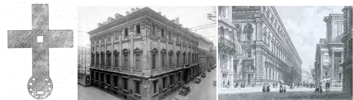
Da sinistra: Schema della cappella posta all'estremità sud della crociera dell'Ospedale di San Giovanni (da: J.G. Sulzer, Tagesbuch..op. cit. Fonte: Wikimedia Commons). Al centro: Palazzo Argentero, poi Perrone di San Martino, prima dei lavori di ristrutturazione (1929 c.a); G. B. Maggi, Palazzo dell'Accademia delle Scienze Torino, 1853 (Fonte: Wikimedia Commons)
