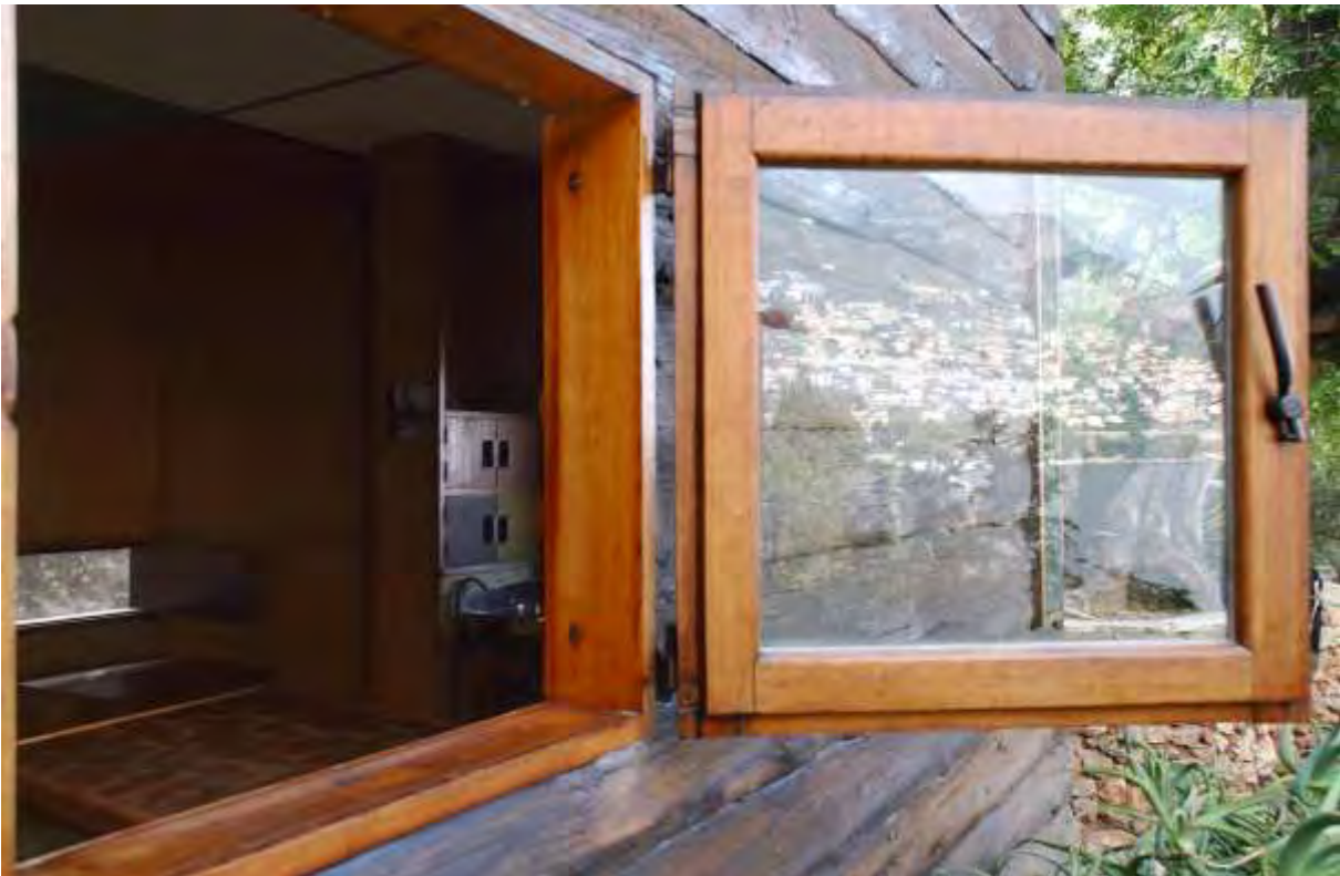
Le Corbusier, Le cabanon, Roquebrune – Cap-Martin, 1951 (fotografia © Paolo Rosselli)
