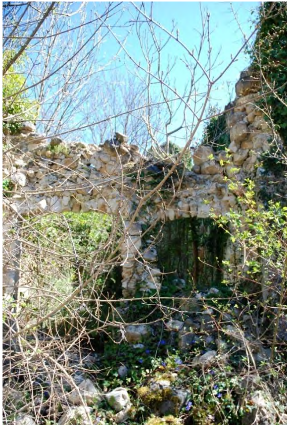
Fig. 2. Resti della chiesa di Sant'Antonio, situata ai piedi dell'abitato di Acciano, a pochi metri dal fiume Aterno (foto F.B.G.)
