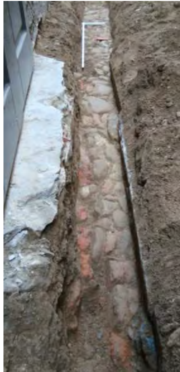
Fig. 2: parte della strada acciottolata rinvenuta in vicolo del Tidi; si vedono le scialbature di malta e i risarcimenti con scisti e laterizi che ne attestano il lungo utilizzo
