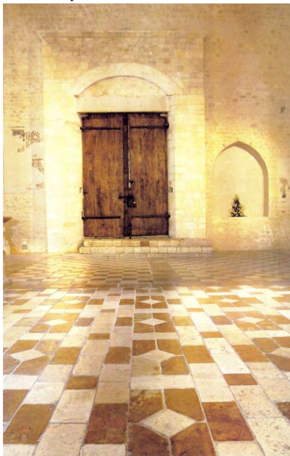
Porta Santa attuale, vista dall'interno, con pavimento dicromo a motivi cruciformi simili a quelli della facciata (secondo quarto del sec. XV). Da notare la dissimetria della gradinata preesistente rispetto alla porta; da: Pezzuti, "Celestino V e la sua basilica", cit., p. 168
