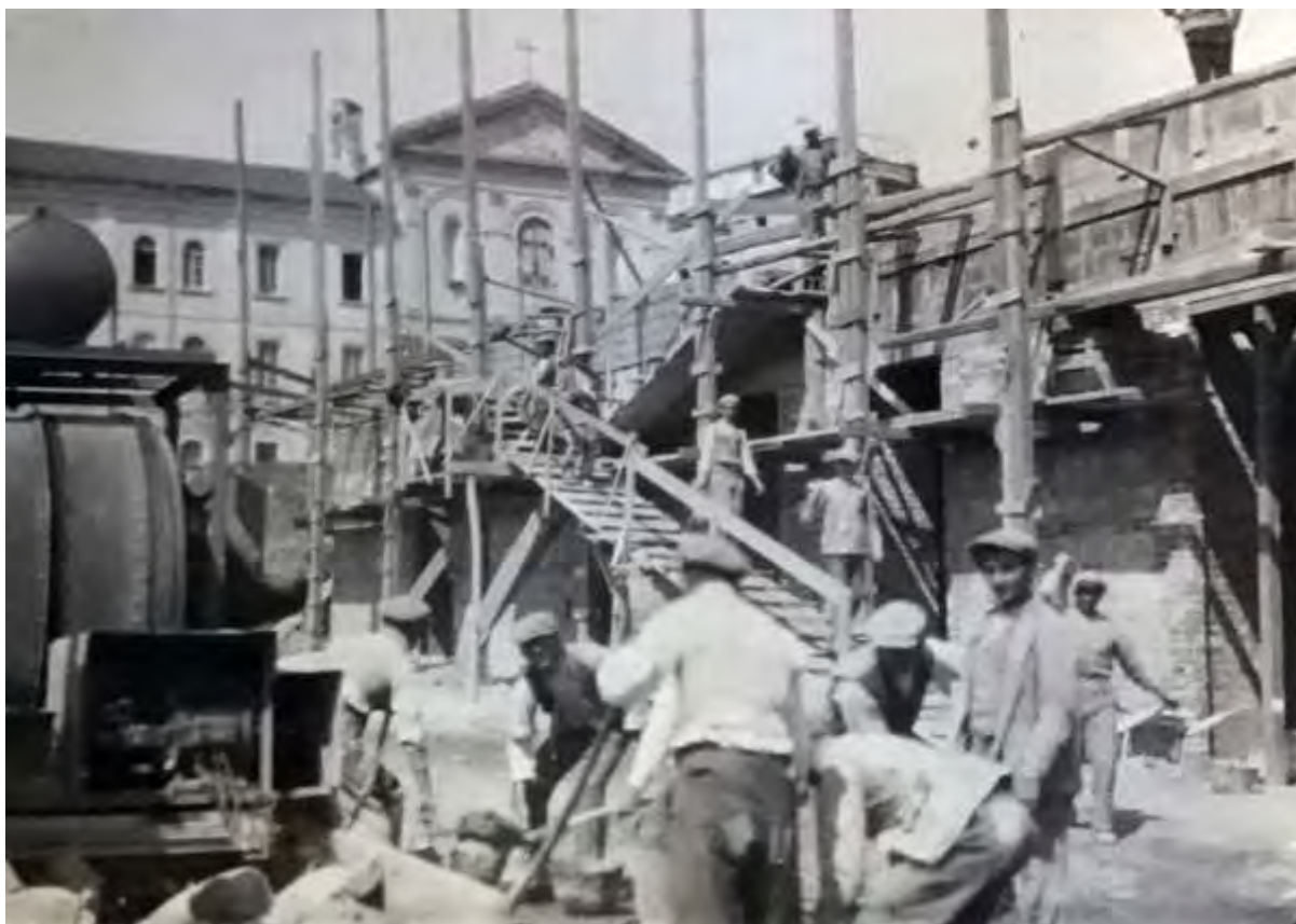
Salerno, cantiere per la costruzione del Liceo Tasso su progetto di Michele e Luigi De Angelis.
