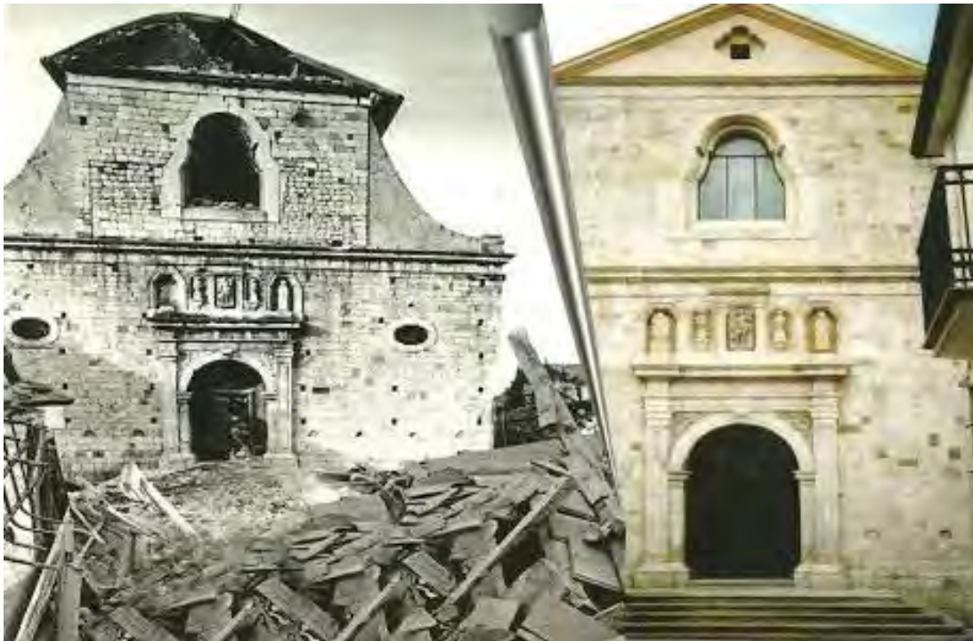
5: La Cattedrale di S. Angelo dei Lombardi (AV) prima e dopo gli interventi di restauro.
