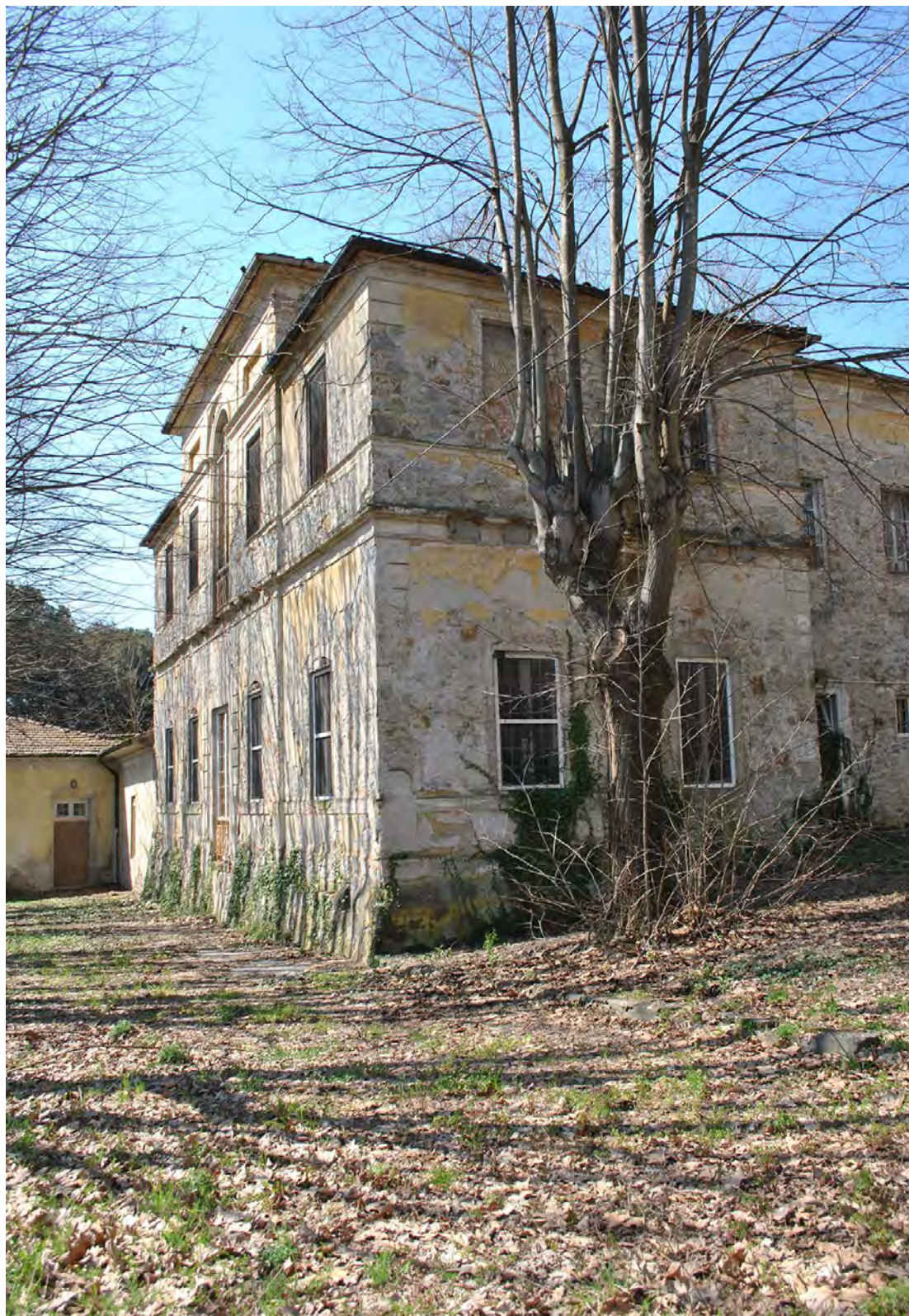
4: Testata di una delle ali destinate a dormitorio
