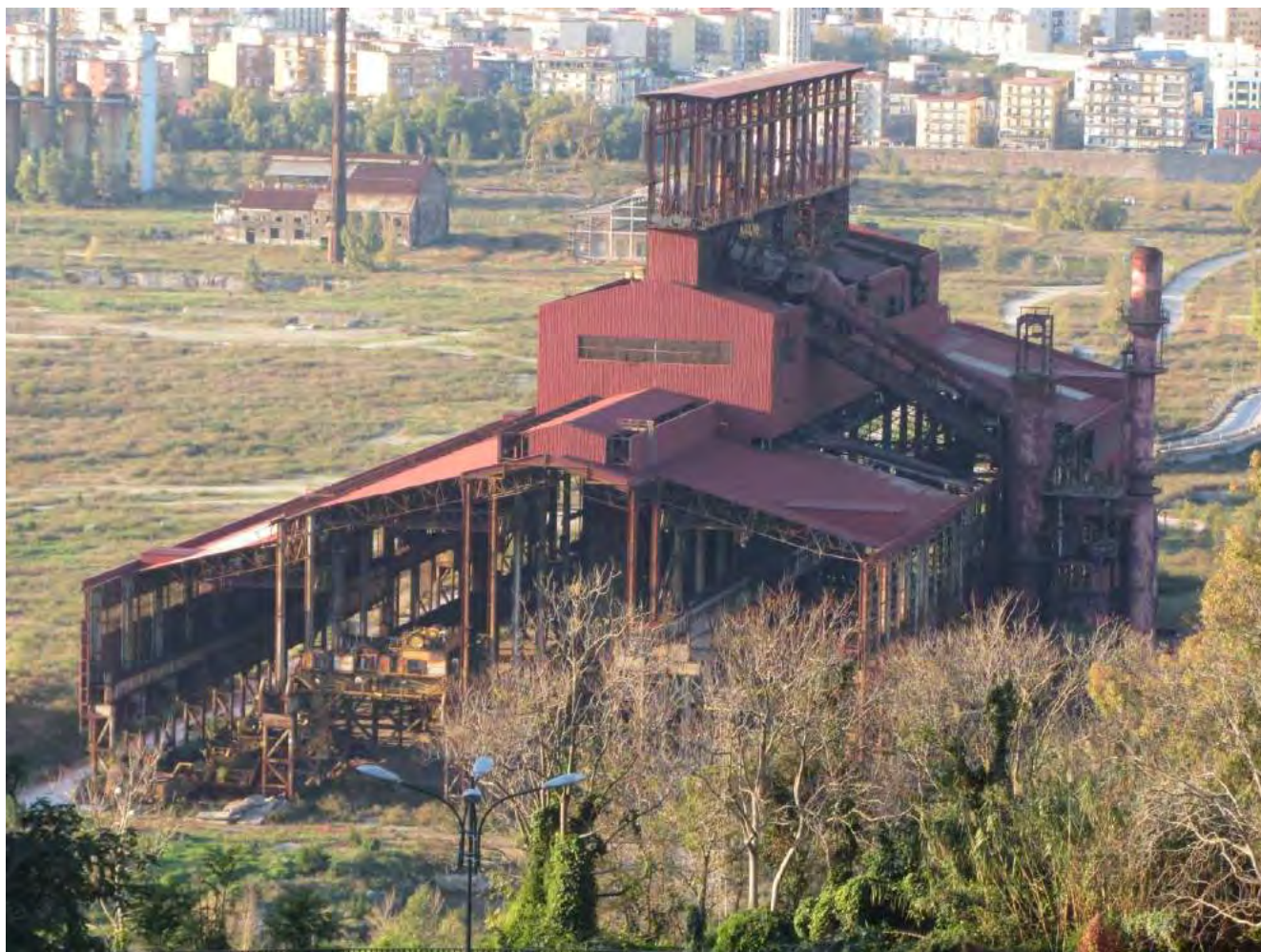
2 – L'altoforno dell'Ilva, oggetto di vincolo da parte della Soprintendenza, quale testimonianza di archeologia industriale, 2018.
