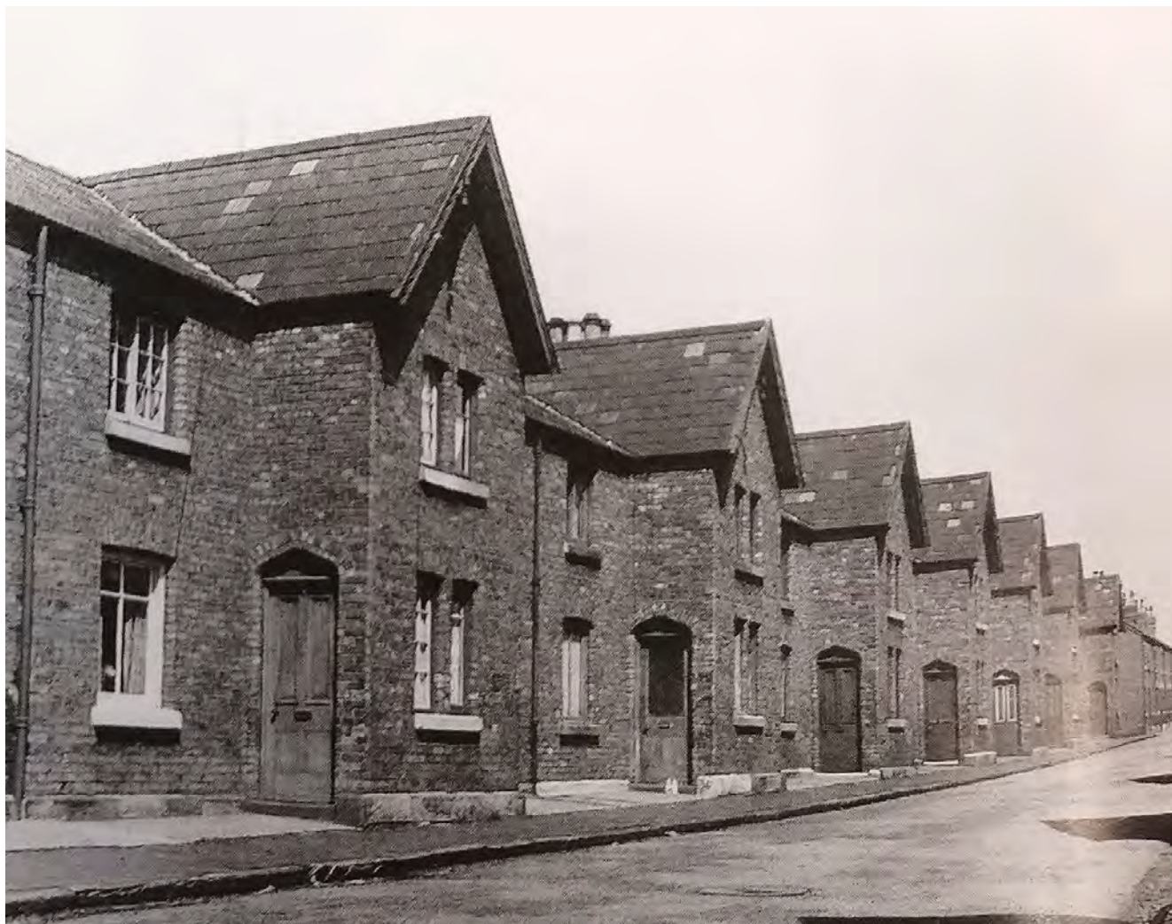
4: Cottages per operai, caposquadra, a Charles Street, Crewe, oggi demoliti (Baker 2005).
