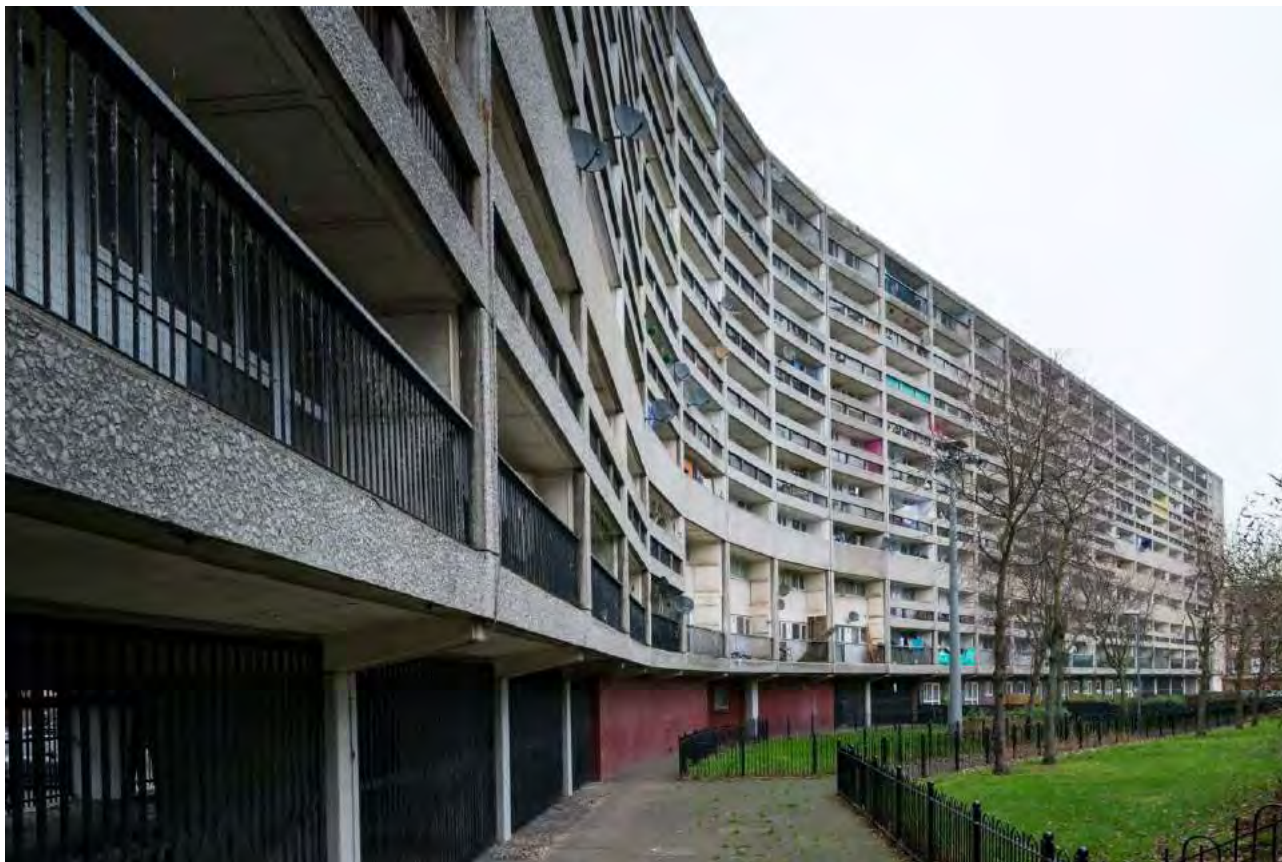
3: Il Cables Wynd House, noto come Banana Flat, oggi.
