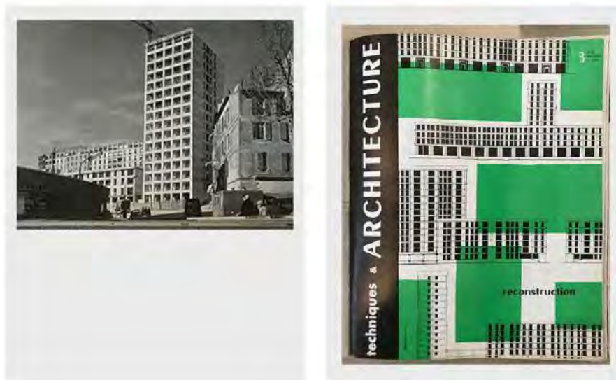
4: Fotografia durante la costruzione del complesso de La Tourette tratta da Marseille. Groupe d'habitations de la Tourette, in "Techniques et architecture", s. 16, n. 3, 1956, pp. 87-88; copertina della stessa rivista che riporta tutti i prospetti del progetto di Pouillon al Vieux-Port.
