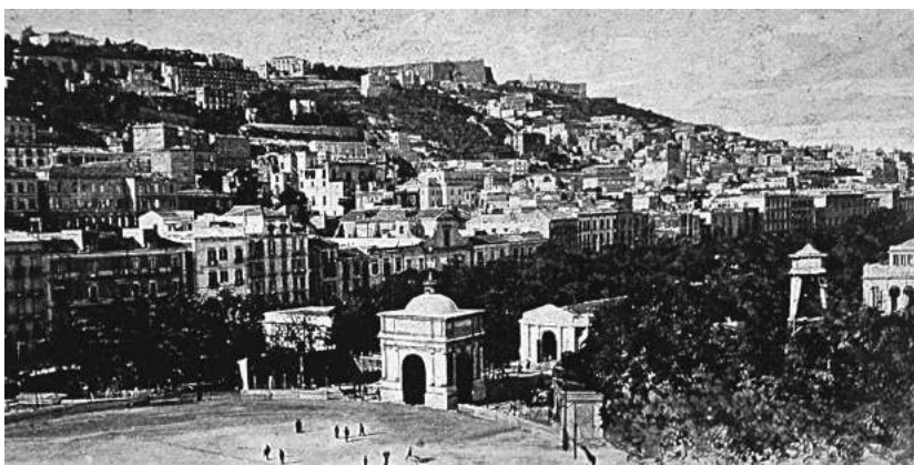
4: Foto di G. Amato, vista della Villa Nazionale e dei Padiglioni dell'Esposizione d'Igiene dall'attuale piazza della Repubblica. In primo piano il Padiglione di Benevento, l'ingresso dal lato ovest, progettato dall'arch. A. Meomartini.
