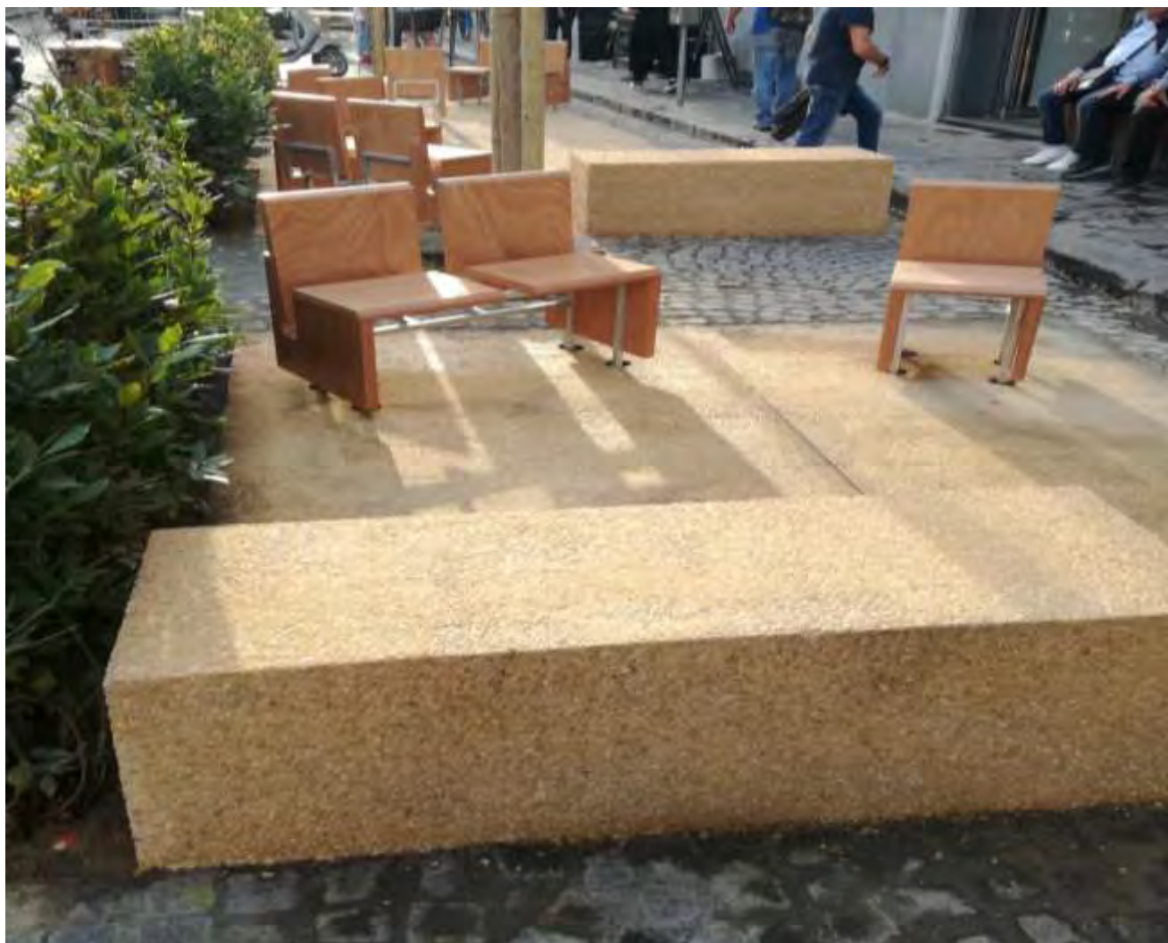
3: nuova sistemazione di via Sanità a Napoli ultimata, maggio 2018 (foto di Nicola Flora).
