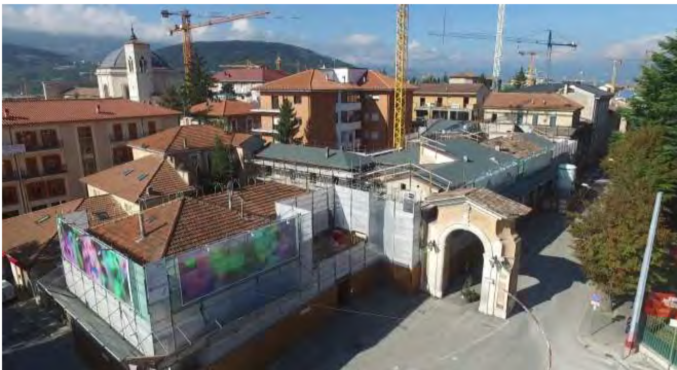
1: L'Aquila, porta Castello: il paesaggio urbano è caratterizzato dalla presenza dei cantieri per la ricostruzione post-sisma.
