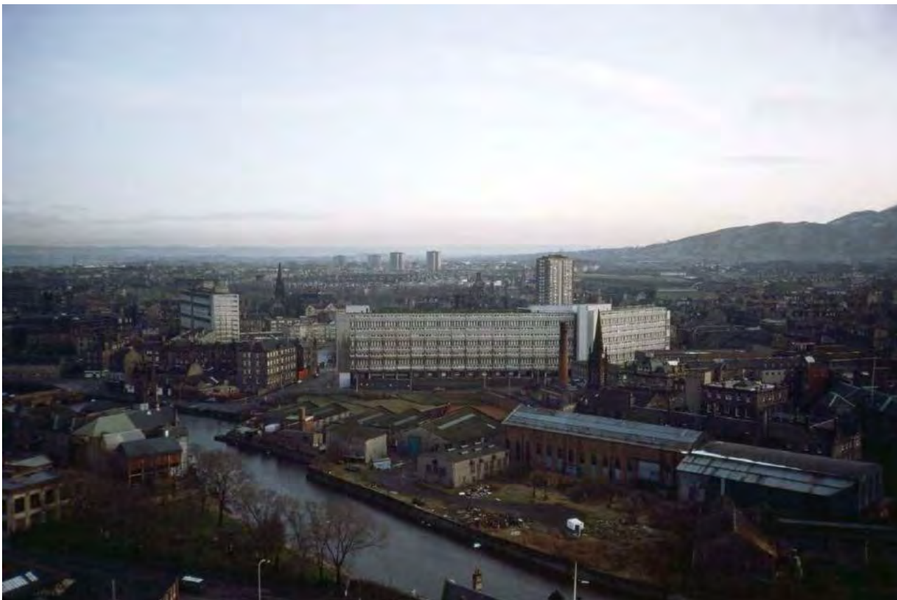
2: Il quartiere di Leith, con l'omonimo fiume ed il Cables Wynd House in primo piano durante gli anni '80.
