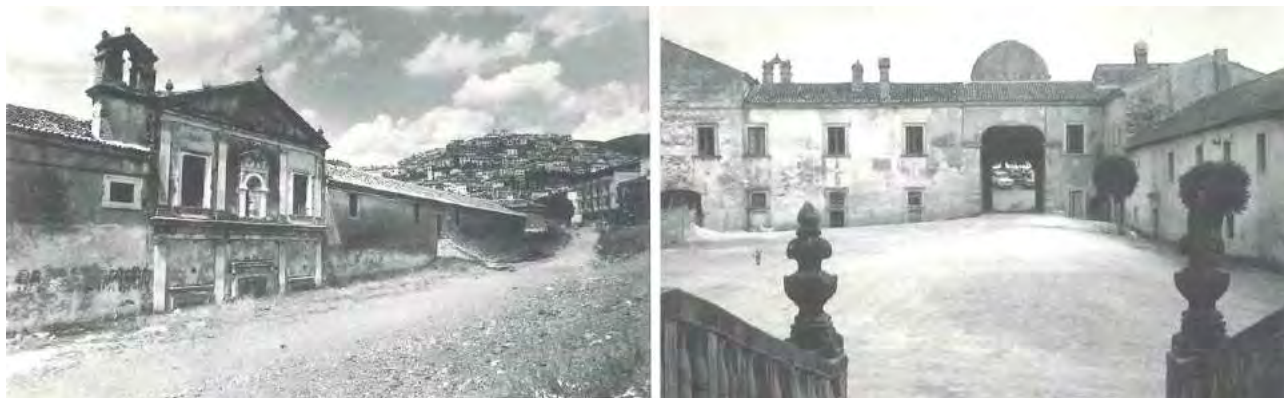
3: Fotografie del muro di cinta e della corte esterna del monastero di Padula nell'Ottocento. Allontanati definitivamente i monaci certosini dalla propria Casa, anche l'azione feudale di controllo sul territorio venne meno, facendo emergere nuovamente il problema dello straripamento del torrente Fabbriato, un piccolo affluente del fiume Tanagro che corre parallelo all'ingresso della Certosa.
