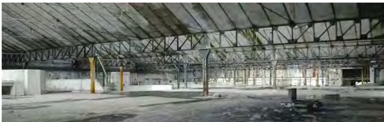
1: Interni della ex fabbrica di ceramiche Richard-Ginori di via Tucidite a Milano. Foto di Rui Miguel Roda Ferreira (2005).
