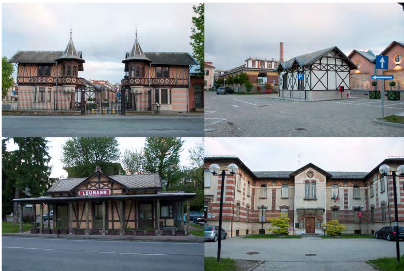
4: Stato attuale delle istituzioni sociali e dei servizi. In alto: ingresso della borgata e ambulatorio medico-chirurgico; in basso: la stazione ferroviaria e il convitto per le operaie [Federico Rizzo, 2018].
