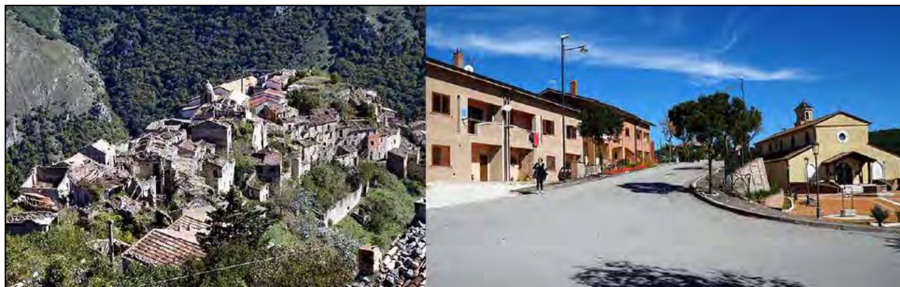
5: A sinistra i ruderi del vecchio paese di Romagnano al Monte semi-distrutto dal terremoto del 1980, a destra la Chiesa con parte del nuovo insediamento abitativo (Foto E. Spiga, 2016).
