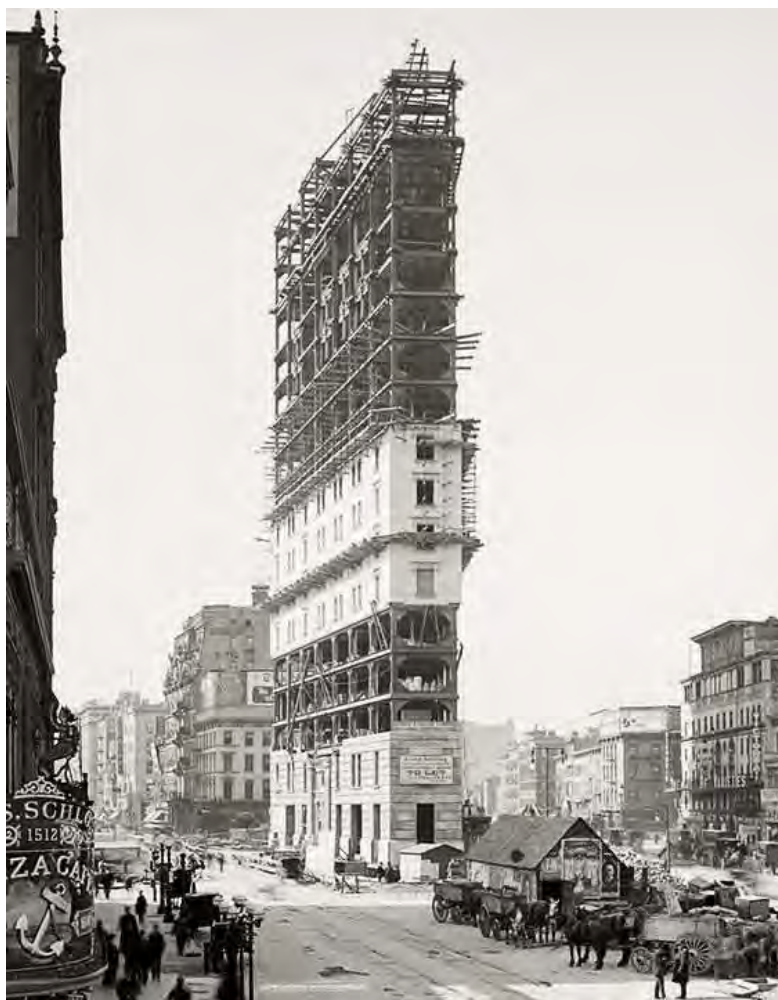
2: Times Building, in fase di costruzione, New York, 1904.
