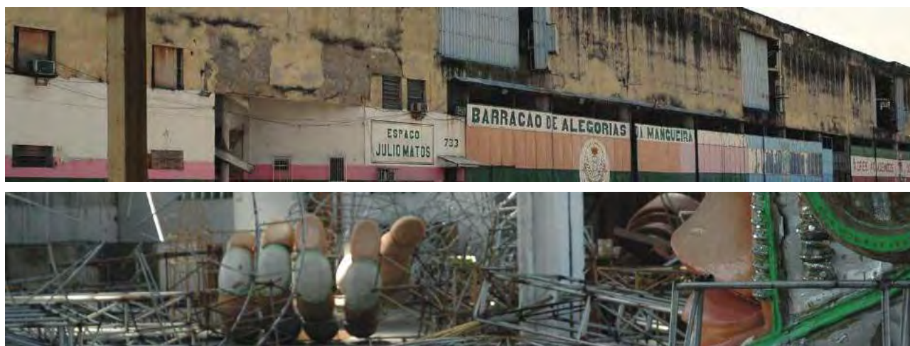
3: Magazzini dismessi nelle aree del porto vecchio di Rio de Janeiro. Foto di Rui Miguel Roda Ferreira (2005).
