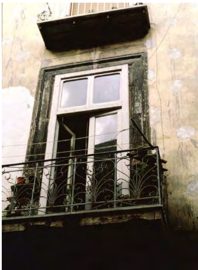
3: Nola, via Marciano, finestra rinascimentale trasformata in balcone (foto di Saverio Carillo, 2017).
