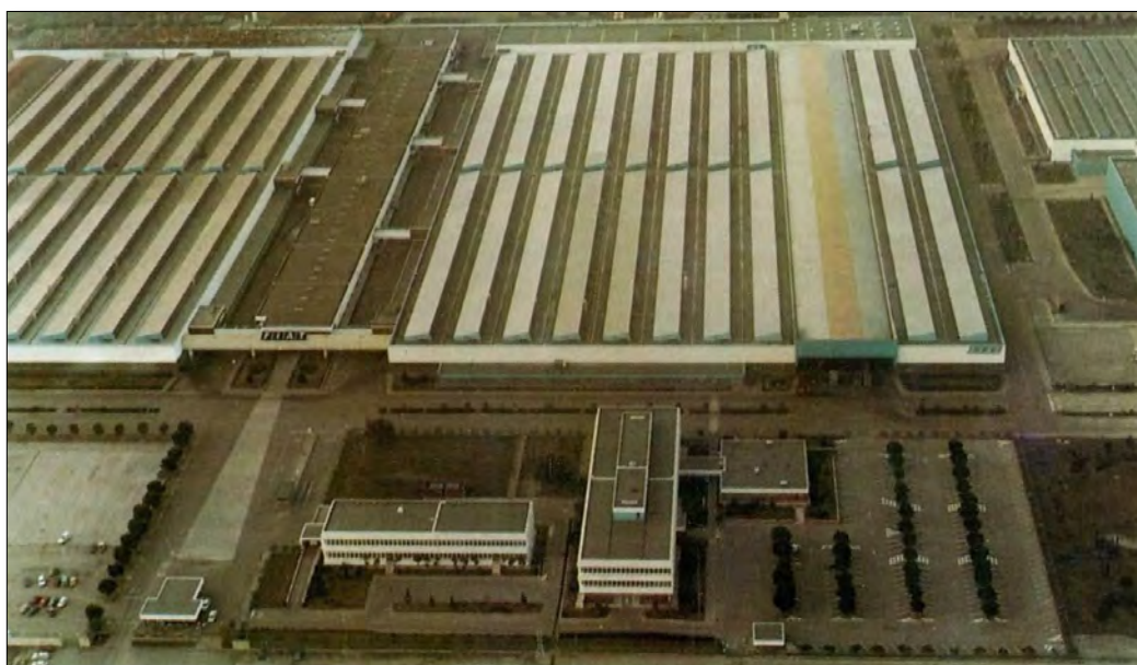
2: Termoli, Impianto della Fiat (Il patrimonio industriale in Molise 2012, 233).
