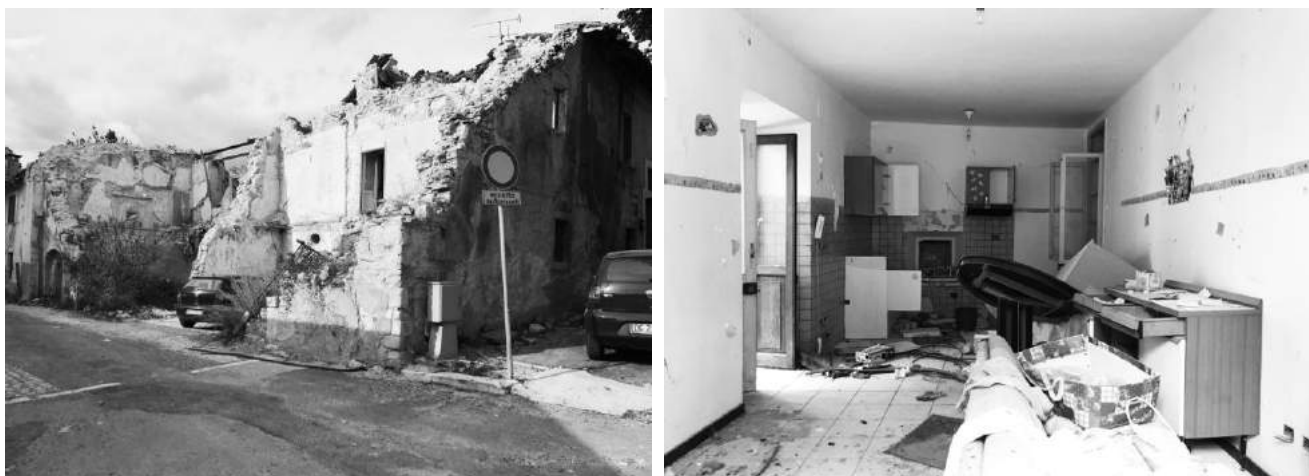
2: Abitazioni allo stato di rovina sul perimetro del centro storico, fotografia di Cristiano Tosco (24/09/2017).
