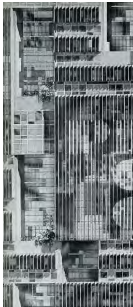
3: Grattacielo Peugeot, particolare della facciata (Maurizio Sacripanti, Buenos Aires, 1961).
