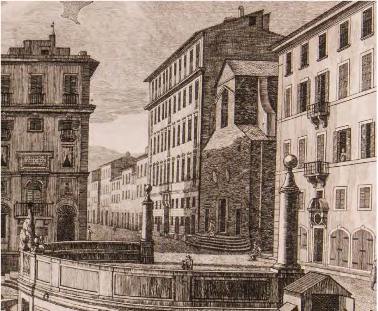
3: Agostino Penna, Porto di Ripetta , 1829, (Roma, Biblioteca di Archeologia e Storia dell'arte, Fondo Lanciani, Roma XI.2.15), dettaglio; accanto alla Chiesa di San Rocco è visibile il prospetto del nuovo casamento, rialzato di un piano nei primi anni del XIX secolo.
