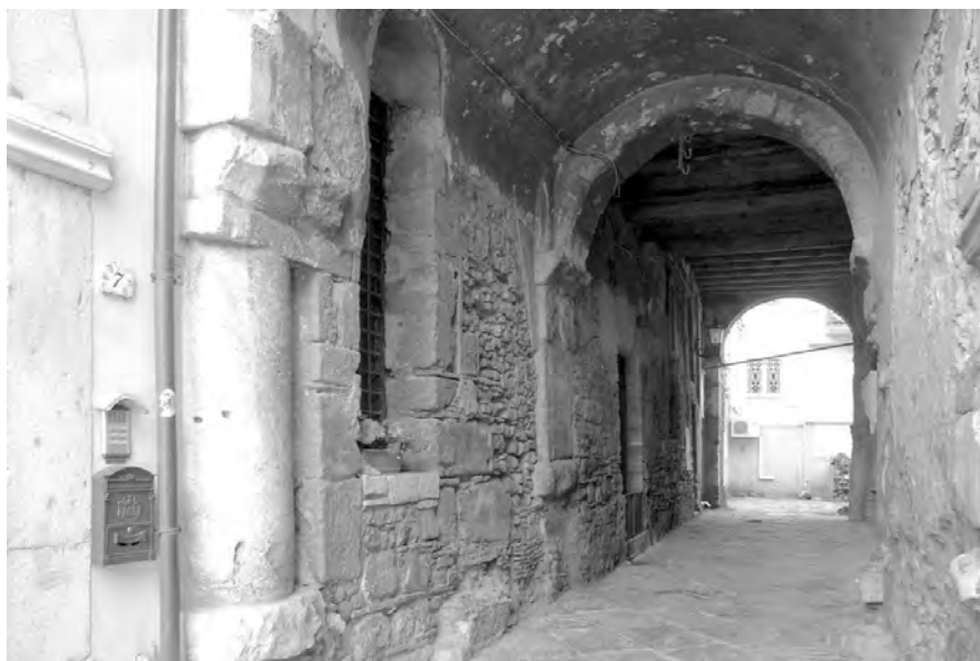
Fig. 4. Benevento, Via San Gennaro, sulla sinistra resti di edificio abitativo databile al IX secolo.
