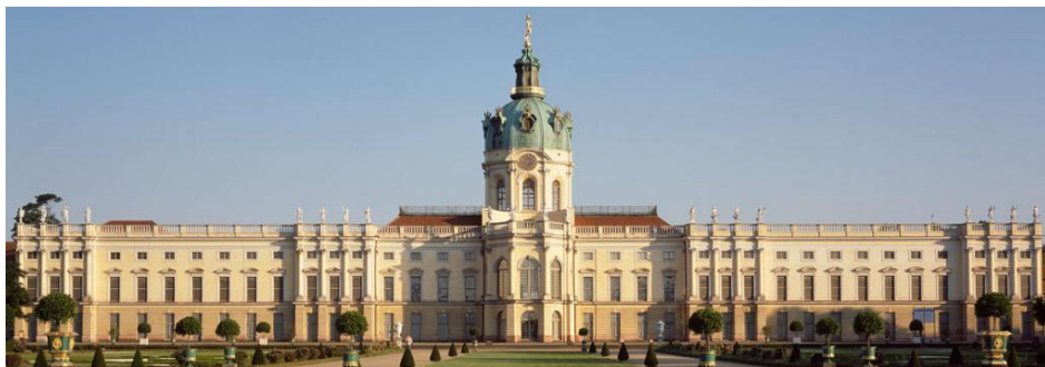
Fig.3 - Veduta del fronte del Castello di Charlottenburg che prospetta sul giardino (lato "privato"); si notano le quattro semicolonne su ciascuno dei quattro corpi "avanzati" dell'architettura. L'alto volume centrale rappresenta un elemento urbano che caratterizza il paesaggio del quartiere oggi come allora (foto: youtube.com)
