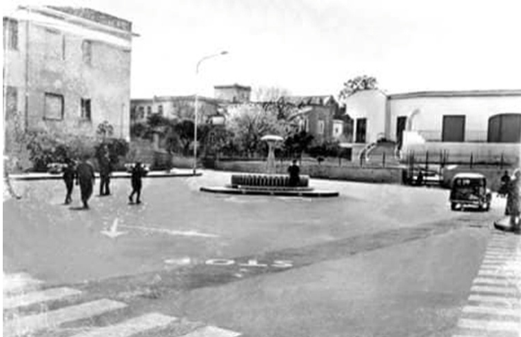
Fig.8 - Piazza Posta subito dopo la costruzione della 'strada nuova'
