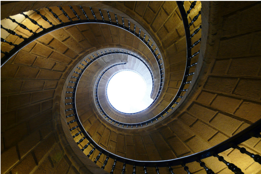
Figura 4.53: Vista dal basso della scala a tripla elica del Covento di San Domingos de Bonaval a Santiago de Compostela
