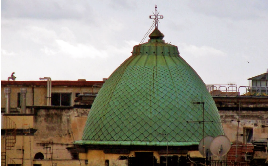
Figura 4.7: Ulteriore vista della cupola della Chiesa di Santa Maria di Monteverginella a Napoli
