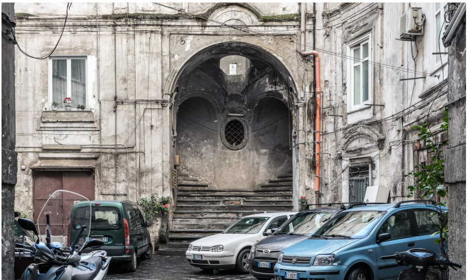
Figura 4.58: Ingresso della scala a doppia elica di Palazzo Sanfelice a Napoli
