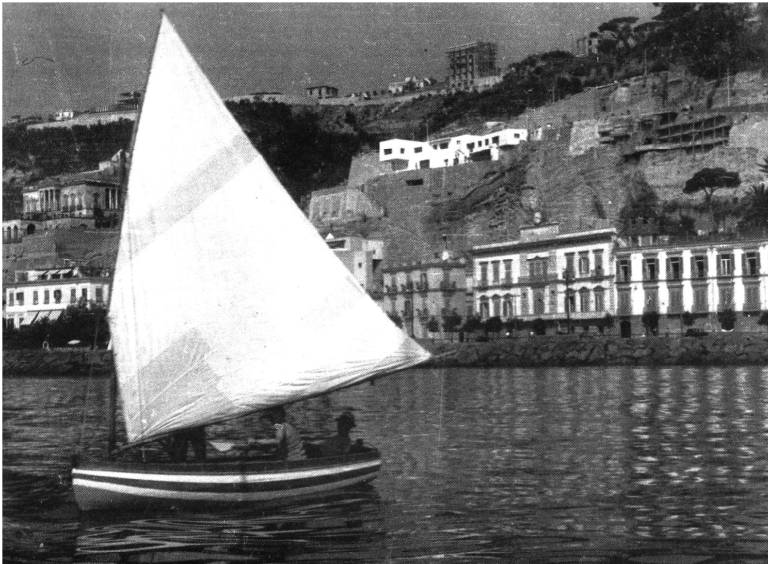
Villa Oro appena ultimata vista dal mare con in primo piano una piccola imbarcazione a vela. (Archivio Cosenza)
