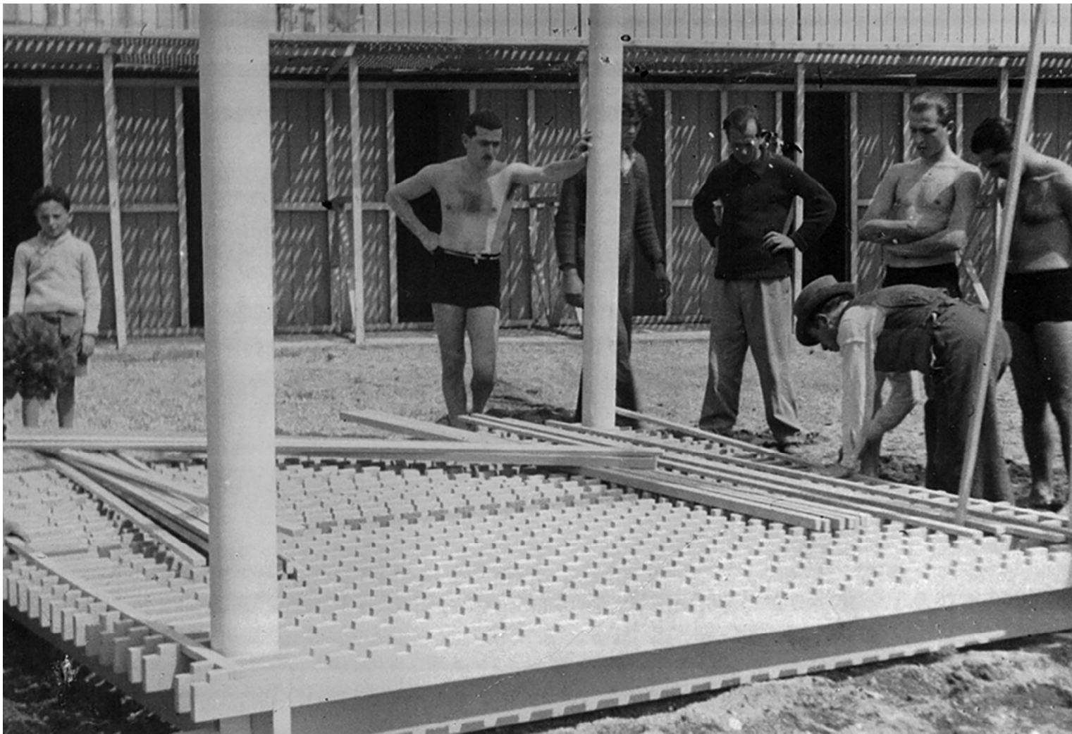
La cabina in fase di assemblaggio a Napoli. Si distingue la gerarchia degli assi di legno montati ad incastro che compongono l'impalcato di base. Luigi Cosenza, in costume da bagno al centro della foto, sovrintende ai lavori di montaggio. (Archivio Cosenza)
