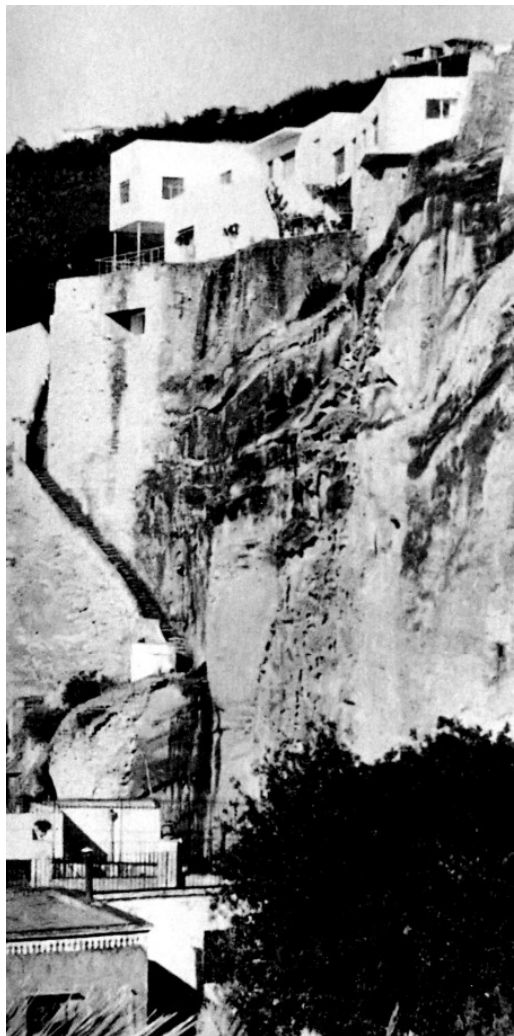
Villa Oro. Vista d'insieme dal basso del muraglione naturale di tufo su cui è situata. (Immagini tratte da "Domus", n. 120, dicembre 1937)
