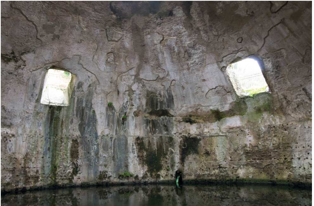
Fig. 5.2 - L'interno del frigidarium di Mercurio, indicato con il n.1.
