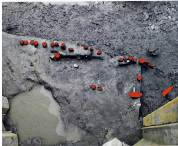
Figura 4. L'area della palificata di fondazione vista dall'alto: in rosso sono evidenziate le testate dei pali (da CAMILLI-SETARI 2005, p. 22).
