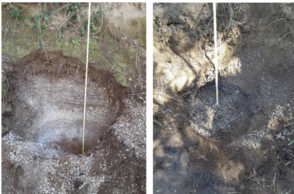
Figura 4.5. Esecuzione di pozzetti esplorativi.
