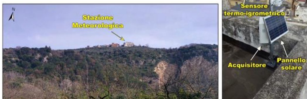
Figura 3.7. Ubicazione della stazione termo-igro-pluviometrica
