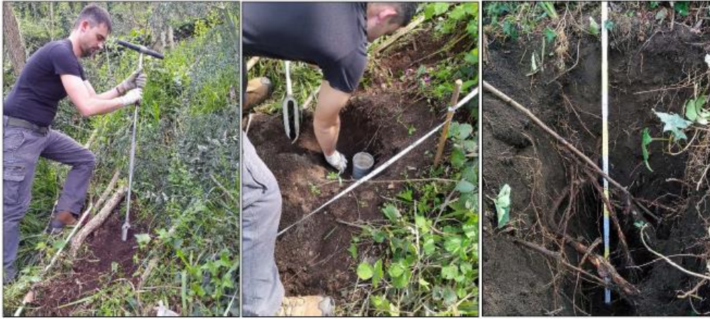
Figura 3.10. Esecuzione di indagini di campo per la realizzazione della stazione di monitoraggio idrologico.
