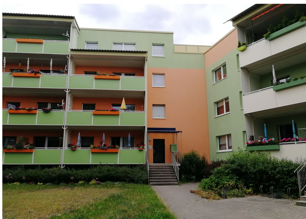
Fig. 12 Intervento di riqualificazione a Grünau con riconfigurazione dell'involucro, addizione di balconi e riduzione del numero di piani (foto dell'autore, 2019).
