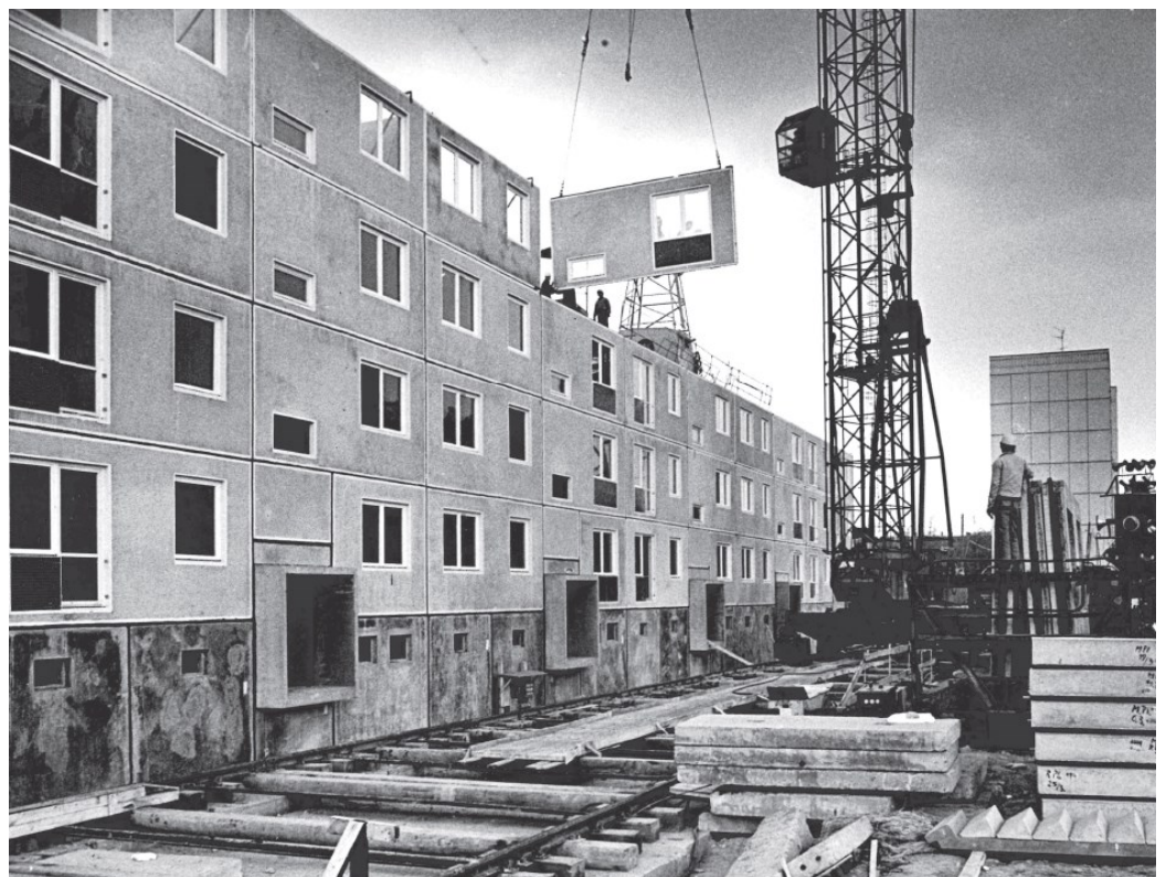
Fig. 9 Un edificio a 5 piani della serie WBS70 in fase di montaggio (LWB, 2018).
