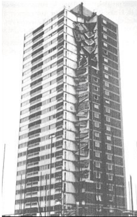
Fig. 13 In seguito al crollo parziale dell'edificio per civile abitazione, a struttura prevalentemente prefabbricata, avvenuto nel 1968 a Ronan Point, la comunità tecnico-scientifica internazionale intraprese studi sistematici sul fenomeno del collasso progressivo.
