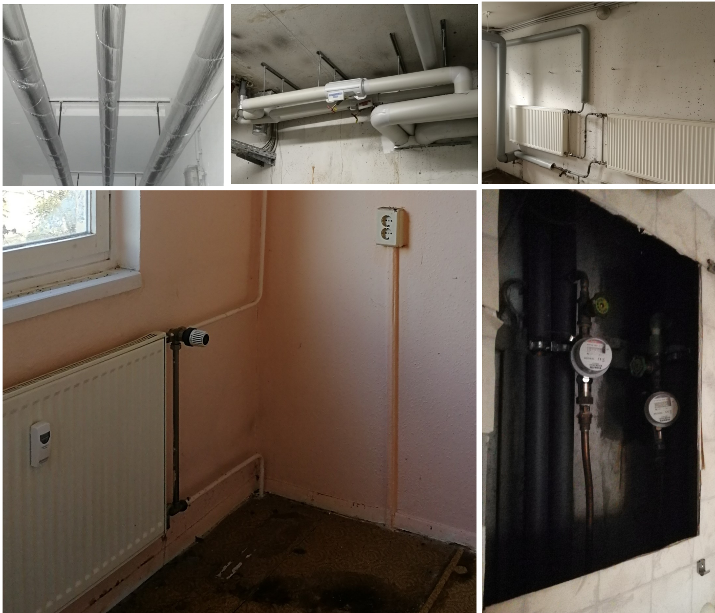
Fig. 36 Il rilievo fotografico è stato effettuato laddove possibile, nei pochi appartamenti ancora liberi e non ancora ristrutturati, nonché nel seminterrato. Si è rivelato di grande aiuto nel dettagliare gli elementi dei sistemi impiantistici, purtroppo non adeguatamente documentati né nel materiale a catalogo degli anni '70 né in quello relativo agli interventi effettuati negli anni '90 (foto dell'autore, 2018 | LWB, 1995).
