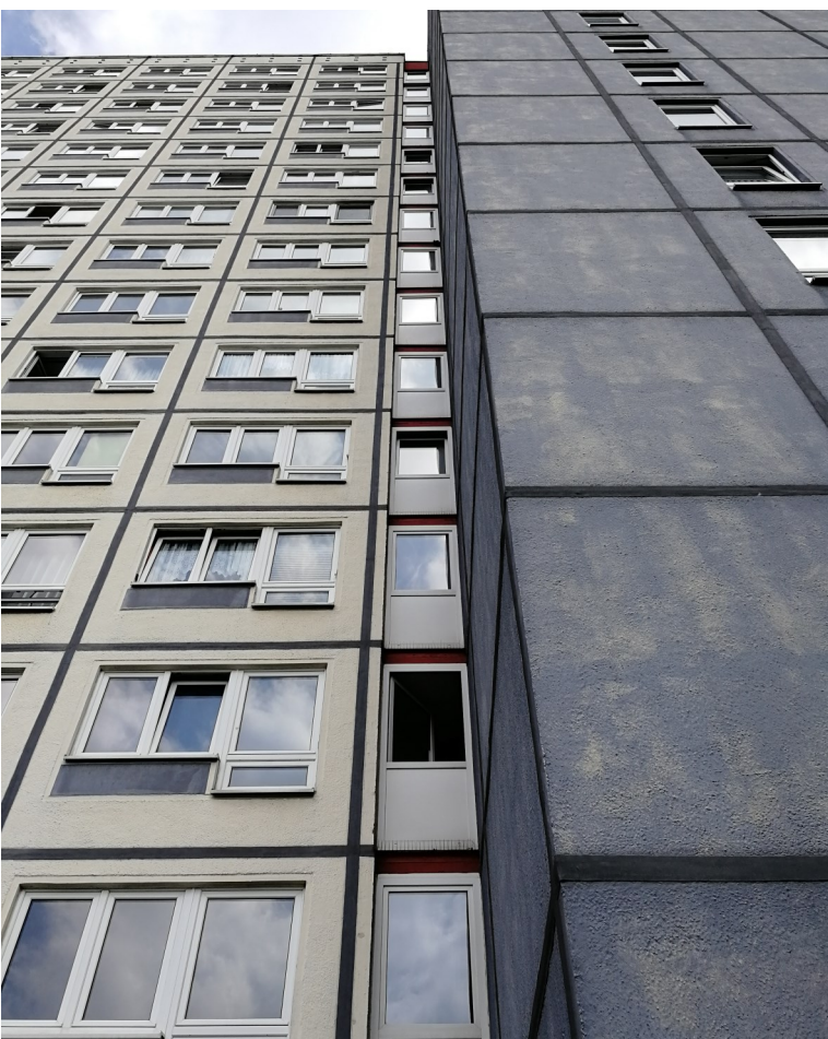
Fig. 22 Due PH 16 (torri di 16 piani) dopo gli interventi di riqualificazione degli anni '90 (sinistra) e dopo quelli degli anni 2000 (destra). Dopo aver sigillato i giunti, si procede con un isolamento a cappotto dell'intera facciata, nonché con la sostituzione degli infissi e del portone d'ingresso (foto dell'autore, 2019)
