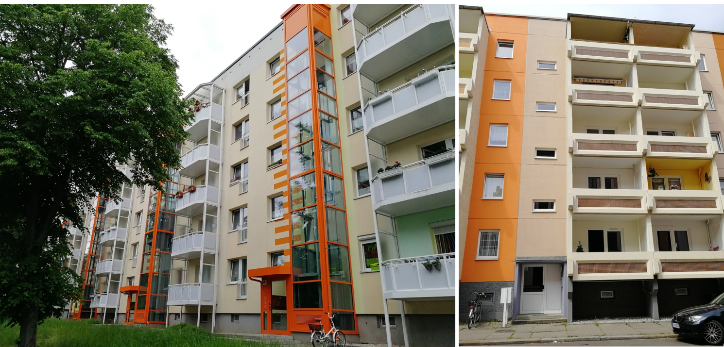
Fig. 11 Addizione di balconi e ascensori in facciata nel quartiere di Dolitz (sinistra) e riqualificazione della facciata e dei balconi esistenti nel quartiere di Neu - Paunsdorf (foto dell'autore, 2019).
