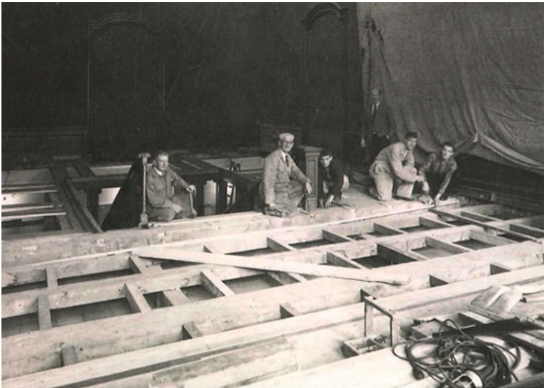
Fig. 3.34- L'intervento per il solaio del corpo scala, 1960. Q. Buvelot (a cura di), Mauritshuis. The building , Waanders Uitgevers, Zwolle, 2014-2015, p. 202.
