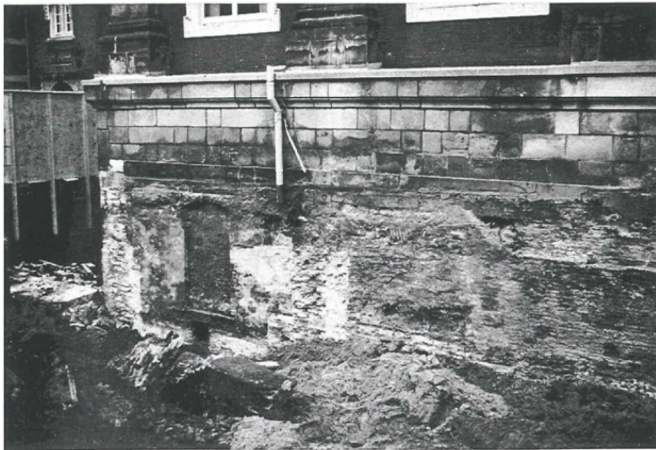
Fig. 3.38- Opere di scavo al di sotto della corteLo sbancamento della corte fece emergere le tracce dei passaggi al livello seminterrato. Nella foto il particolare del varco di sinistra, 1982 Foto RGD. - Agenzia per gli edifici governativi
