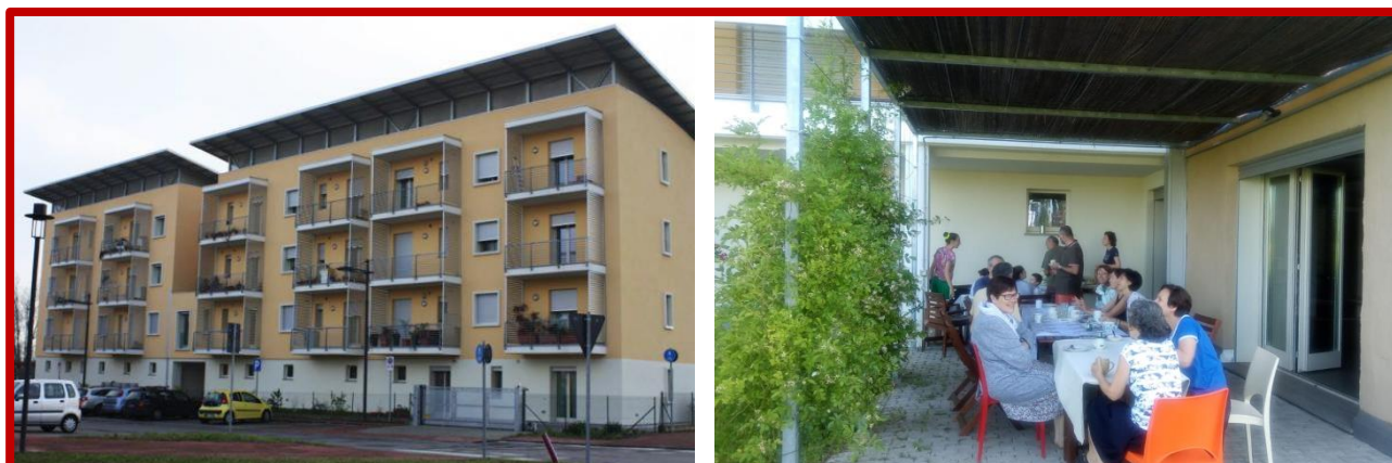
Fig.20. Edificio Ecosol, Fidenza (Parma) (Vista dell'esterno; Area pasto esterna). Il progetto Ecosol nasce nel 2006 grazie alla volontà di 13 famiglie di formare una comunità territoriale all'interno di un "condominio solidale". L'edificio, progettato in forma partecipata coi residenti, ospita famiglie molto diverse per età e composizione. Al suo interno trovano spazio alloggi interamente accessibili, aree di aggregazione e una scuola di autonomia per ragazzi bisognosi di accompagnamento. I tre pilastri di Ecosol sono la sostenibilità ambientale, la sostenibilità economica e la sostenibilità sociale. Quest'ultima, in particolare, è favorita dalle occasioni di comunicazione e scambio offerte dalle aree comuni e dalle attività regolarmente svolte al loro interno. Fonte: http://www.ecosol-fidenza.it .
