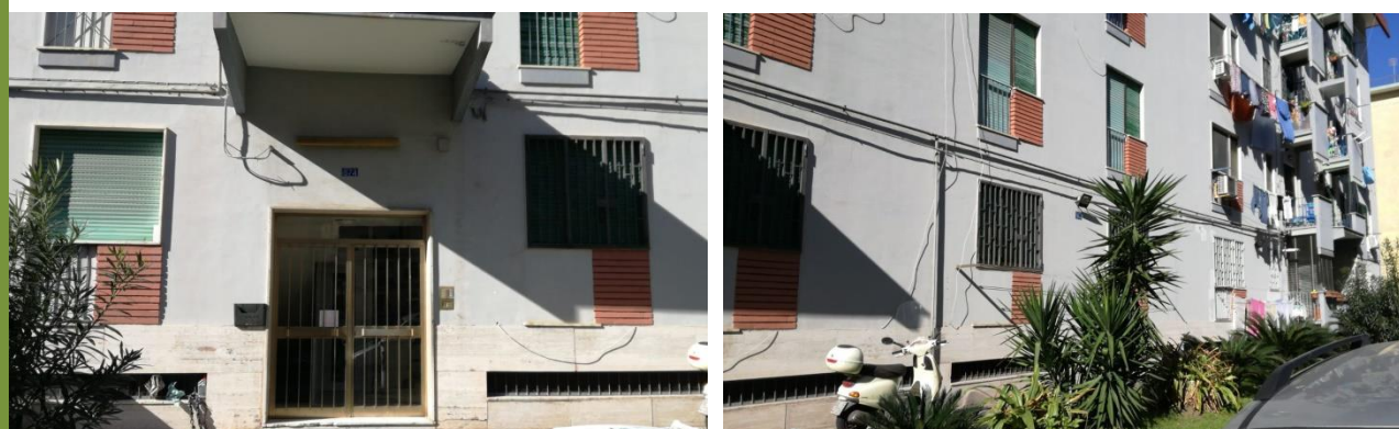
Figg.7,8. Ingresso dell'edificio.
