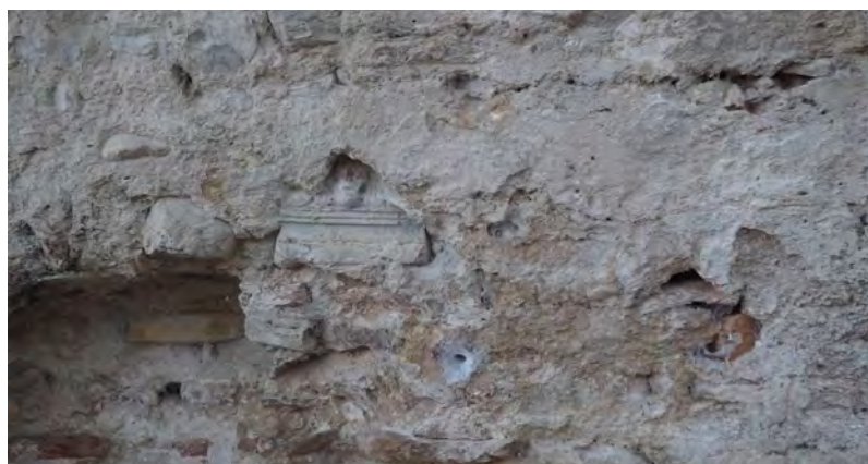
Fig. 15: Particolare di un'antefissa reimpiegata nella struttura dell'arco meridionale.
