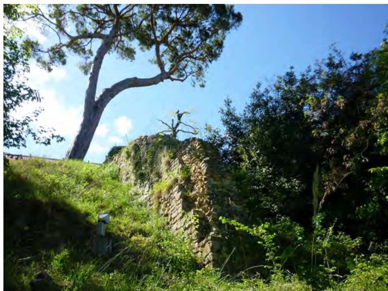
Fig. 3: Il muro di cinta, visto da Est.
