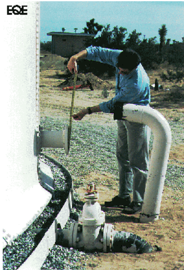
Figura 4.1. Distacco delle tubazioni in un serbatoio a causa della azione sismica ( http://www.eqe.com ).
