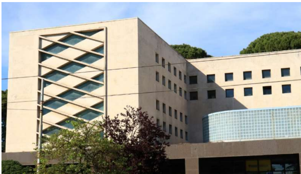
Figura 220- Palazzo delle Poste, A. Libera. Le nervature in calcestruzzo armato dei corpi scala sul prospetto di Via Marmorata. Foto di S. Iaccarino, Roma, Maggio 2021.
