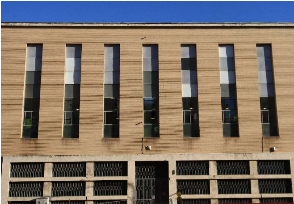
Figura 85- Il prospetto su Via Diaz, con rivestimento in klinker sostituito negli anni Settanta. Foto di S. Iaccarino, maggio 2021.
