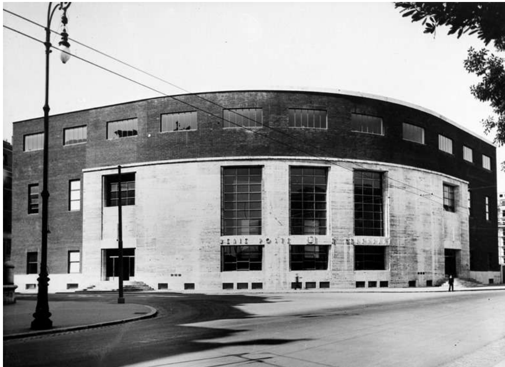
Figura 149- Foto storiche del prospetto del Palazzo Postale di Armando Titta, in cui risulta evidente il ruolo di quinta urbana da esso rivestito. Fonte: Archivio Storico di Poste Italiane, foto B1.0.144.7.
