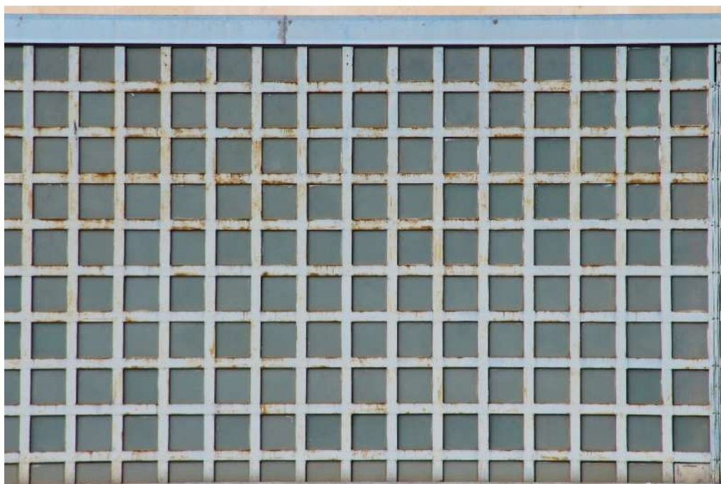
Figura 133- Il lucernario, oggi. La griglia metallica azzurra presenta le prime forme di ossidazione, mentre le vetrate si presentano in buono stato di conservazione. Foto di S. Iaccarino, maggio 2021.
