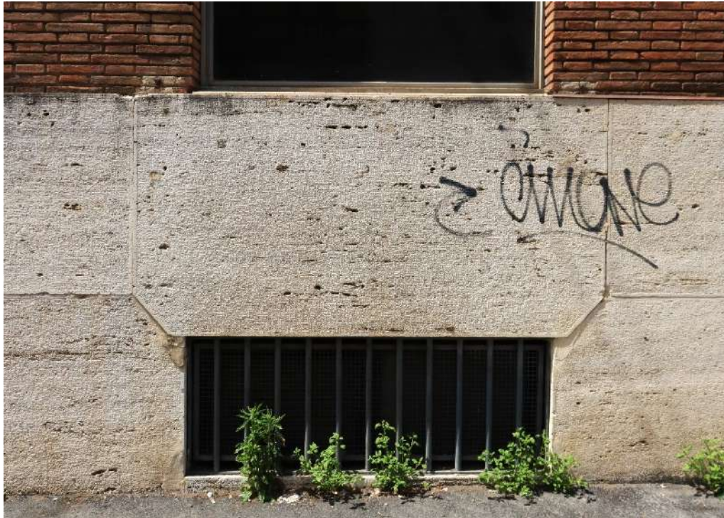
Figura 158- Aperture a bocca di lupo per l'areazione dei seminterrati interrompono il basamento in travertino. Soluzione di taglio della lastra in travertino, leggermente ruotata rispetto al filo esterno. Foto di S. Iaccarino, maggio 2021.
