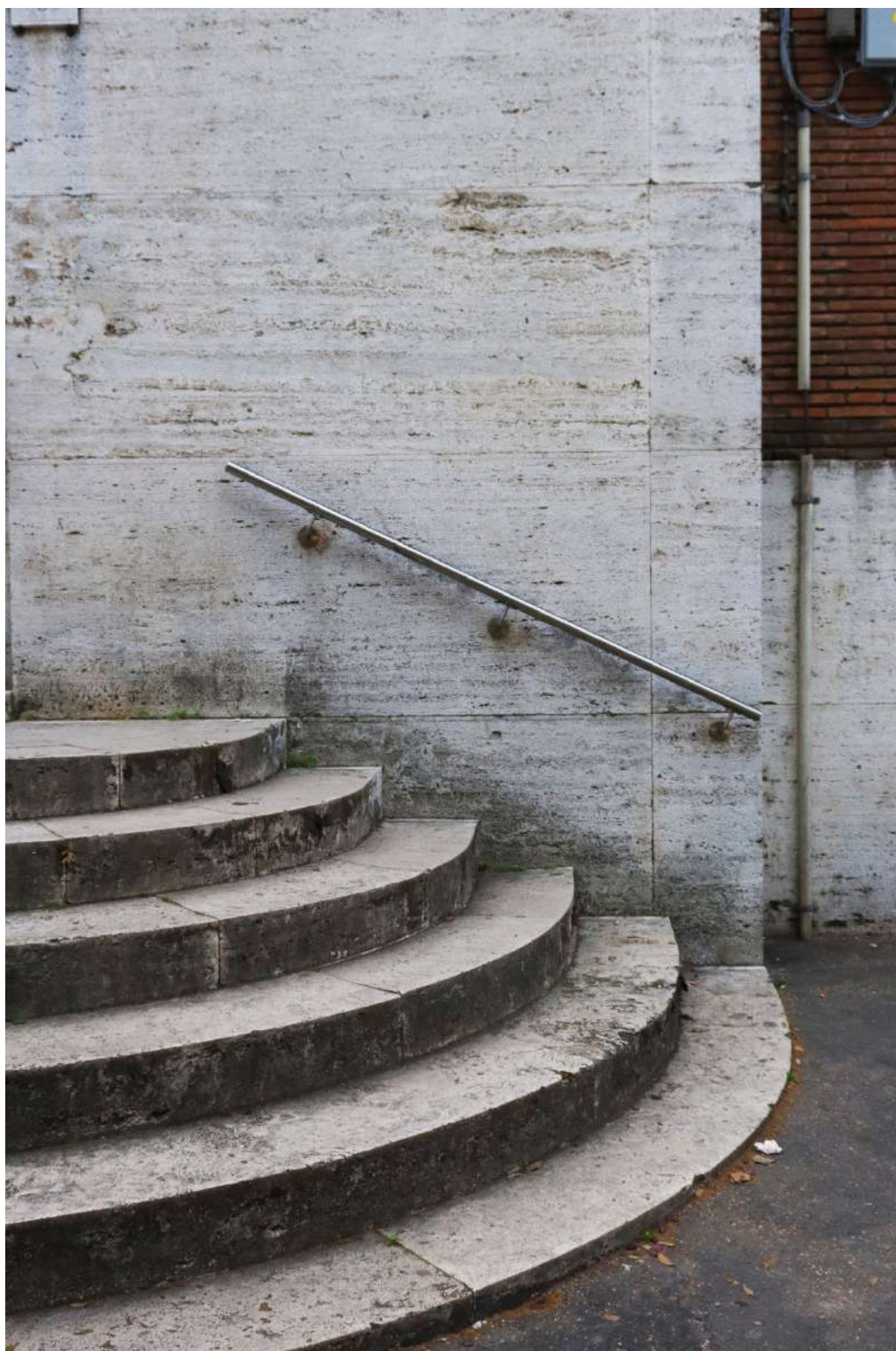
Figura 139- I due accessi laterali del Palazzo Postale avvengono tramite due scale curvilinee in travertino. Foto di S. Iaccarino, maggio 2021.
