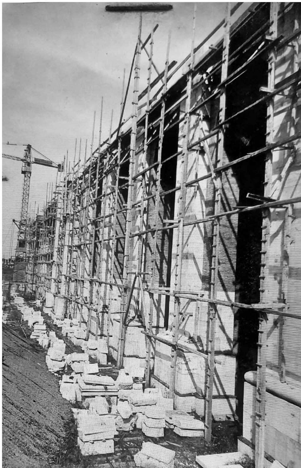
Figura 35- Archivio Centrale dello Stato, foto del cantiere EUR 42. Realizzazione dei rivestimenti in travertino.
