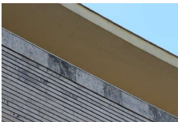
Figura 195- Le forme di degrado che hanno intaccato le pensiline del Palazzo Postale di Piazza Bologna. Foto di S. Iaccarino, Maggio 2021.
