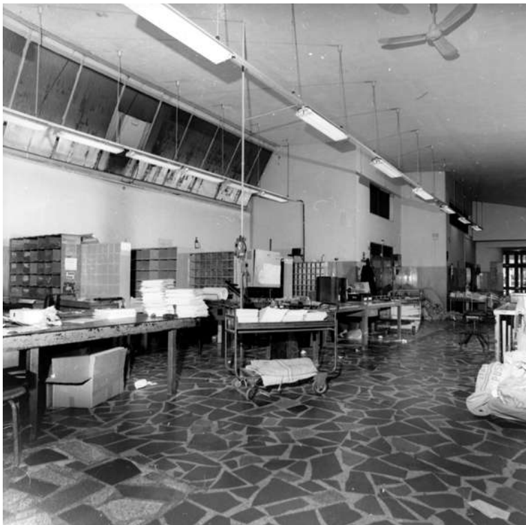
Figura 187- Sopra: La sala portalettere del prospetto posteriore, in cui si vede il sistema del piano caricatore. Sotto: l'interno, dal quale si nota l'ammaloramento delle finestre inclinate. Fonte: Archivio Storico di Poste Italiane, img 003 e foto A3.0.89.12.
