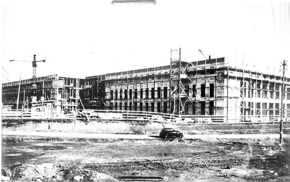
Figura 34- Archivio Centrale dello Stato, foto del cantiere EUR 42.
