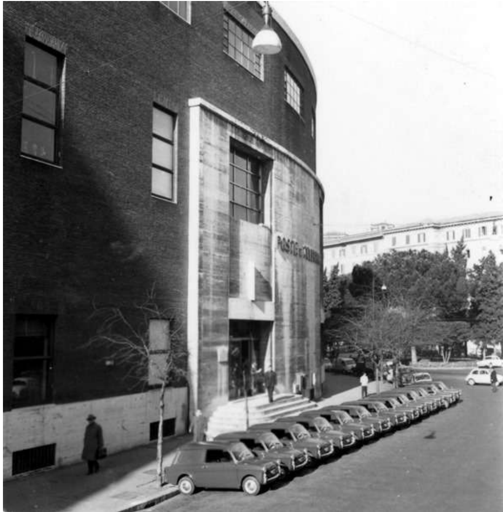
Figura 162- Vista dalla strada del Palazzo Postale del quartiere Milvio. Si noti l'ingresso laterale e lo stato di degrado sul paramento in travertino, dovuto all'azione delle acque meteoriche non protette a sufficienza dagli aggetti della facciata. Fonte: Archivio Storico di Poste Italiane, foto E3.0.160.4.
