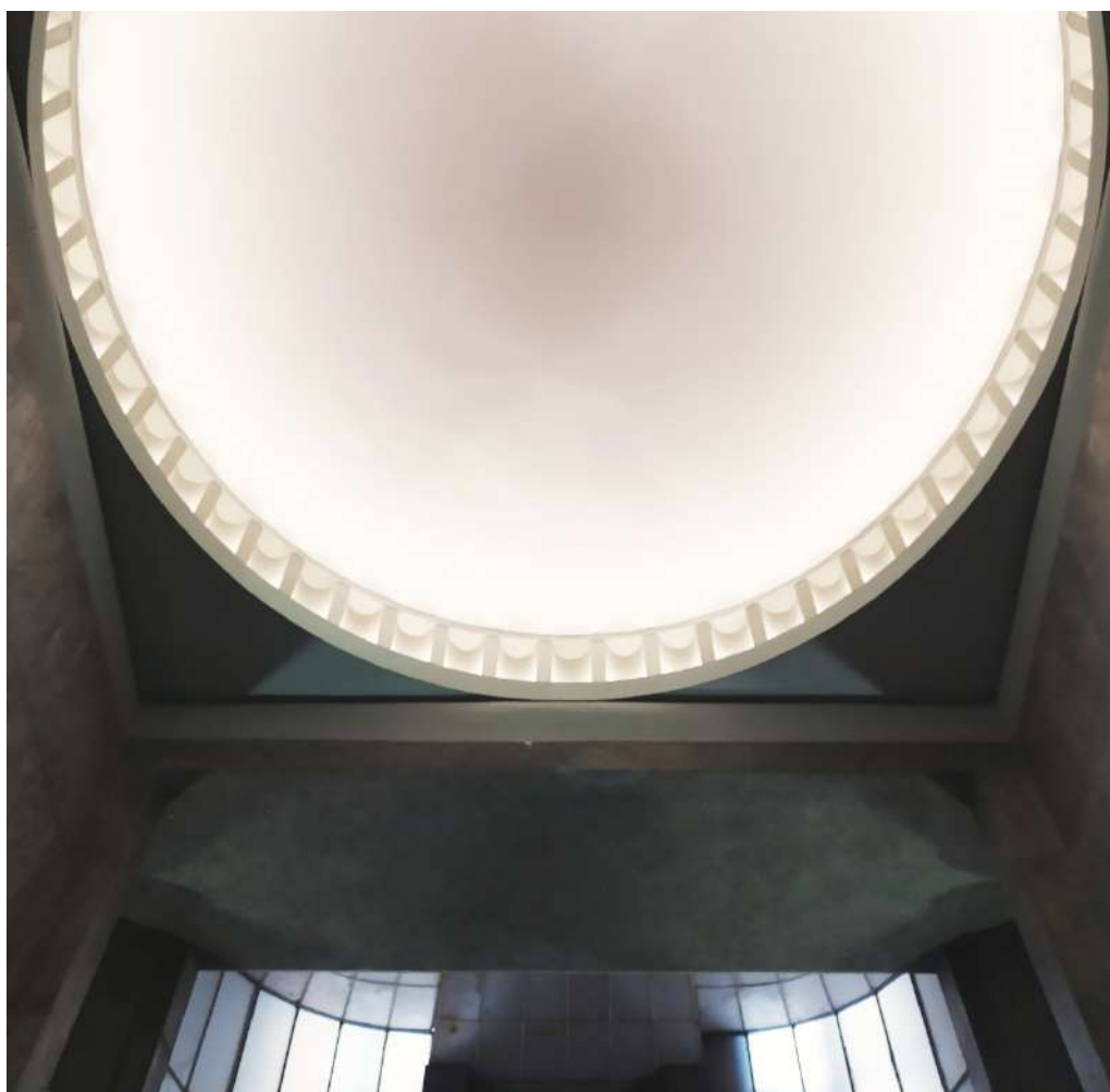
Figura 221- Calotta in graticcio Stauss in una delle sale della Casa del Mutilato, Napoli. Foto di S. Iaccarino, Settembre 2020.
