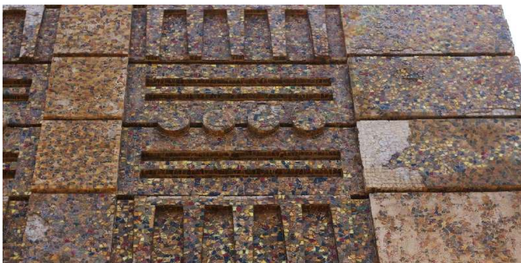
Figura 215- Stratificazione degli interventi di reintegrazione delle tessere in vetro muranese del Cubo d'Oro nella Mostra d'Oltremare a Napoli. Foto di S. Iaccarino, luglio 2019.
