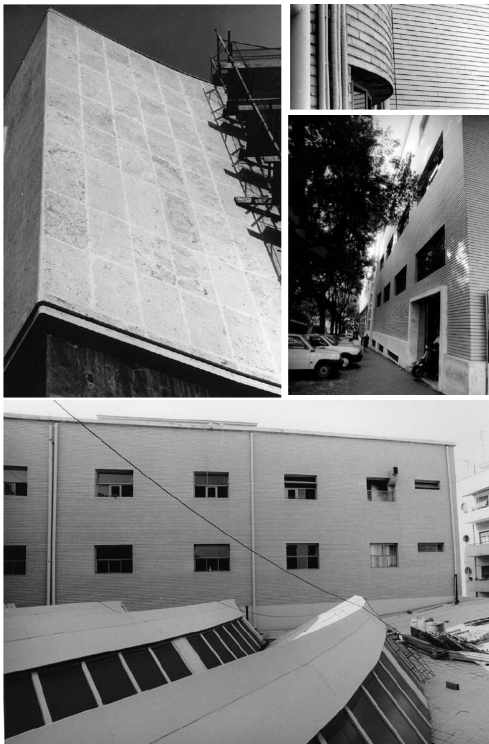
Figura 92- Interventi degli anni Settanta: Il restauro dei rivestimenti in travertino, il rifacimento del rivestimento in Klinker e delle solette delle coperture sheds. Fonte: Archivio Storico di Poste Italiane, foto 19.0.5.9, 19.0.5.5, 19.0.5.10, 19.0.5.13.
