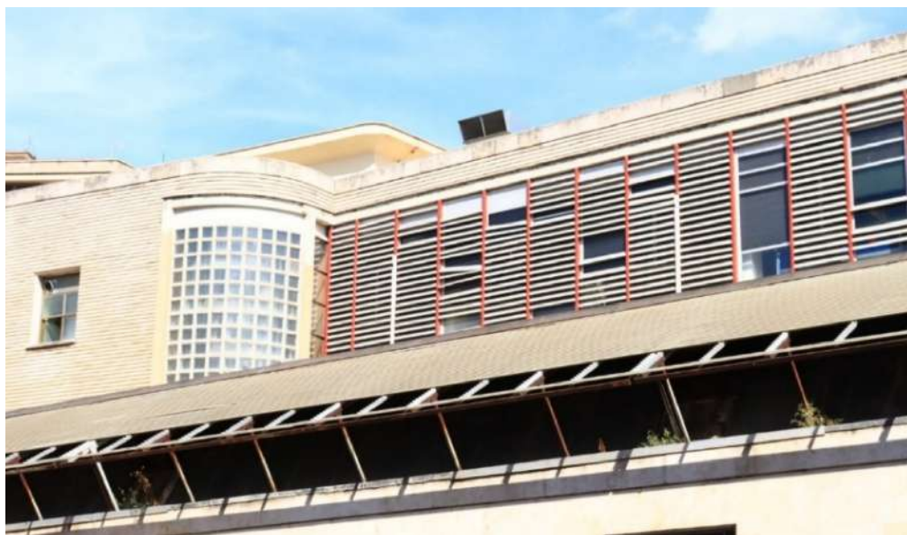
Figura 203- Palazzo delle Poste, M. Ridolfi. Lo stato di conservazione dei diaframmi trasparenti del prospetto posteriore: la parete in vetrocemento del corpo scala (anni Trenta), il frangisole a doghe orizzontali e la “tenda” metallica installati negli anni Settanta. Foto di S. Iaccarino, Roma, Maggio 2021.
