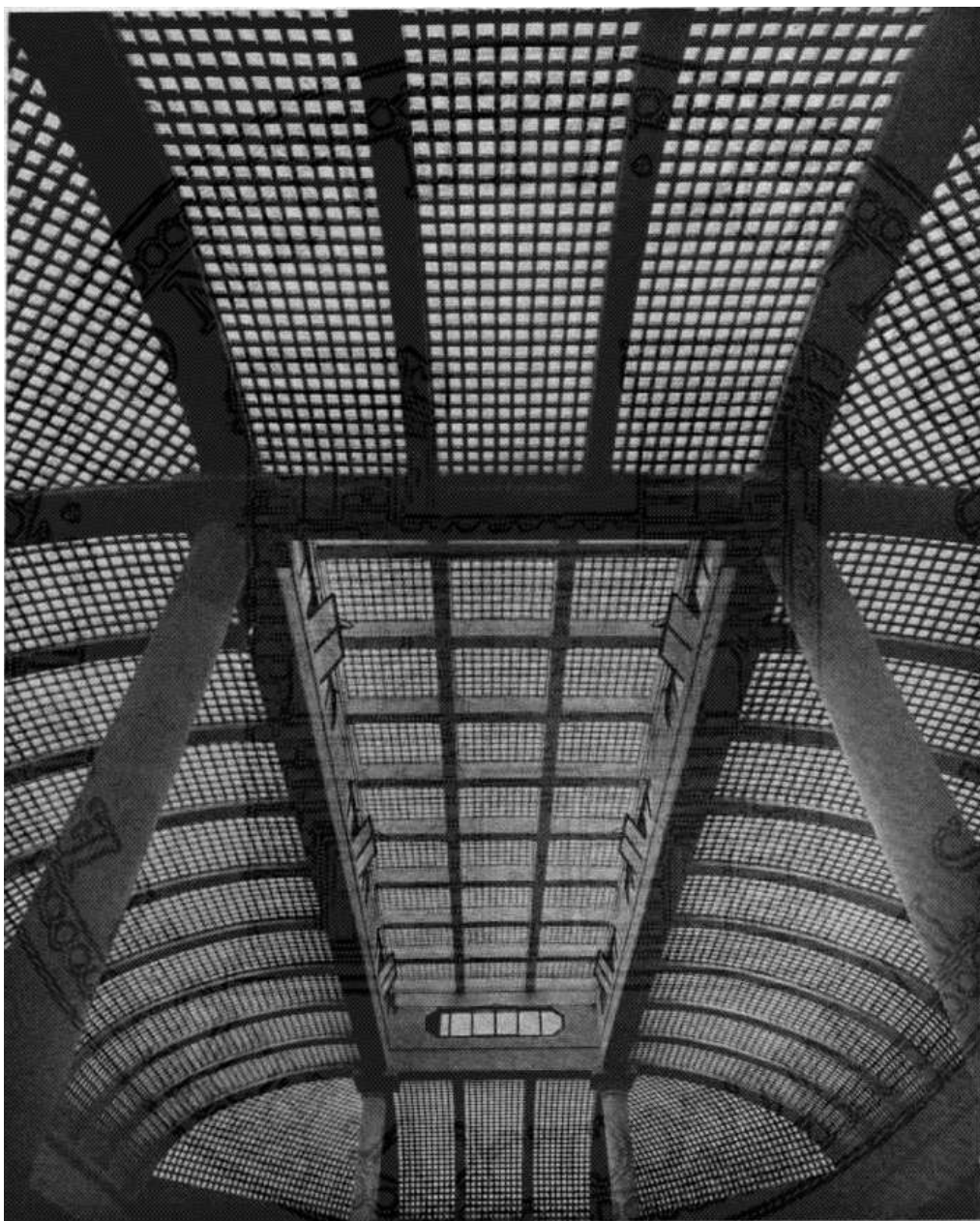
Figura 27- Pubblicità della S.A.I.V.A. Soc.An. Vetrocemento armato, Roma. Copertura in vetrocemento armato del Salone dell'Istituto Centrale di Statistica a Roma. Pubblicato su Architettura, 1933, fascicolo V.
