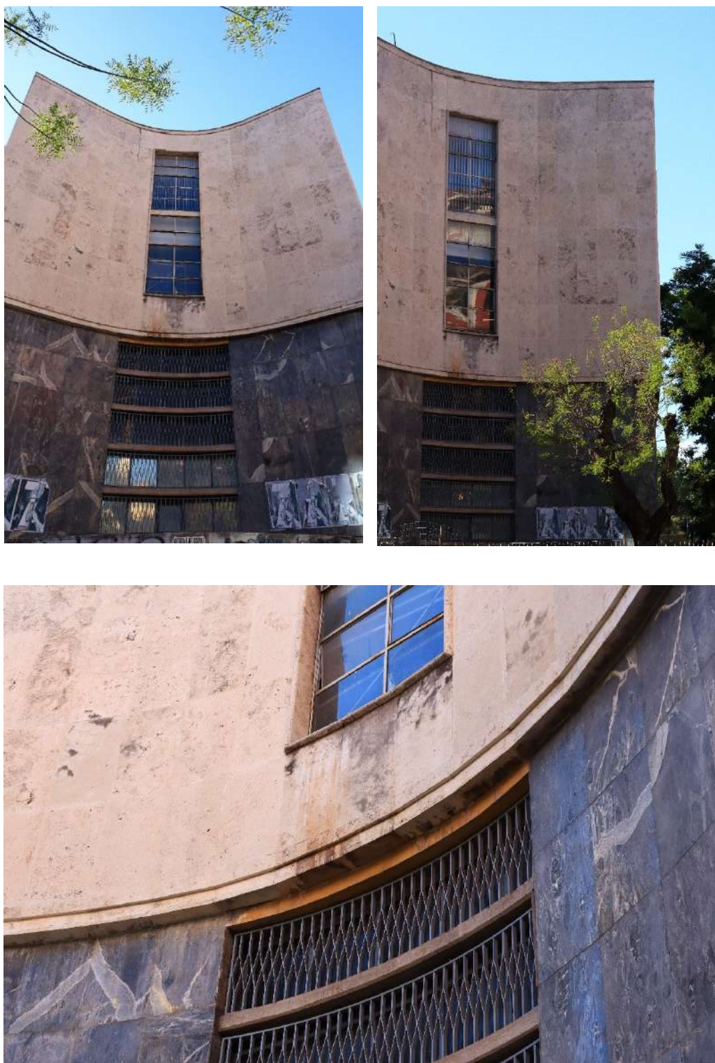
Figura 84- La soluzione materica delle due fasce dei prospetti: in alto, travertino di Tivoli; nella fascia basamentale in granito di Salomaco grigio scuro venato. Foto di S. Iaccarino, maggio 2021.
