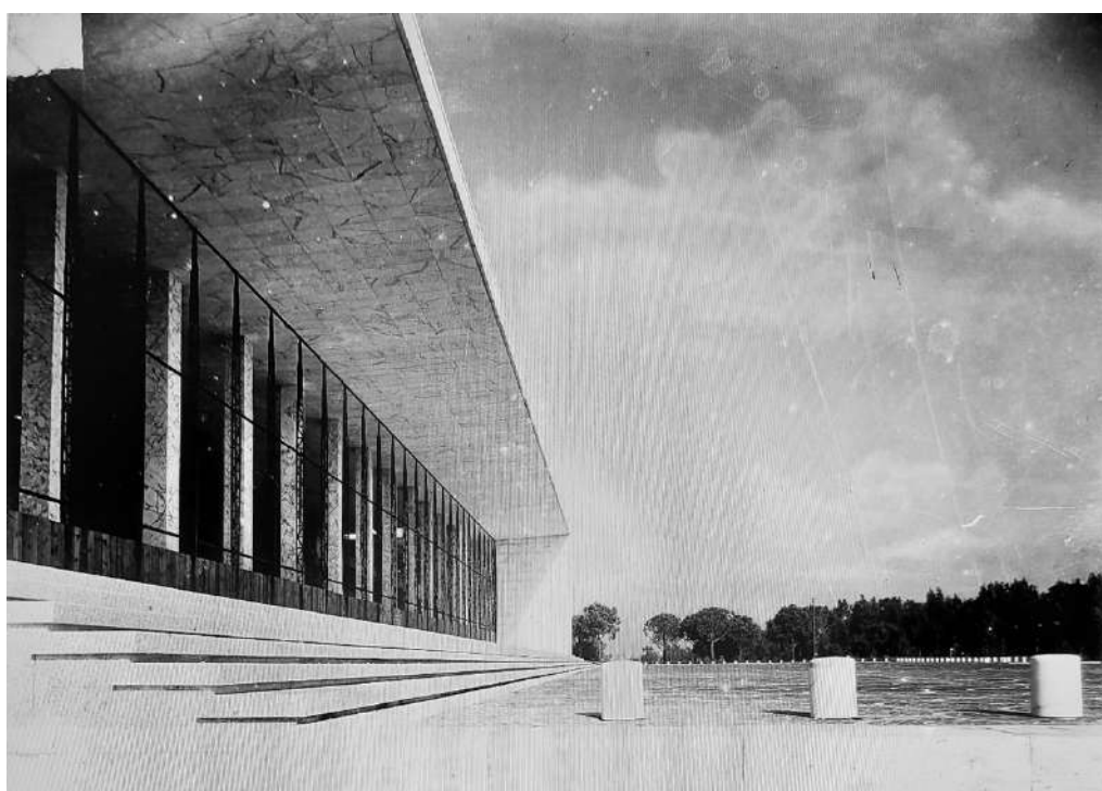
Figura 32- Archivio Centrale dello Stato, foto del cantiere EUR 42.
