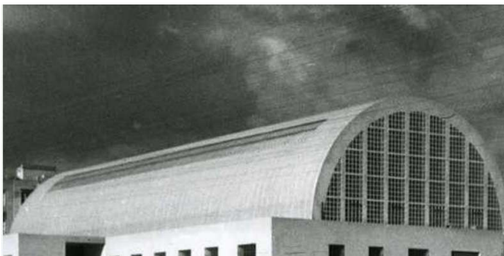
Figura 206- Calotta dell'ex Mercato Ittico di L. Cosenza, Napoli. La foto mostra una delle due chiusure verticali in vetrocemento, nonché il taglio della copertura a botte, finalizzato ad illuminare lo spazio della grande sala destinata alla vendita del pesce. Foto storica custodita presso l'Archivio Luigi Cosenza.
