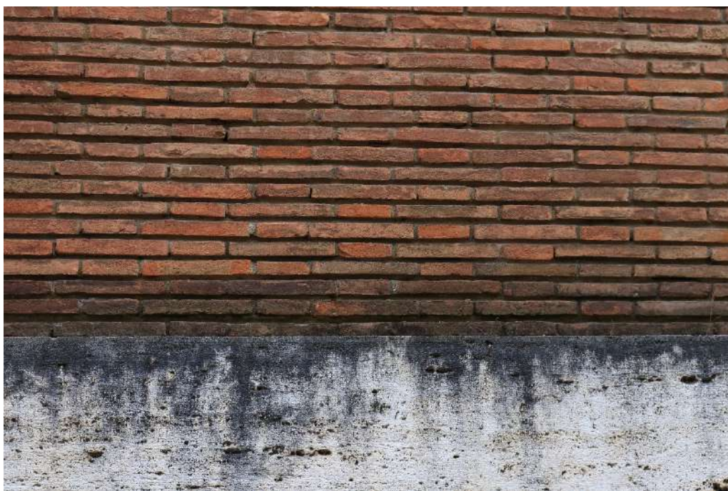
Figura 147- Nel suo chiaro rimando alla tradizione architettonica romana, Titta ripropone l'accostamento tra travertino e laterizio. Quest'ultimo, però, non è travertino laziale bensì travertino toscano della cava di Cecina. Foto di S. Iaccarino, maggio 2021.
