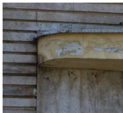
Figura 195- Le forme di degrado che hanno intaccato le pensiline del Palazzo Postale di Piazza Bologna. Foto di S. Iaccarino, Maggio 2021.
