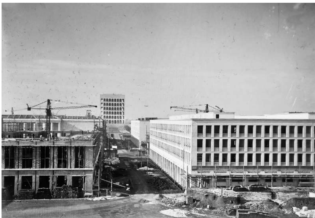
Figura 33- Archivio Centrale dello Stato, foto del cantiere EUR 42.
