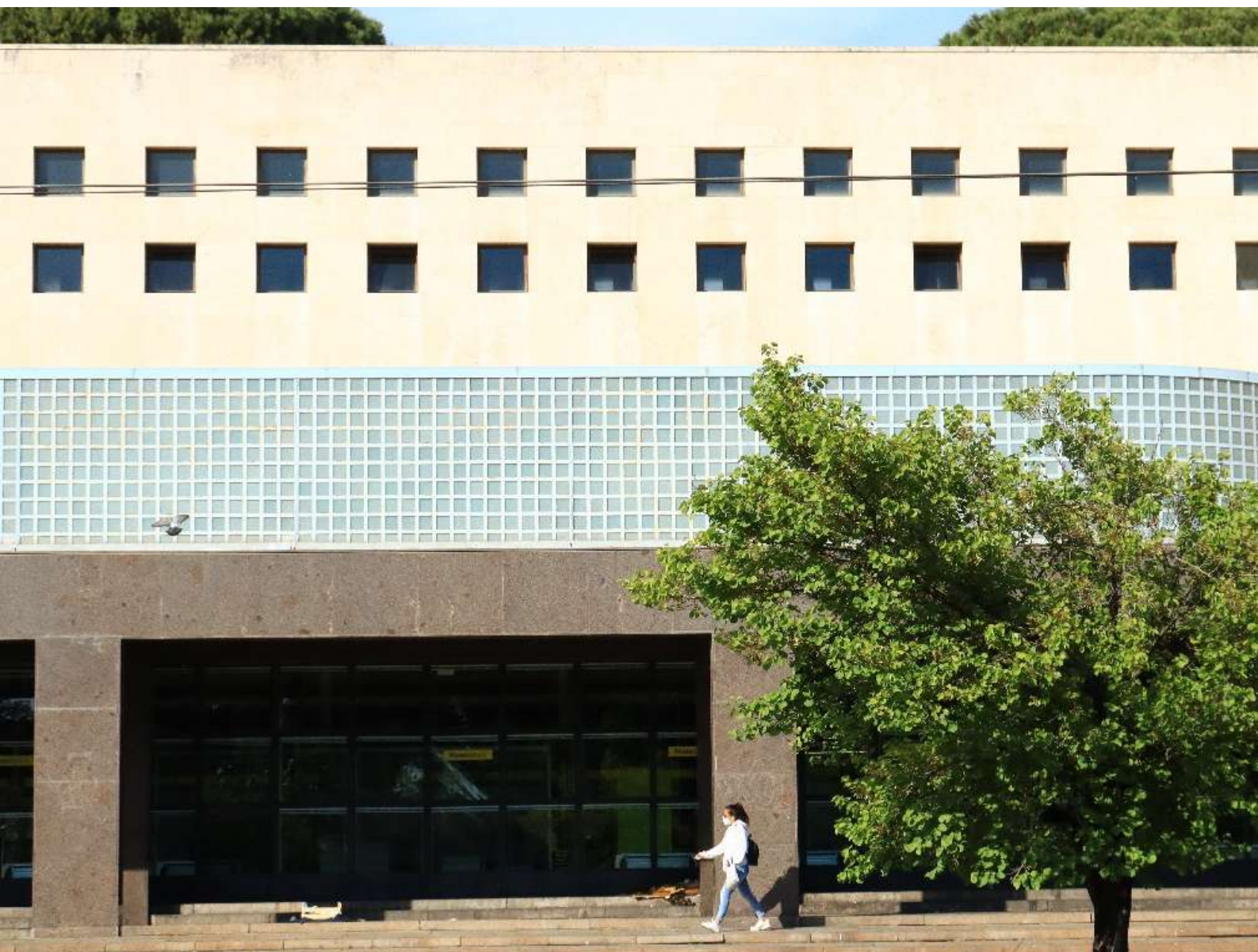
Figura 119- Il portico rivestito in porfido violaceo di Predazzo. Sia il portico che il lucernario devono la loro conformazione attuale all'intervento di restauro guidato da Sergio Poretti. Foto di S. Iaccarino, maggio 2021.
