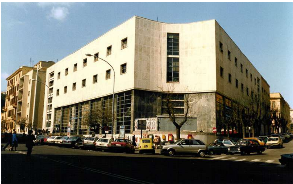
Figura 88- Interventi degli anni Settanta. In alto, i prospetti su Via Taranto e Via Pozzuoli. In essi si evidenzia un forte segno grafico definito dalle stuccature dei giunti appena ripristinate, decisamente più chiare del rivestimento in travertino. In basso, il nuovo paramento in Klinker beige sostituito a quello originario di tonalità grigio verdi. Fonte delle foto: Archivio Storico di Poste Italiane, foto 75.25.3.29.
