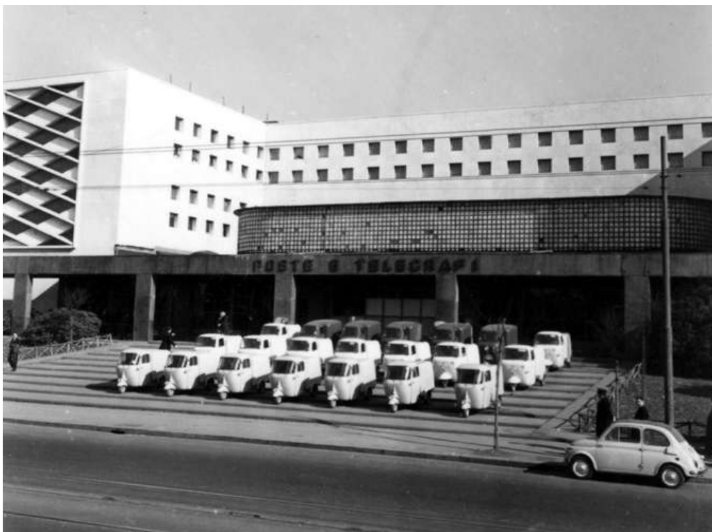
Figura 120- Il Palazzo Postale dell'Aventino. Il rapporto con Via Marmorata, è possibile intravedere le staccionate poste in opera probabilmente negli anni Cinquanta, così come lo spiovente al di sopra del lucernario. Fonte: Archivio Storico di Poste Italiane, foto A.3.0.89.11.
