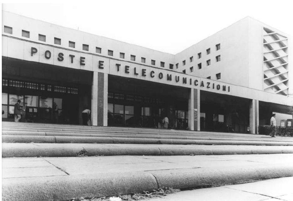
Figura 128- gli effetti dell'intervento di rifacimento del rivestimento del portico, in cui le lastre in porfido violaceo di Predazzo sono state sostituite con lastre in travertino e inserti in porfido in corrispondenza dei pilastri. Anche l'iscrizione sommitale è stata cambiata: da "Poste e Telegrafi" si è passati a "Poste e Telecomunicazioni". Fonte fotografie: Archivio Storico di Poste Italiane, foto 77.27.2.6.
