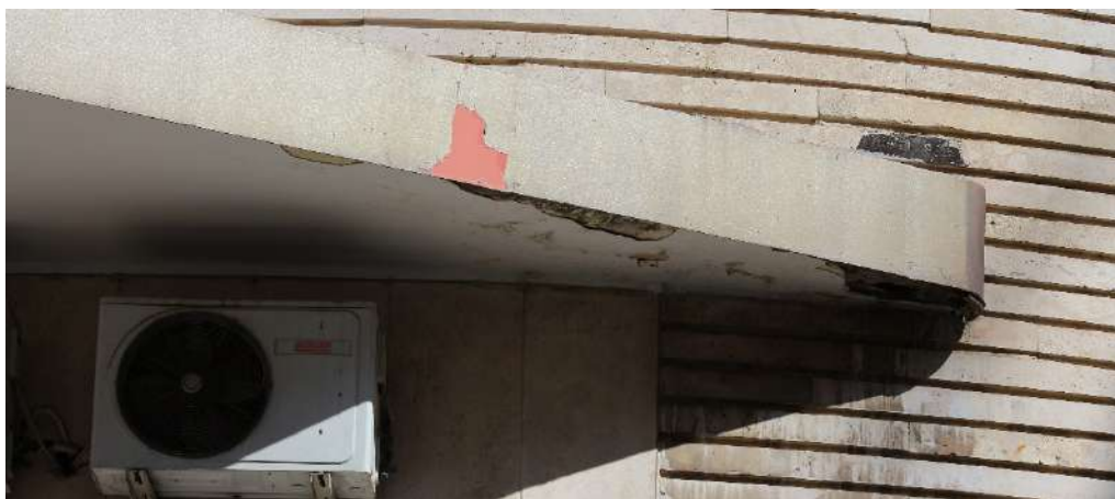
Figura 193- Tracce della tinteggiatura rossa al di sotto di quella attuale. Foto di S. Iaccarino, maggio 2021.
