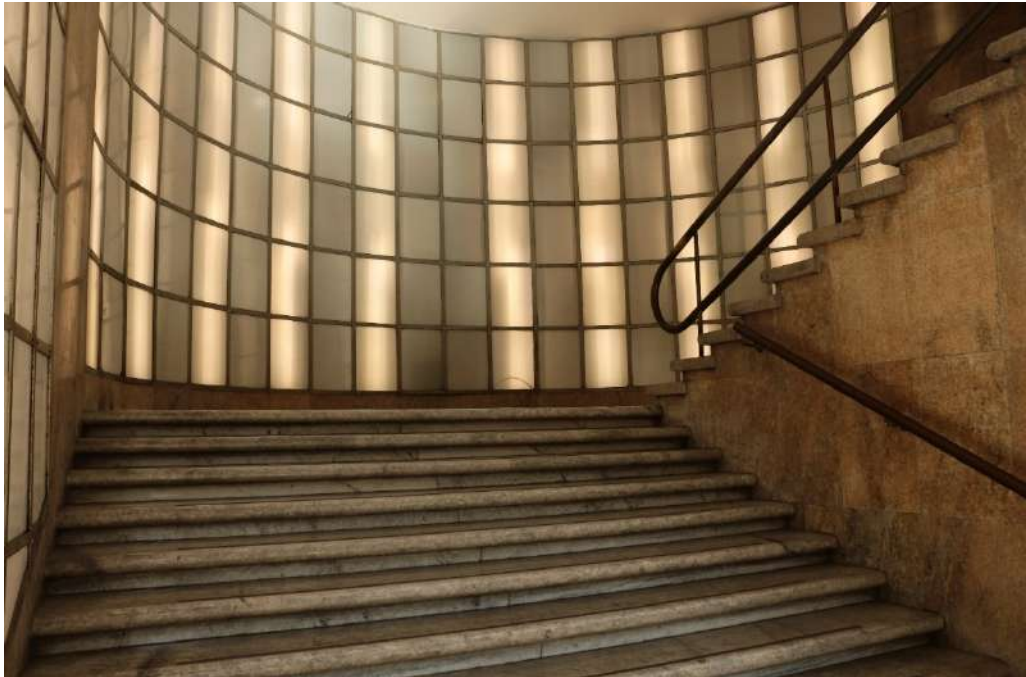
Figura 211- Pannellatura in Termolux dello scalone del Palazzo delle Poste di Napoli. Foto di S. Iaccarino, Ottobre 2019.
