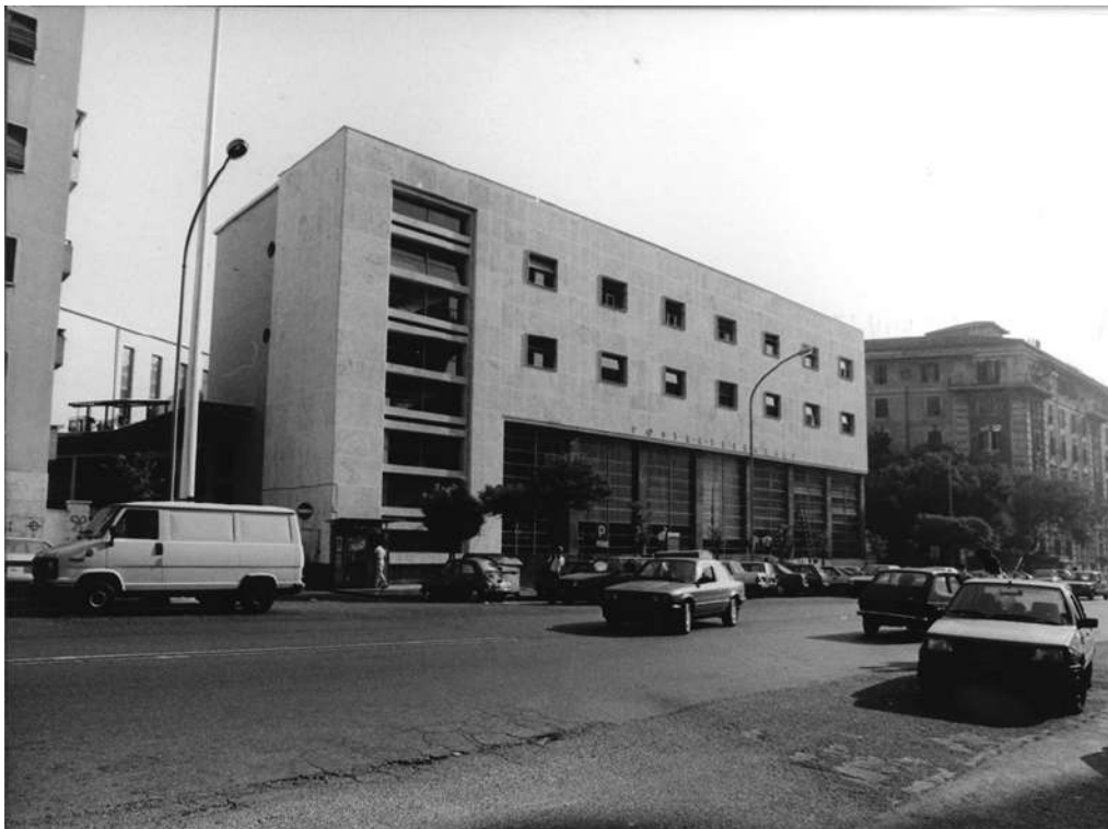
Figura 91- Interventi degli anni Settanta: Il restauro dei rivestimenti in Travertino, con ristilatura dei giunti, del prospetto su Via Taranto Fonte: Archivio Storico di Poste Italiane, foto 19.0.5.2, 19.0.5.3.
