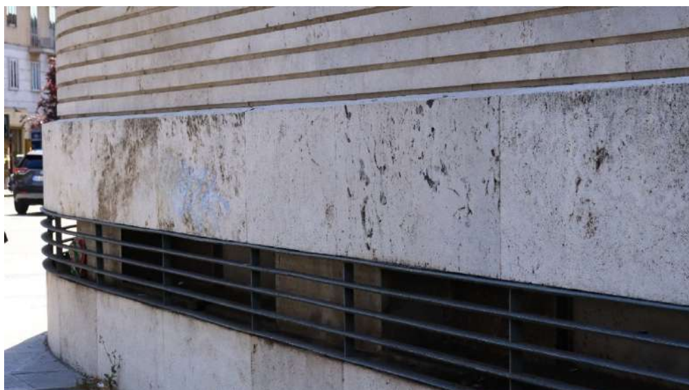
Figura 182- La fascia basamentale del palazzo postale. Foto di S. Iaccarino, maggio 2021.
