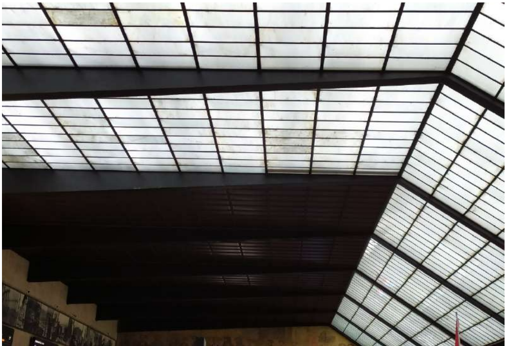
Figura 212- Lucernario in Termolux della Stazione di S. Maria Novella a Firenze. Foto di S. Iaccarino, Novembre 2019.
