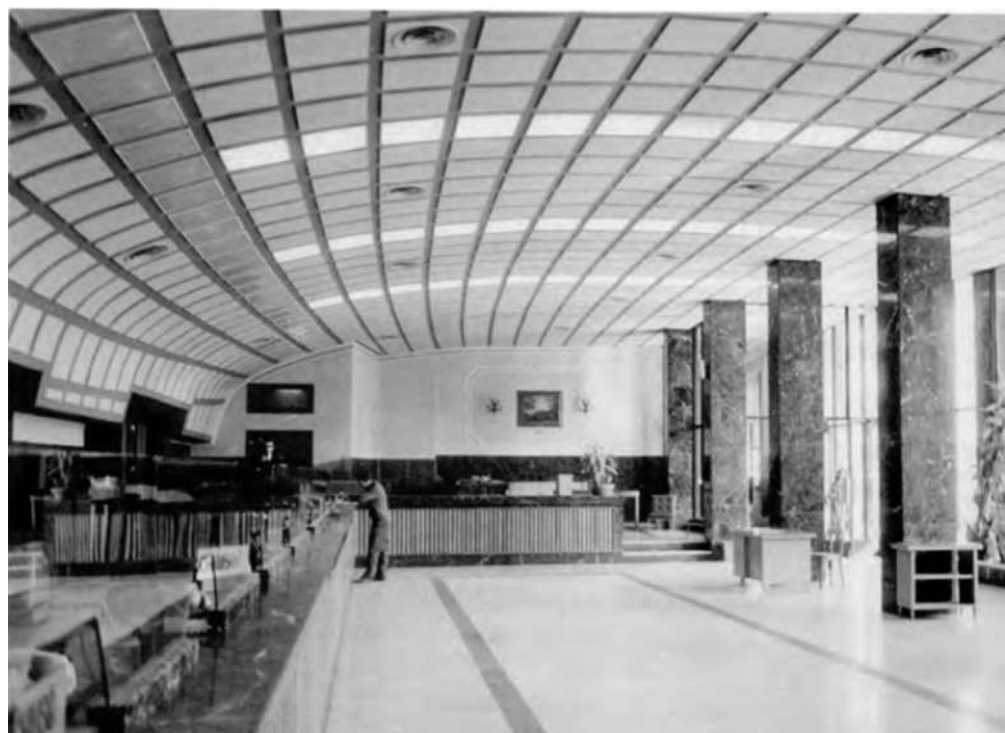
Figura 186- Dopo l'inaugurazione (sopra) e dopo gli interventi degli anni Settanta (sotto).
