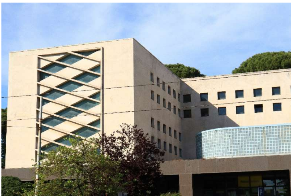
Figura 118- La soluzione d'angolo, in cui le aperture terminali di ogni piano si congiungono nell'angolo in maniera troppo ravvicinata. Foto di S. Iaccarino, maggio 2021.
