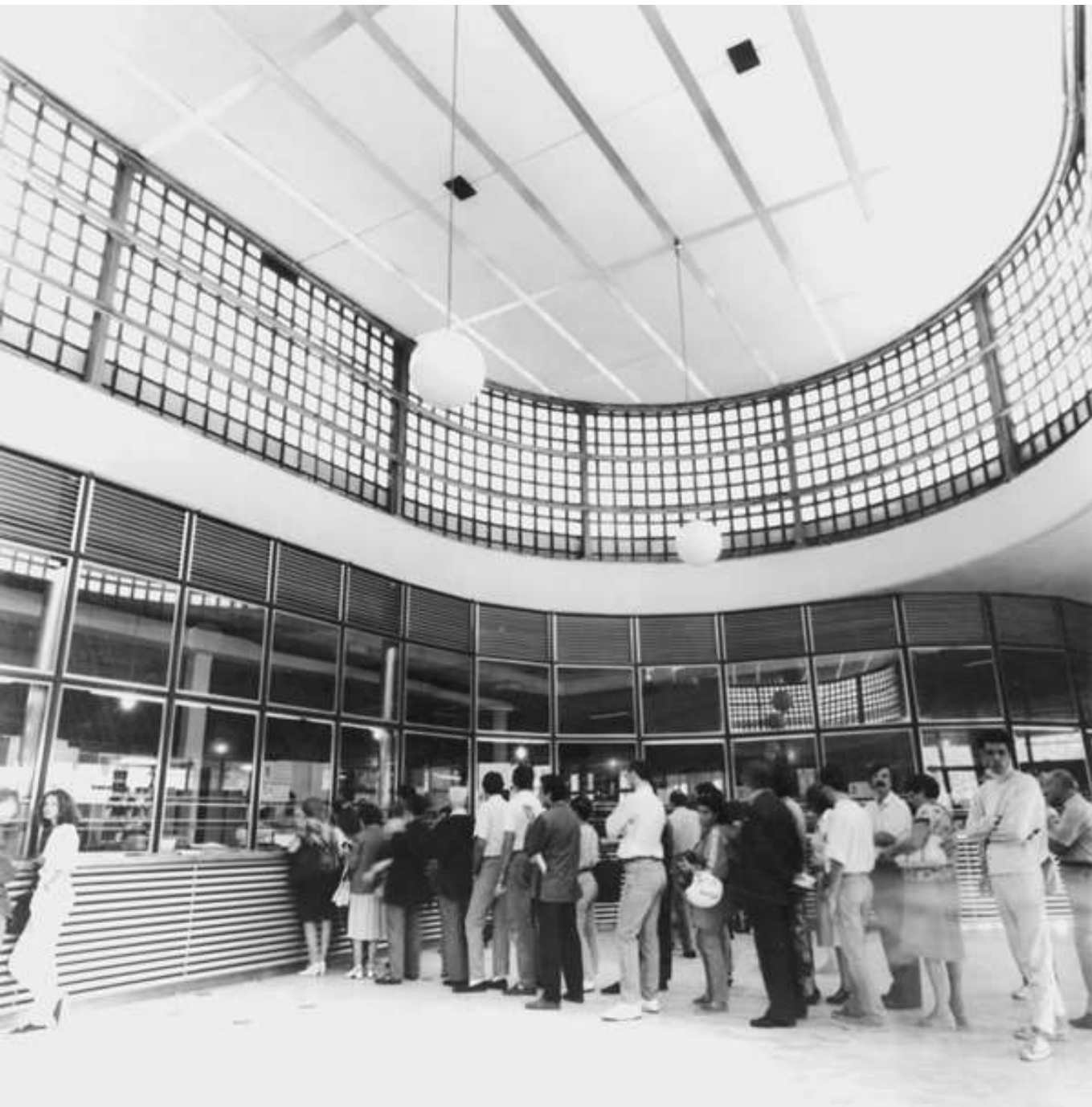
Figura 135- Interventi degli anni Settanta. L'interno architettonico muta in seguito all'installazione della vetrata continua in corrispondenza del bancone, che occulta i pilastri cromati della sala; viene inoltre installato un controsoffitto a chiusura della calotta intonacata originaria, così come viene prevista l'installazione di una fitta griglia quadrata sui diaframmi verticali del lucernario. Tali elementi appesantiscono visivamente la concezione spaziale originaria dell'architetto. Fonte: Archivio Storico di Poste italiane, foto 77.27.2.21.
