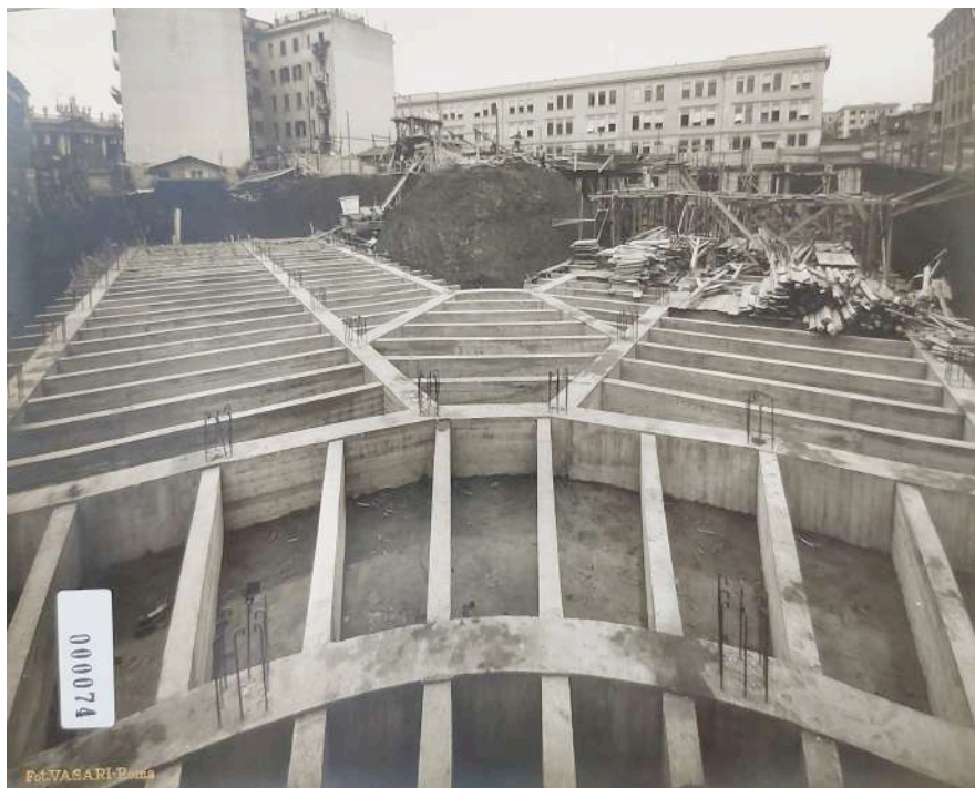
Figura 102- Predisposizione dello scavo per la realizzazione delle strutture di fondazione. Realizzazione delle strutture in calcestruzzo armato degli sbds di copertura della corte. Fonte: Archivio Storico di Ferrovie dello Stato, Ministero delle Comunicazioni, Servizio lavori e costruzioni, serie C (Strada e Fabbricati) Cartella IIb 9 (I) XXVII, Edifici postali e telegrafici, busta 4862: Roma, quartiere Appio – via Taranto – costruzione di un fabbricato ad uso dei servizi postali e telefonici in Roma (Architetto Giuseppe Samonà), foto 000070, 000074.
