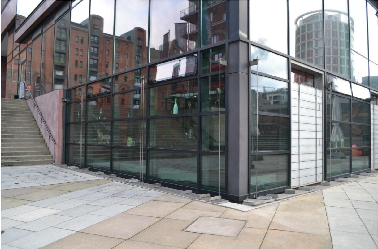
**Figura 15.** Sistemi di protezione temporanei per gli infissi ad Hafen city, Amburgo
