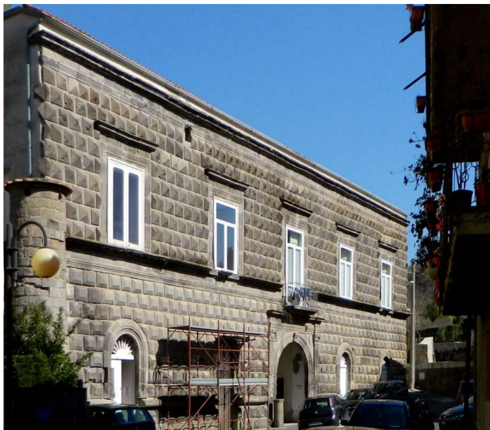
Fig. II.8. Lauro, località Preturo, palazzo Del Cappellano (foto Serraglio).
