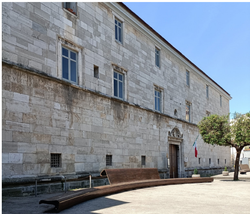
Fig. III.11. Nola, palazzo Orsini, facciata (foto Tufano).
