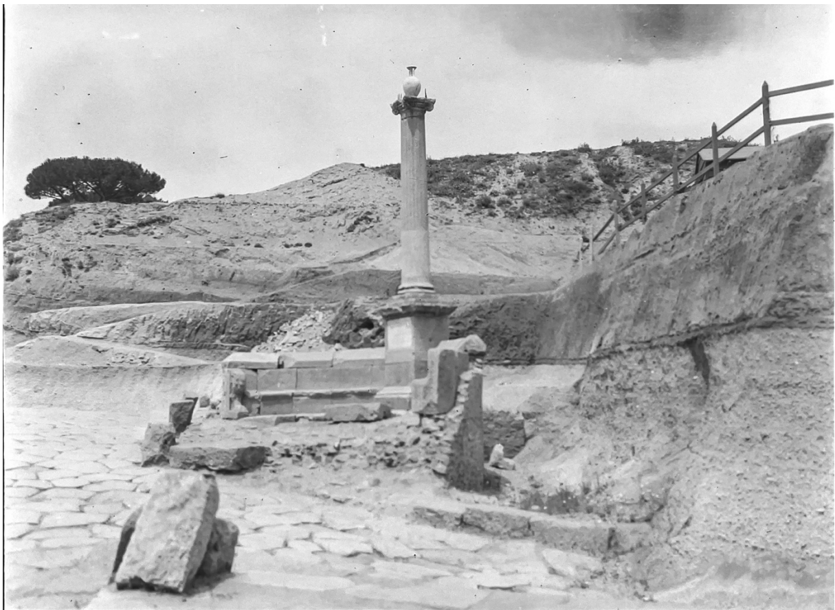
L'area dell'anfiteatro e di Porta Nola in due foto di Pierre Gusman (1899-1900 c. a.). Si noti la particolare condizione orografica dei margini del sito archeologico ancora caratterizzate dall'accumulo dei terreni risultanti dagli scavi (BINHA, Fonds Gusman,, Plaque PHOT, 12.20).
