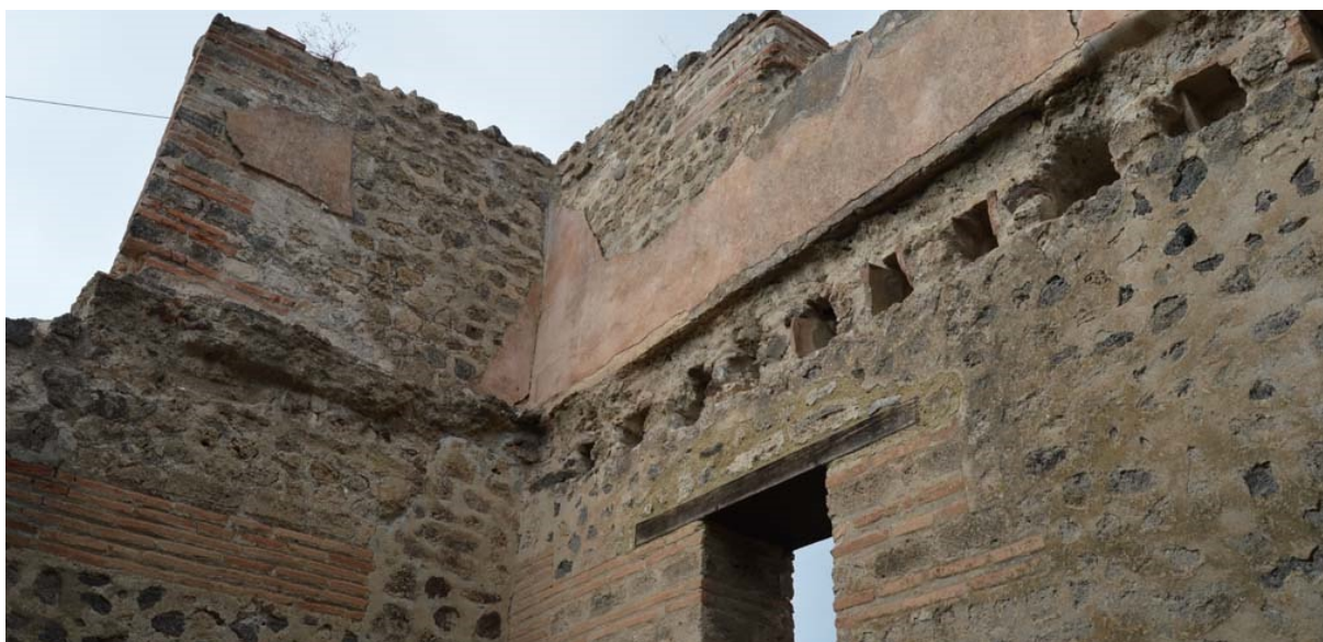
Pompei, tracce di un solaio intermedio consolidate dagli interventi di restauro tardo-ottocenteschi.
