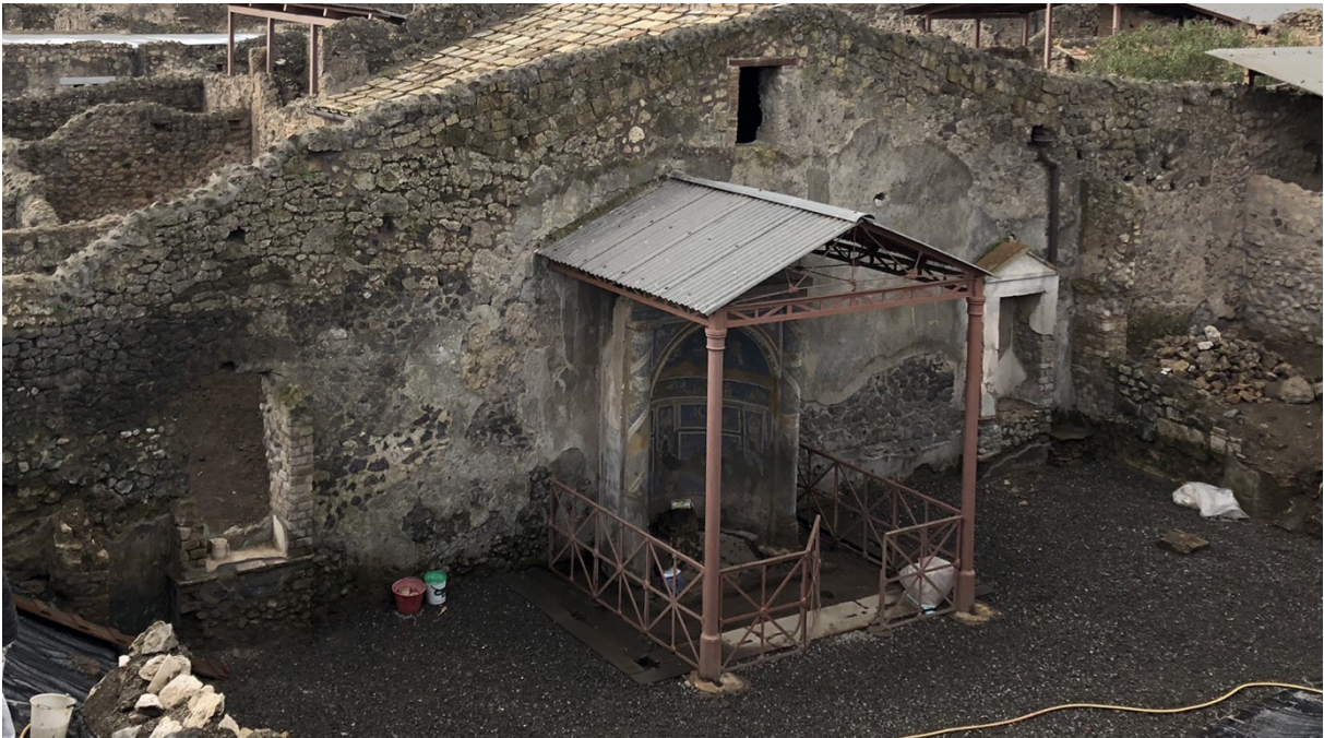
Pompei, Casa degli archi (IX.7.20) nel 1879. Confronto tra le pitture di L. Bazzani che ci descrivono i primi presidi apposti alla fontana a mosaico e la copertura metallica promossa da Michele Ruggiero (capriata polonceau poggiata nella parte anteriore su colonnine in ferro).
