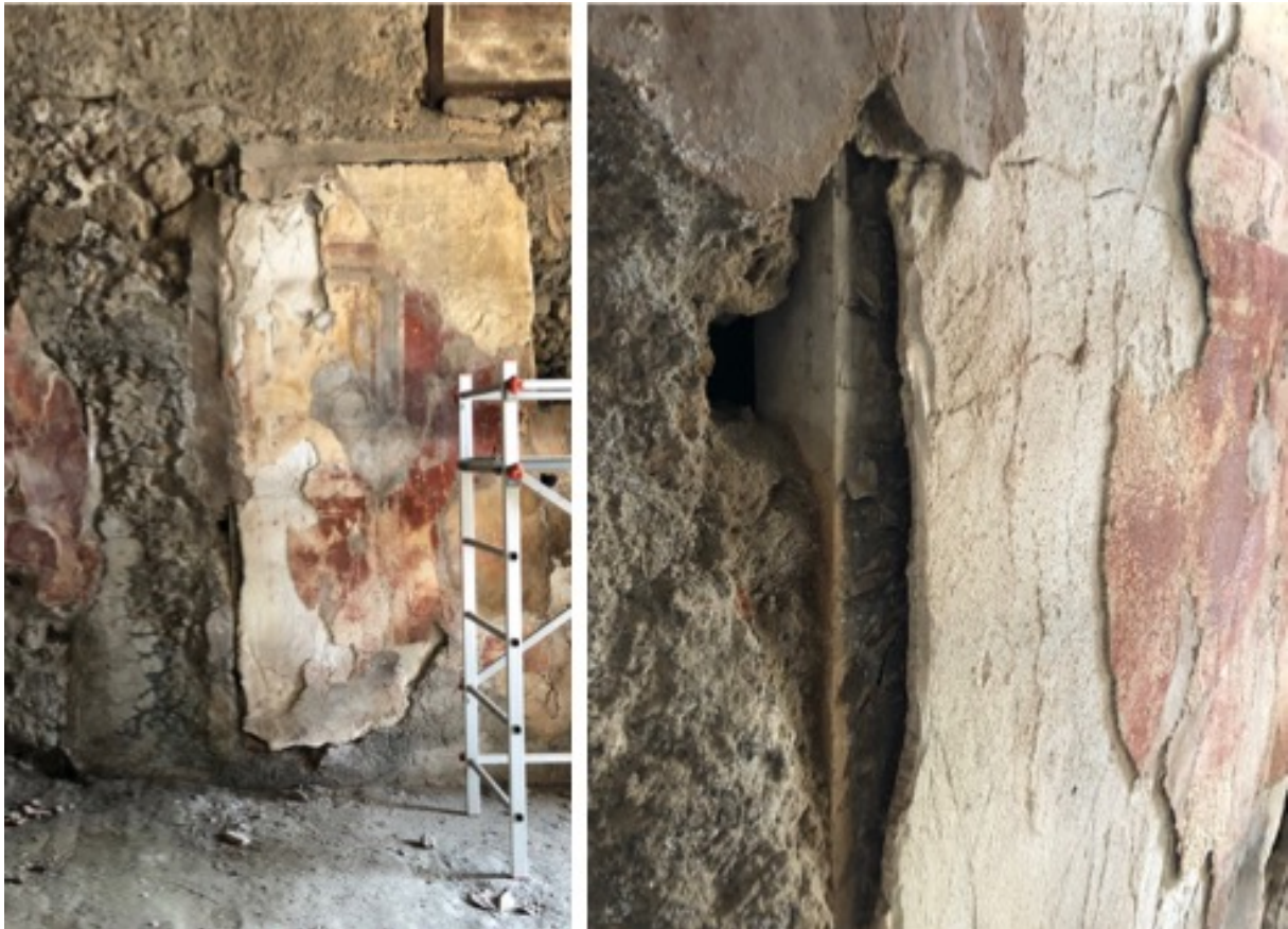
Pompei, frigidarium delle Terme del Sarno. Dettaglio del consolidamento degli intonaci su tavole lignee e bordatura con lacertini in malta (foto ottobre 2021).
