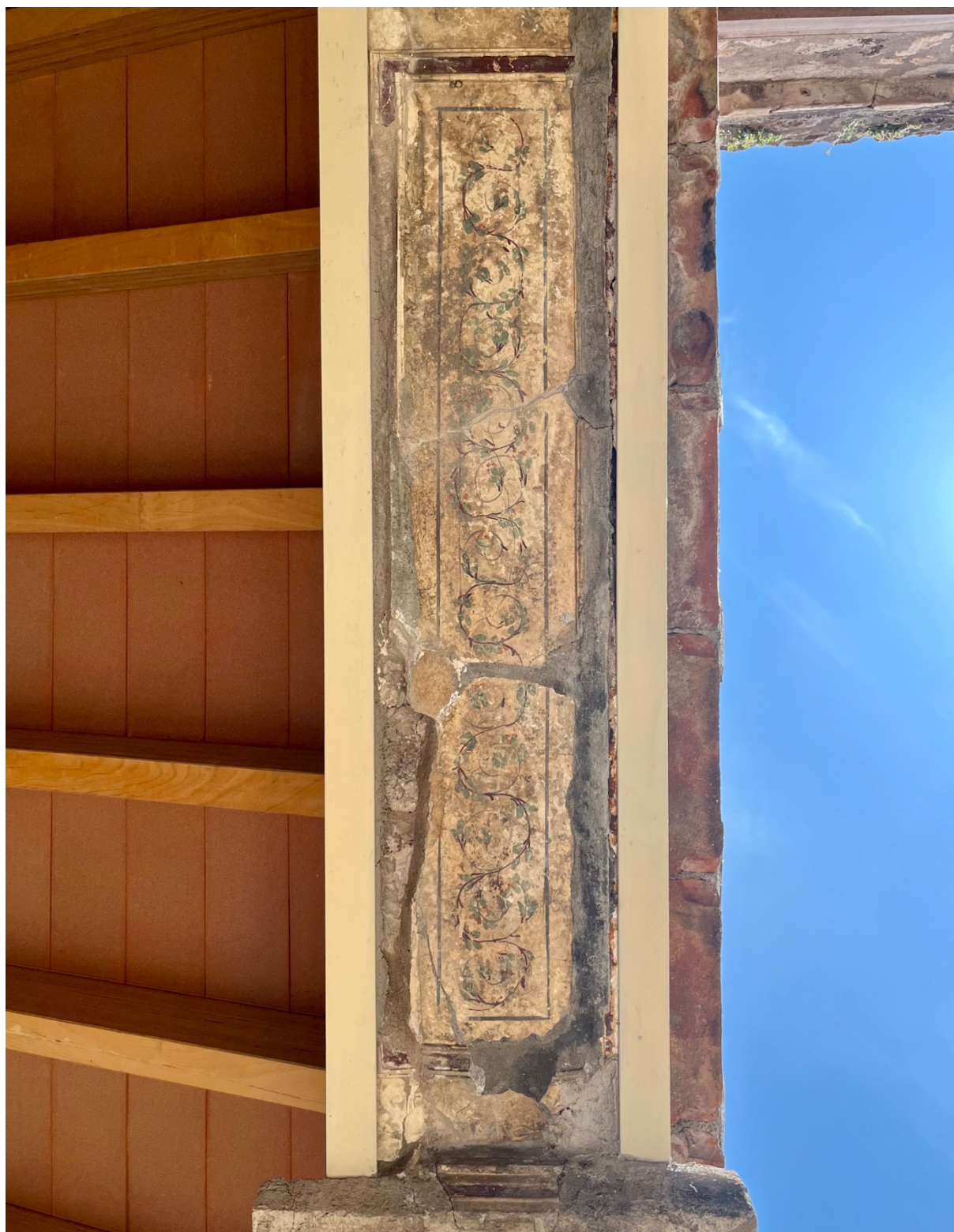
Pompei, Casa delle Nozze d'Argento. L'epistilio dopo i recenti restauri (maggio 2023).
