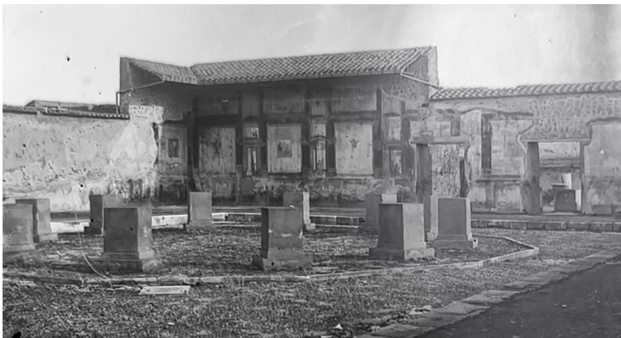
Pompei, tettoia protettiva realizzata durante la direzione Ruggiero a seguito del consolidamento delle superfici decorate (1875-1893 c.a.).
