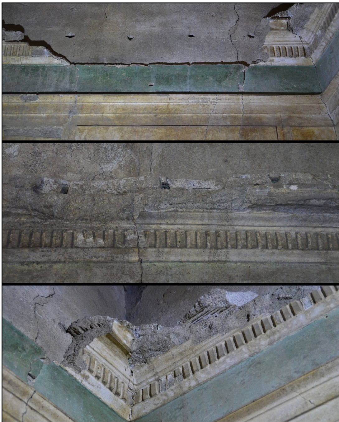
Fig. 88 – Pompei, domus I.15.1, cubiculum 3: tracce e impronte dei materiali deperibili impiegati nelle diverse fasi di realizzazione della cornice a dentelli (foto dell'autore).
