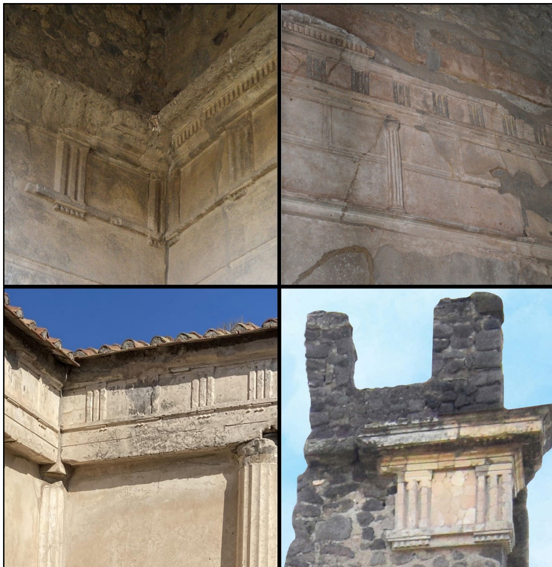
Fig. 16 – Pompei, trabeazioni in stucco: in alto a sinistra l' atrium 2 della Casa dell'Atrio Dorico e a destra il cubiculum 15 della Casa di Sallustio, in basso a sinistra la Casa dei Dioscuri e a destra la Torre X (foto dell'autore).
