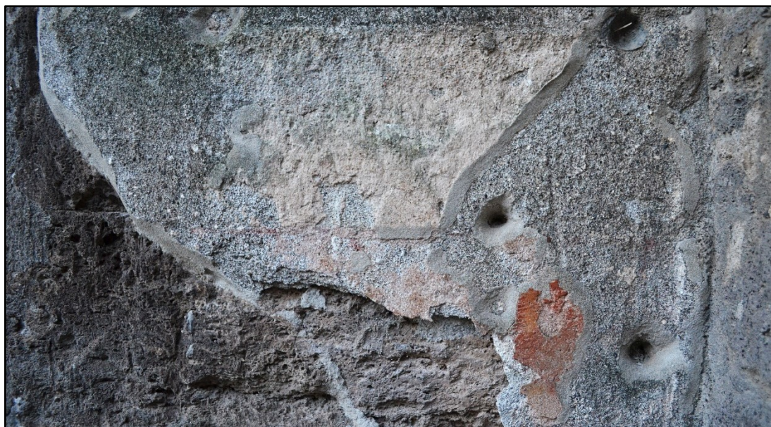
Fig. 42 – Pompei: Orto dei Fuggiaschi, atrium 2, dettaglio della parete sud, tratto ovest (foto dell'autore).
