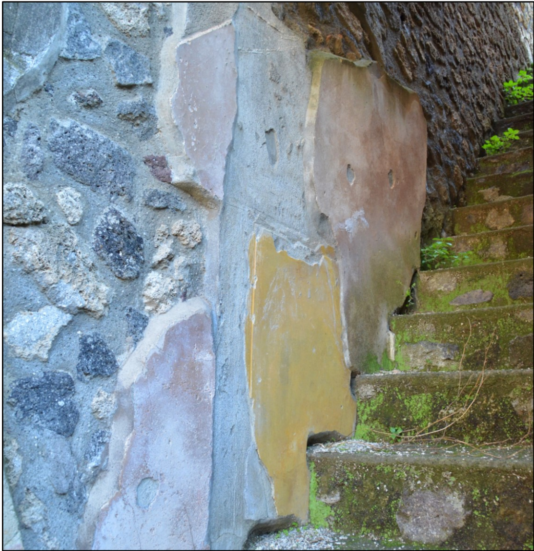
Fig. 75 – Pompei, Casa di Obellio Firmo (IX.14.4): vano scala 01 (foto dell'autore).
