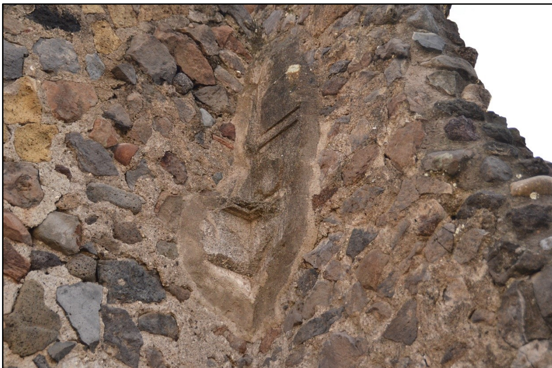
Fig. 70 – Ercolano: Casa della Fullonica, angolo tra pareti est e sud dell'ambiente 4 (foto dell'autore).
