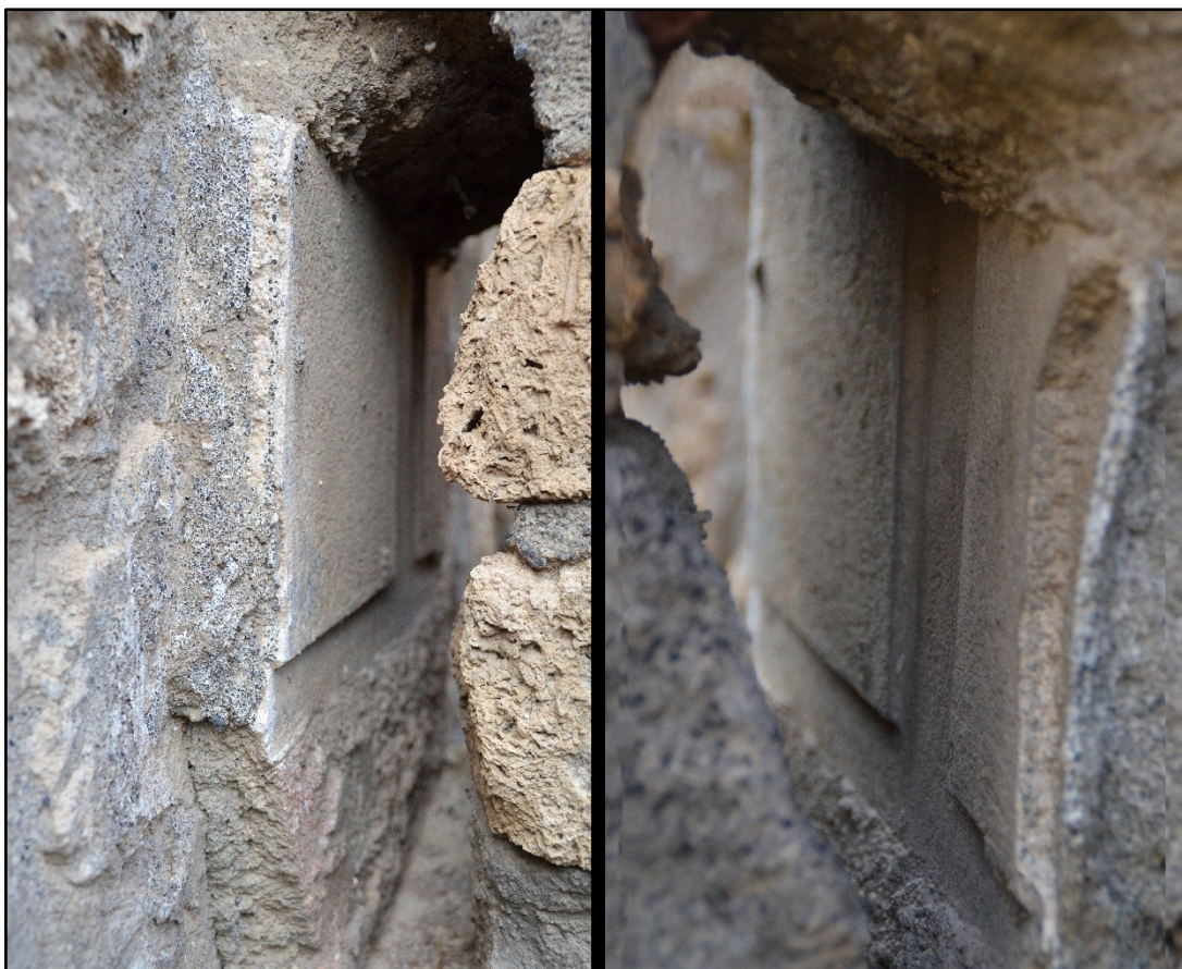
Fig. 36 – Pompei: domus I.12.9, ambiente 5, residui di Primo Stile nell'angolo nord-ovest (foto dell'autore).
