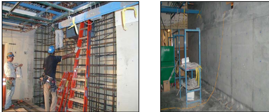
Fig. 2.2 Realizzazione di una parete di taglio in c.a. per l'adeguamento sismico di un edificio esistente
