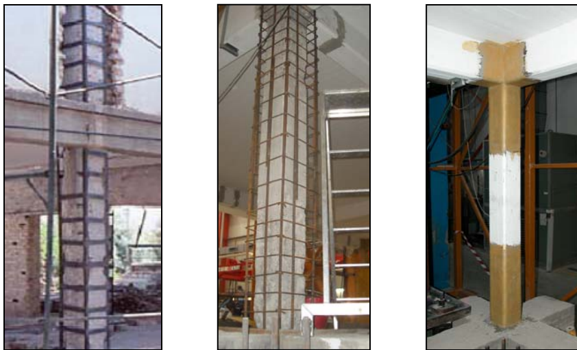
Fig. 2.3 Da sinistra: rinforzo con angolari e calastrelli in acciaio, incamiciatura in c.a. (gabbia di armatura) e fasciatura con plastica rinforzata con fibre di vetro (GFRP) di un pilastro in c.a..
