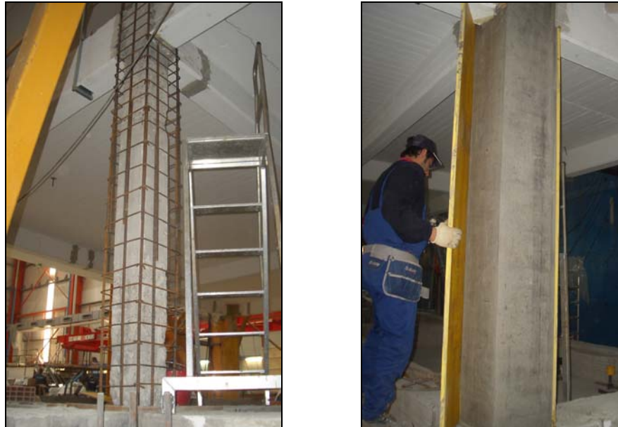
Fig. 5.14 Foto relative all'intervento di ringrosso realizzato presso il laboratorio ELSA di Ispra (VR). Gabbia di armatura (a sinistra) e pilastro ringrossato in fase di disarmo (a destra).
