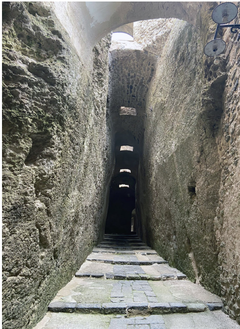
Fig. 1.22 La galleria di accesso al Castello scavata nella roccia e realizzata per volere di Alfonso V D'Aragona.
