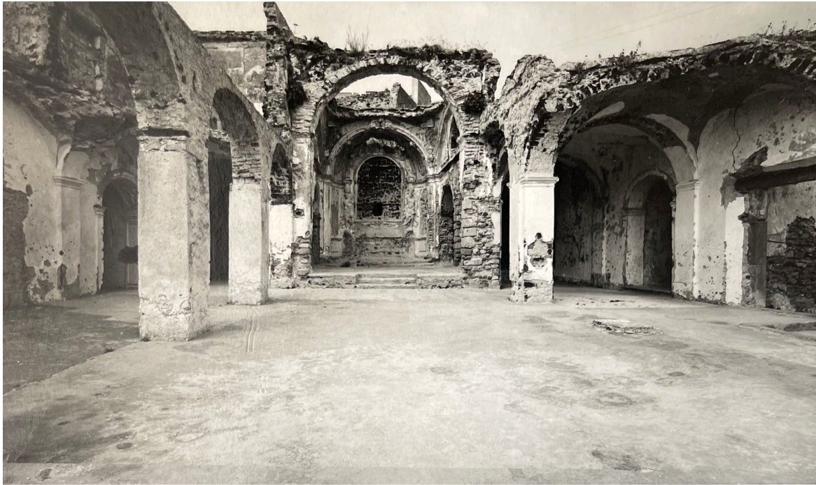
Fig. 4.33 Foto degli anni '60 o '70 del 1900 della Cattedrale dell'Assunta attribuibile all'architetto Ezio De Felice. Si può osservare l'impronta del secondo pilastro della navata destra (Fondazione Ezio De Felice, Archivio documenti, faldone 177).
