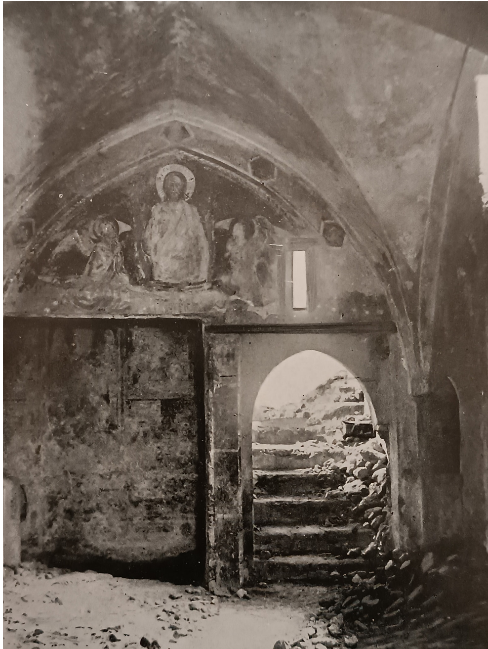
Fig. 2.5 Fotografia dell'ingresso della cripta risalente alla metà del XX secolo. Oltre allo stato di abbandono è possibile notare che l'ingresso della prima cappella destra della cripta era murato (nell'immagine a sinistra dell'ingresso). Sulla destra si scorge il vano di accesso alla cappella Calosirto, anch'esso murato probabilmente per ragioni di sicurezza e liberato negli anni '80 del 1900 (G. Algranati, 1930).
