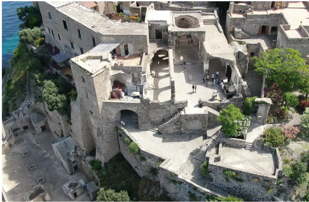
Fig. 2.25 Foto aerea da APR in cui si evince chiaramente l'assetto attuale della Cattedrale dell'Assunta, la scalinata principale a due rampe, l'antistante sagrato e, sulla sinistra, il campanile.
