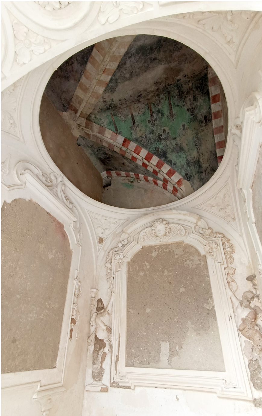
Fig. 2.16 Parte della volta a crociera medievale rinvenuta nella seconda cappella della navata sinistra.
