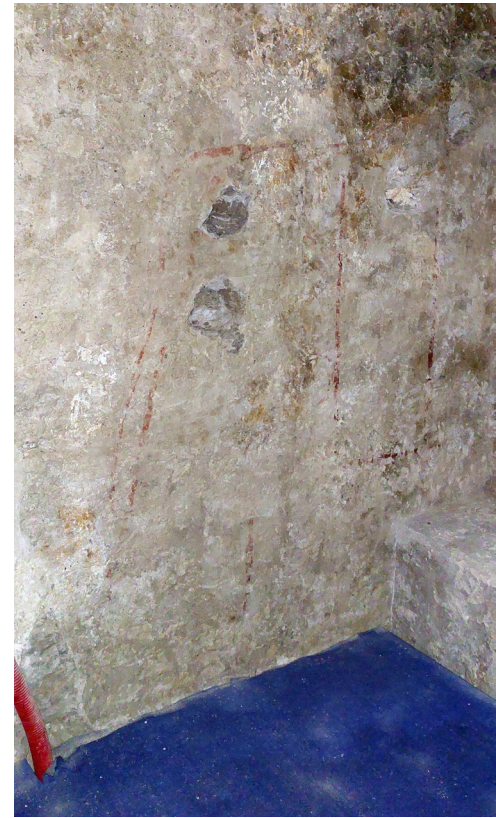
Fig. 2.12 La parete nord-est della cappella.
