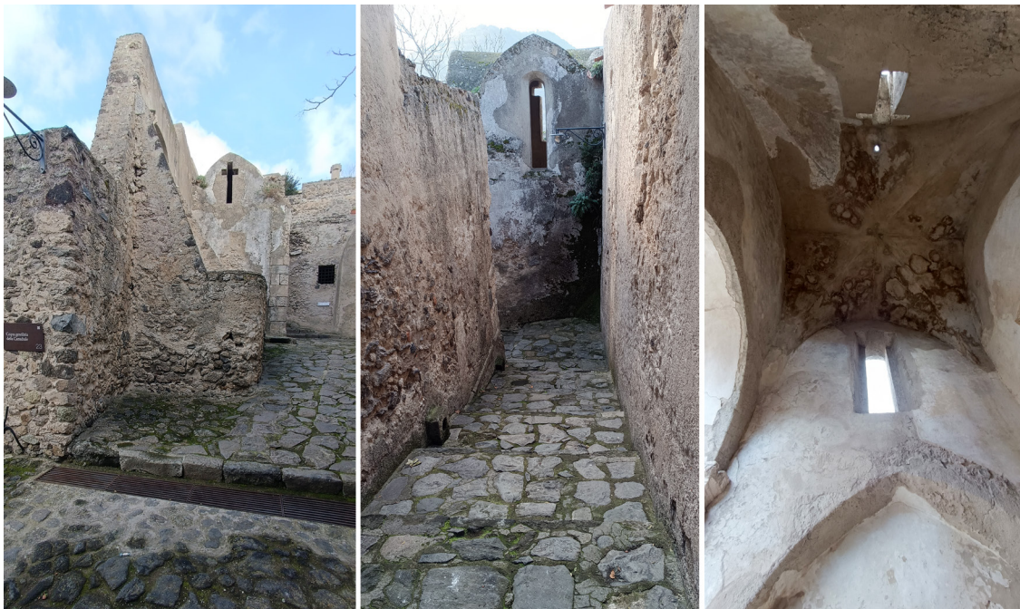
Fig. 2.29 La cappella lungo la navata laterale destra. La struttura si presenta come un'appendice rispetto all'assetto generale ed è coperta da una volta a crociera ogivale.
