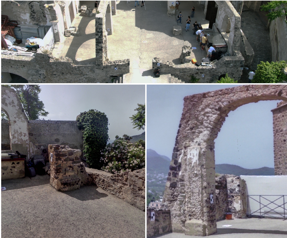
Fig. 4.7 I primi due pilastri della navata centrale. In particolare, del pilastro a destra (in basso a destra nella foto) è sopravvissuto solo il basamento.
