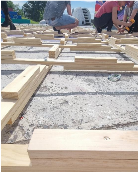
Fig. 519 fissaggio provvisorio, con una sola vite, dei connettori a taglio
