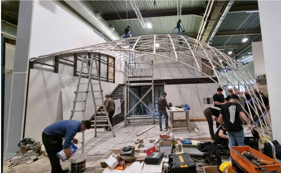
Fig. 51 fase finale del fissaggio, da notare gli archi curvi d'imposta e i motori ancora in tensione che sorreggono la struttura in fase di formatura
