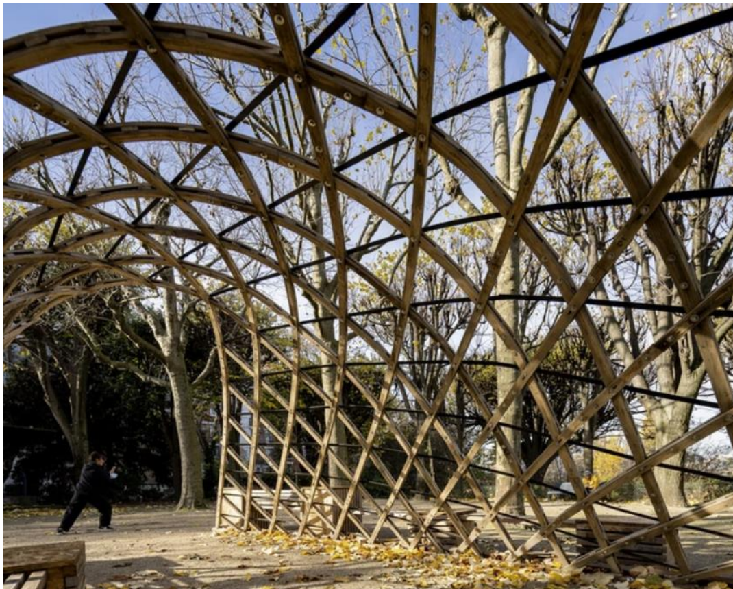
Fig. 16 Realizzazione della gridshell legata al progetto Elastica , 2020, Saint-Denis, M. Leyral, S. Ebode, M. Zitouni, G. Louison. Photo S. Mostefaoui DR
