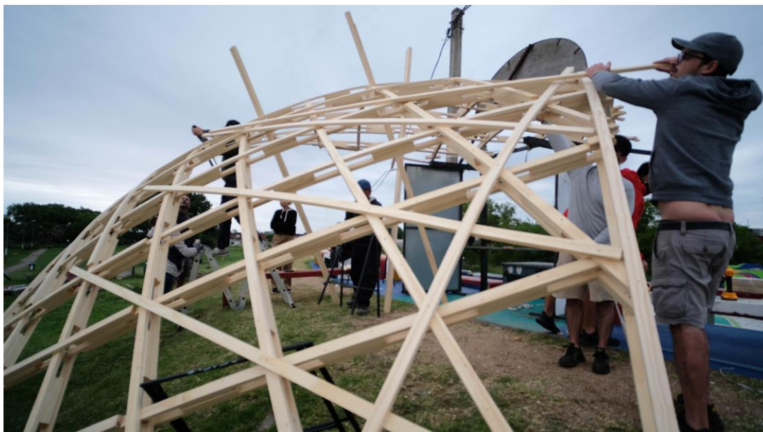
Fig. 72 messa in opera degli elementi diagonali
