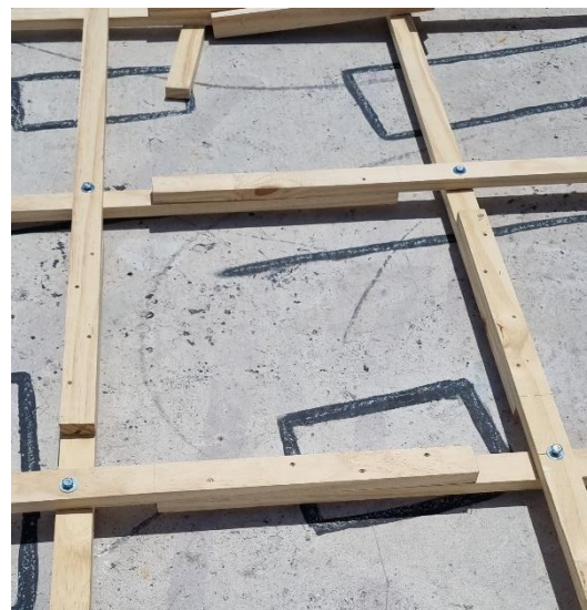
Fig. 50 assemblaggio della maglia sul palco, connessione tra le aste con viti autofilettanti
