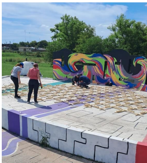
Fig. 50 assemblaggio della maglia sul palco, connessione tra le aste con viti autofilettanti
