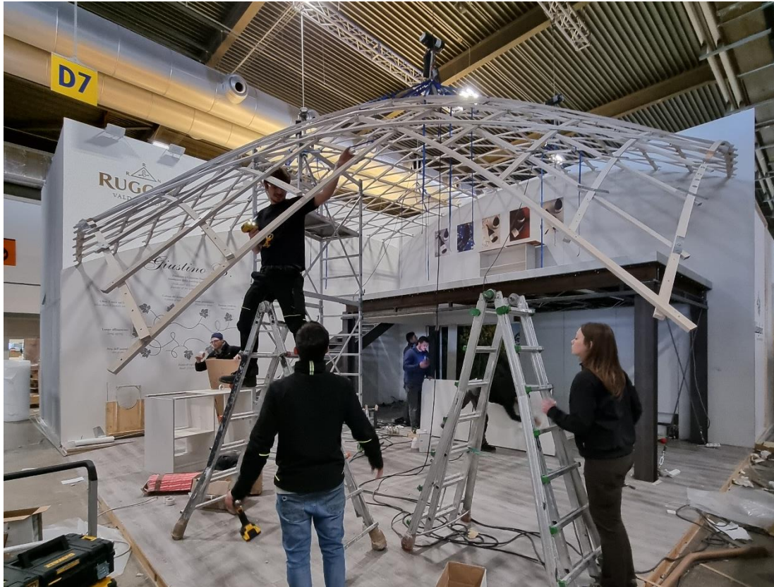
Fig. 44 per lo smontaggio la gridshell è stata riagganciata ai motori e disassemblata un modulo alla volta
