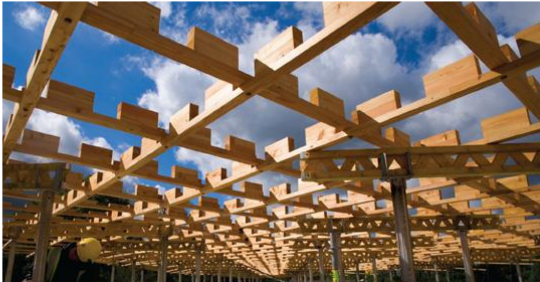
Fig. 9 Maglia in fase di deformazione della Savill Gridshell, si nota la messa in forma solo dei primi due layer sui quali sono fissati i connettori a taglio, in attesa del 3 e 4 layer
