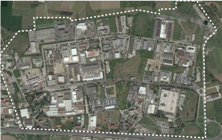
zona ASI Giugliano, in adiacenza campo amministrativo
