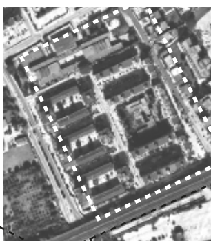
Rione Conocal, Ponticelli -edilizia residenziale pubblica -300-500 metri da insediamenti informali nel 2000-2008 -de-limitazione dalla strada sopraelevata e da via Argine, strada carrabile ad alto scorrimento, recinto e salto di quota rispetto alla quota della strada -sistema spaziale introverso - enclave urbana e sociale, degrado architettonico, frizioni sociali
