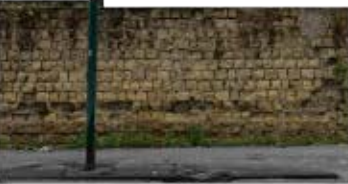
esistente muro continuo - recinto industriale h 4mt
