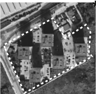
Rione 5 torri, Ponticelli -edilizia residenziale pubblica -300 metri da insediamenti informali nel 2000-2008. -delimitazione con recinto costruito, via Argine e terreni agricoli -torri residenziali di 15 piani -degrado architettonico, frizioni sociali
