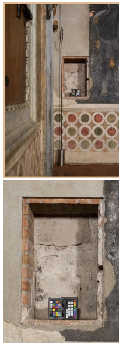
Fig. 7.14 Color checker collocato sulla superficie da rilevare, utile per il bilanciamento dei colori delle foto.
