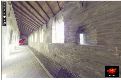
Fig. 7.2 Nuvola di punti vista dal punto di stazione 40. In questo ambiente è impossibile limitare la luce poiché le aperture non hanno le finestre.
