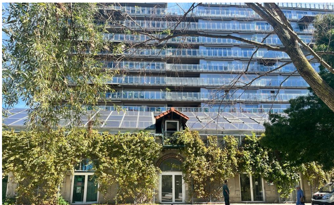
Figura 40 - Impianti fotovoltaici posizionati sia sulle coperture che sulle facciate per massimizzare la produzione di energia, Eco-Distretto di Clichy Batignolles, Parigi.
