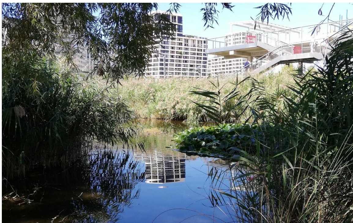
Figura 39 - Bacino di raccolta delle acque meteoriche con piante per la fitodepurazione, Eco-Distretto di Clichy Batignolles, Parigi.
