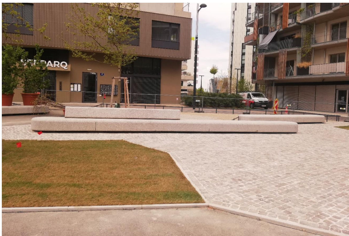
Figura 51 - Pavimentazioni con un'albedo elevata per la riduzione delle temperature superficiali e il miglioramento del comfort termico outdoor , Aspern Seestadt, Vienna.
