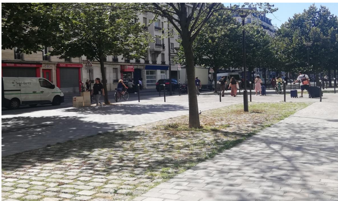
Figura 47 - Pavimentazioni permeabili per favorire il drenaggio delle acque meteoriche nei bacini di raccolta, Eco-Distretto di Clichy Batignolles, Parigi.
