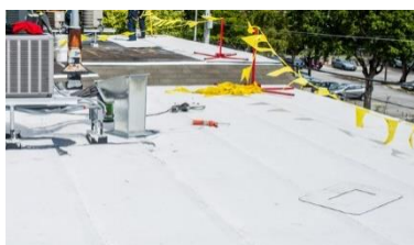
Esempio di cool reflective roof con vernici (fonte: https://floridaqualityroofing.com/miami-commercial-reflective-cool-roof/ )
