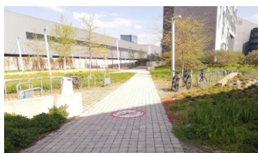
Utilizzo di pavimentazioni con cool materials integrate ad interventi di greening urbano, Campus Wu, Vienna, Austria.
