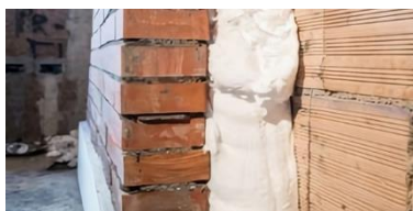
Esempio di isolamento in intercapedine (fonte: https://www.coibentarecasa.it/confronto-isolanti-termici/ )
