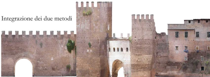
*Fig. A.6 - Integrazione della nuvola di punti frutto del rilievo fotogrammetrico e del rilievo laser scanner di Porta Tiburtina a Roma. [Cecili, Gallo, 2023].*
