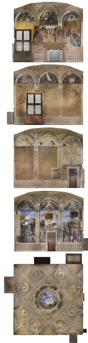
Fig. 3.16 - Ortofoto ad alta risoluzione esportate da Agisoft Metashape dei prospetti interni e della volta.
