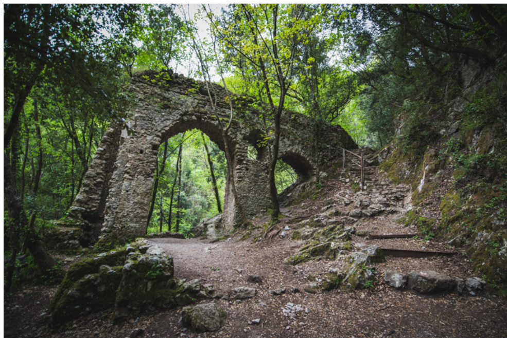
Fig. 3 - Amalfi, Valle delle Ferriere: resti di un acquedotto a servizio degli opifici. Immagine di proprietà del CUEB.
