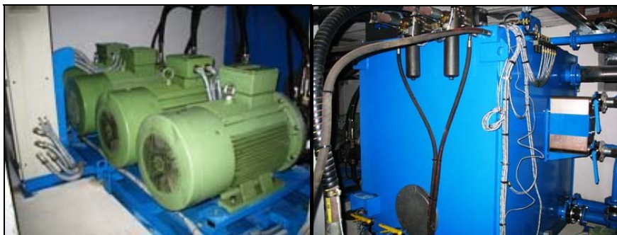
Figura 3.10 Pompe (sx) e serbatoio (dx)
