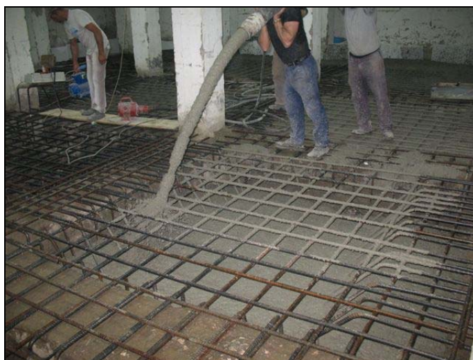
Figura B.2 Armatura della fondazione e fasi di getto della stessa
