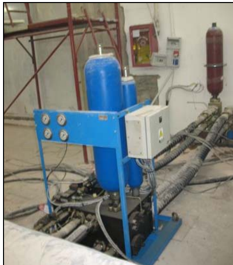
Figura 3.11 Manifold con accumulatori
