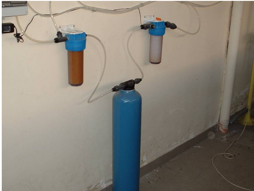
Figura 4.2 – Impianto di deionizzazione
