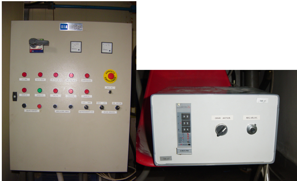
Figura 3.5 – Particolare centralina di controllo
