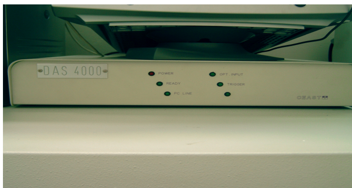
Fig. 2.8 -Sistema di acquisizione DAS
