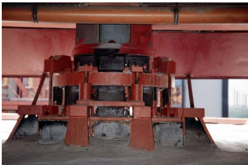
figura 7. isolatori elastomerici abbinati a dissipatori utilizzati nel Centro operativo dei Vigili del Fuoco di Napoli.
