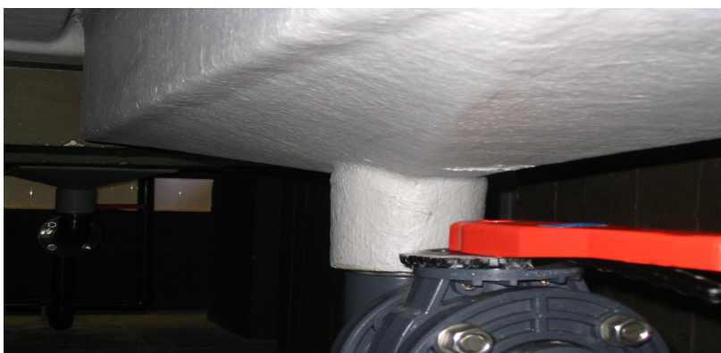
Figura 121. Particolare della condotta di aspirazione verticale.
