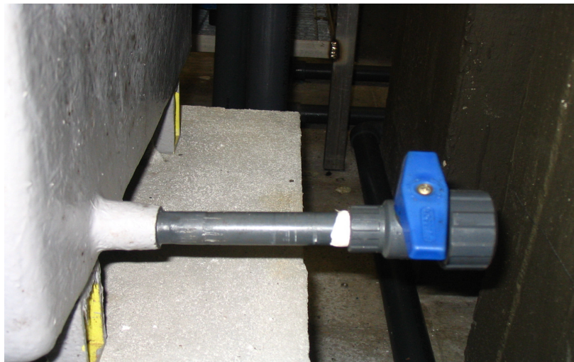
Figura 124. Particolare della valvola di campionamento posta alla base del disoleatore.
