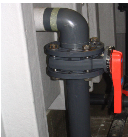
Figura 120. Particolare delle condotte di aspirazioni laterali.
