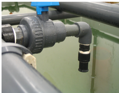
Figura 128. Particolare delle valvole per la pulizia delle pareti.
