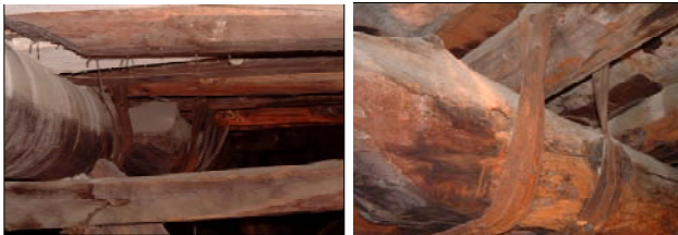
Fig. 3.3.4. Travi di lunghezza ridotta adiacenti al muro di facciata.
