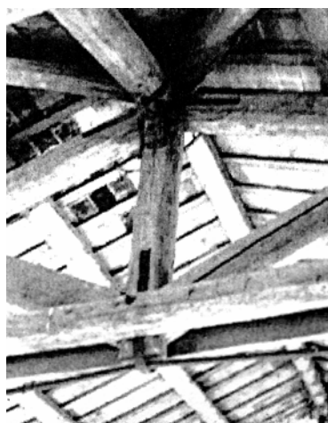
Fig. 1.2.6. Capriata con nodo chiuso e catena doppia
