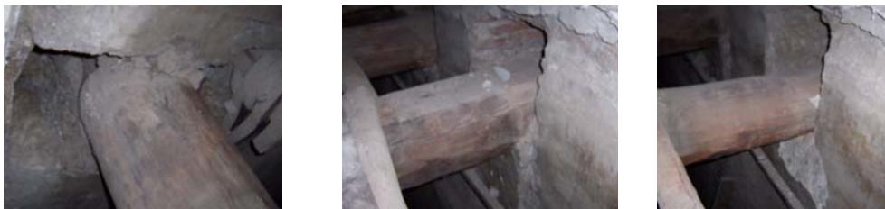
Fig.3.3.9. Particolari appoggio travi.
