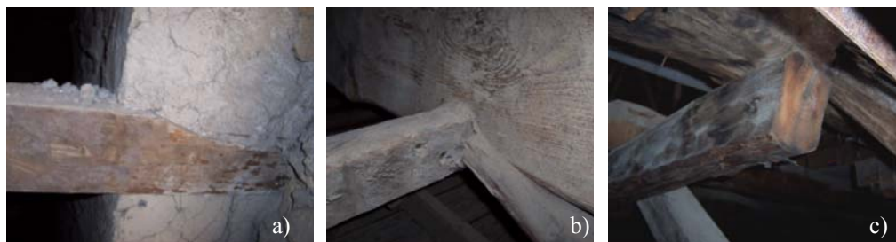
Fig. 3.3.11. Trave rompitratta A: a) Appoggio lato Piazza del Plebiscito; b) Interruzione in corrispondenza della trave 11; c) Estremo libero.
