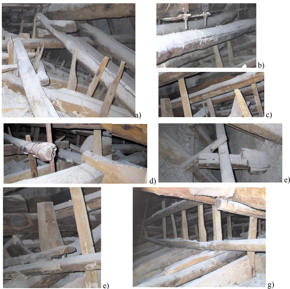
Fig. 3.7.6. Particolari struttura di sostegno della volta.
