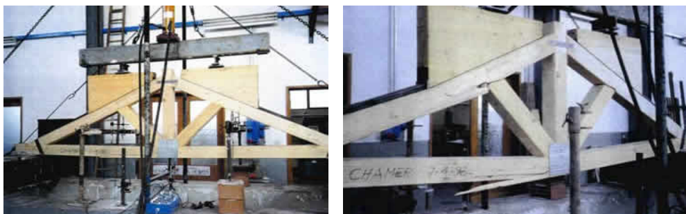
Fig. 1.2.8. Capriata "reticolare": collasso per rottura della catena e del puntone.
