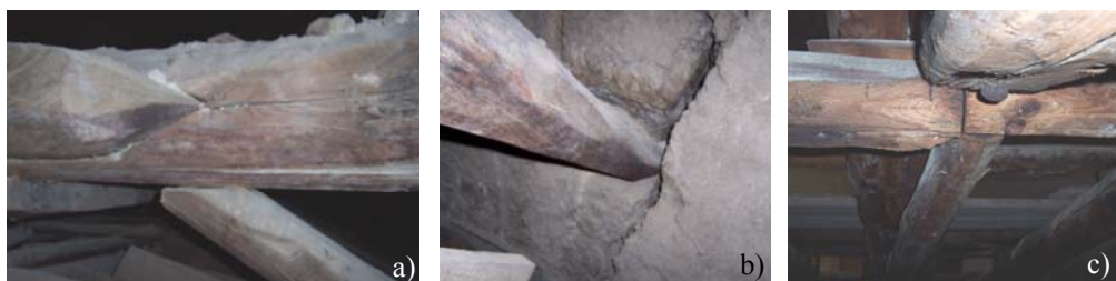
Fig. 3.3.13. a) Trave n. 5 rotta per flessione; b) Appoggio dei puntoni; c) Nodo trave-puntone.
