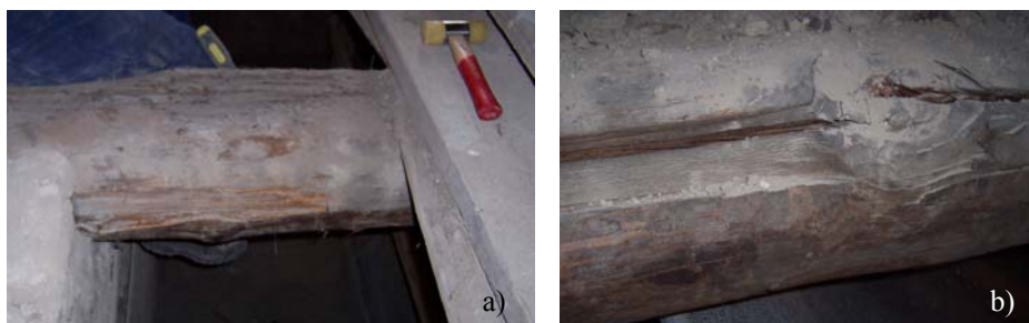
Fig. 3.3.10. Difetti e degrado del legno: a) Attacchi di insetti all'alburno; b) Cipollature.
