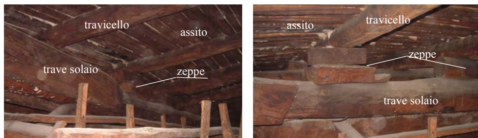
Fig. 3.5.5. Particolari orditura solaio.
