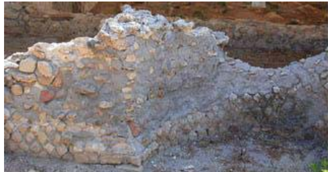
Interventi di restauro con malta cementizia e lastre di piombo
