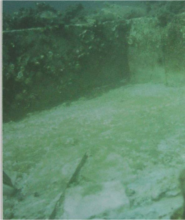
Pavimento parzialmente ricoperto da alghe (Foto G.Villani)
