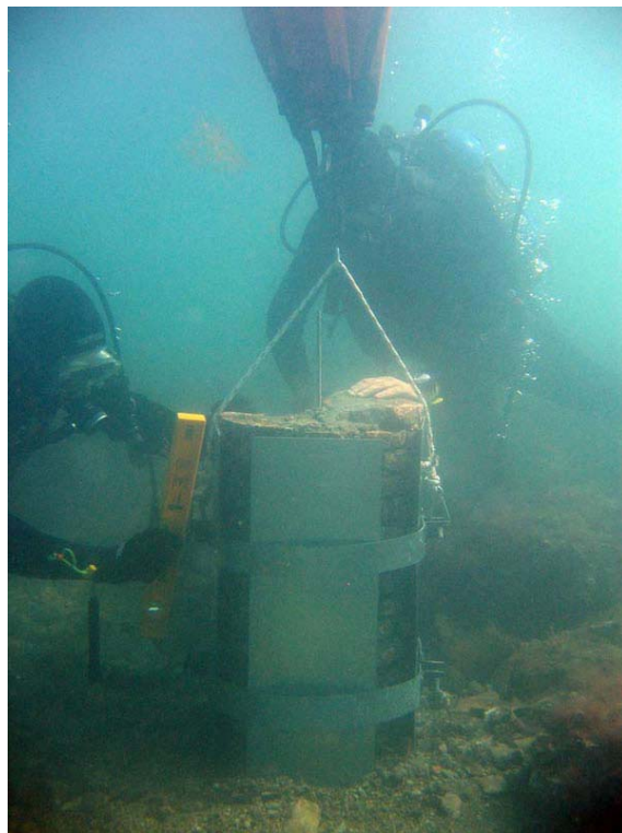
Sollevamento con pallone della colonna imbragata (foto ICR)
