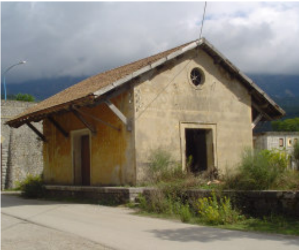
Magazzino nella stazione di Lagonegro (Pz)
