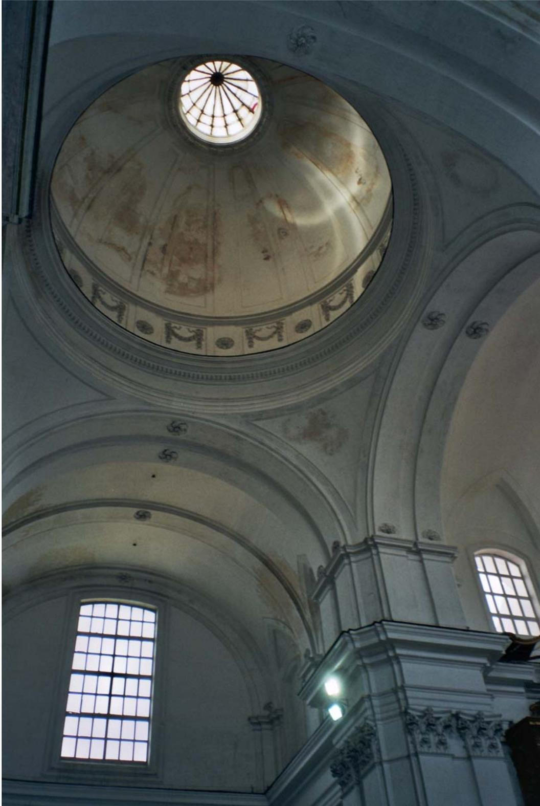
Fig. 23 – Particolare dell'attacco tra uno dei piloni e due degli arconi che portano il soprastante tamburo circolare e la leggera calotta sferica, realizzata entro il 1836 su disegno di G. Panico
