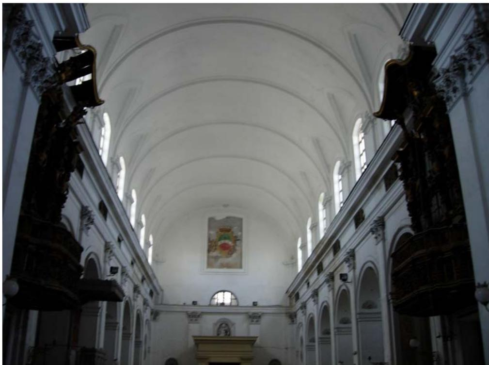
Fig. 13 – La volta di fabbrica a botte che copre la navata principale, ideata da B. Presti nel 1677 in sostituzione dell'antico tetto piano in legno
