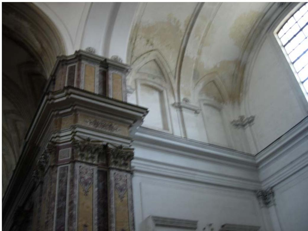
Fig. 18 – Particolare della volta del braccio destro del transetto, interessata da infiltrazioni di acqua piovana, come quasi tutte le strutture della fabbrica
