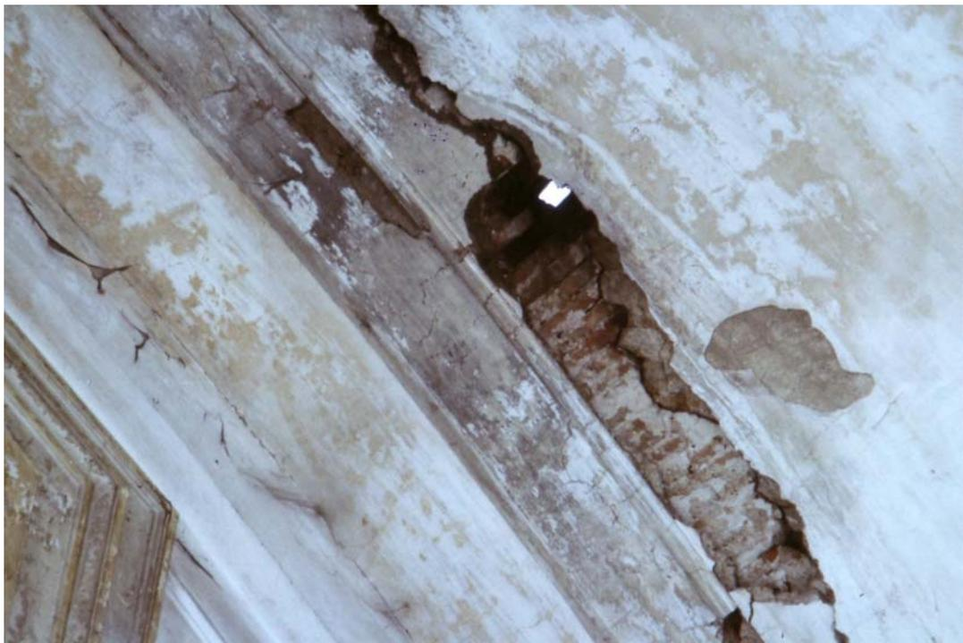
Fig. 36 – Particolare della lesione descritta nella figura 35 (foto d'archivio)
