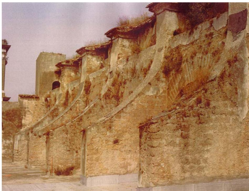
Fig. 31 – Foto dei primi anni del 1980 dei “vottanti” di contenimento della volta settecentesca (lato nord), completamente privi di intonaci (Soprintendenza della Provincia di Caserta)
