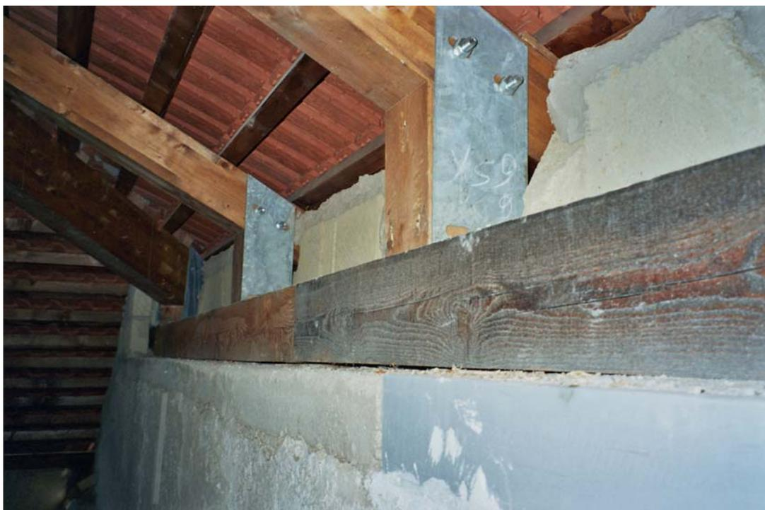
Fig. 45 – Particolare dei gattoni e delle diagonali di sostegno (legno massello, larice o abete), ancorate nella parte bassa delle murature
