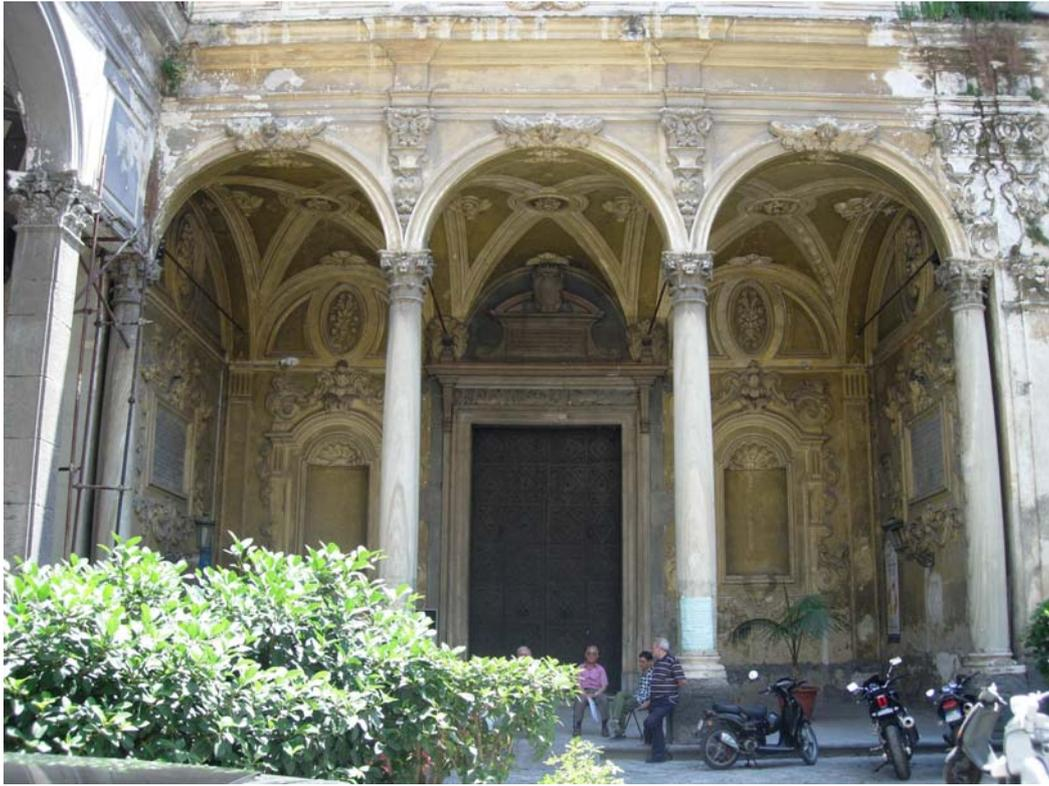
Fig. 19 – Il nuovo atrio della chiesa realizzato secondo il progetto di F. A. Picchiatti unitamente al soprastante coro delle monache, organizzato in tre campate concluse da volte a crociera (1686-1695)
