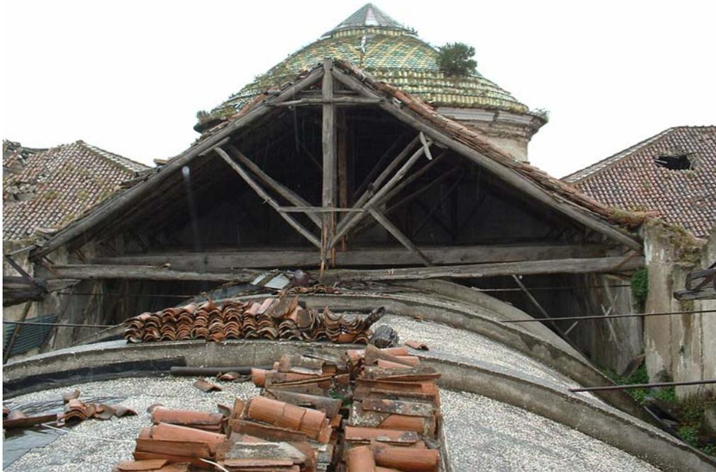
Fig. 32 – La controvolta in cemento armato realizzata sull'estradosso della volta settecentesca, cui quest'ultima è ancorata, realizzata dopo il sisma del 1980 e le capriate fatiscenti oggi sostituite (archivio G. Fiengo)
