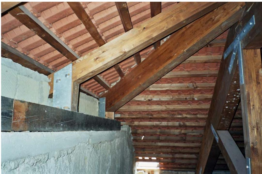
Fig. 44 – Particolare del cuscino di mattoni pieni per appoggio della cordolatura in legno massello, collegata con la sottostante porzione di muro con tirafondi metallici
