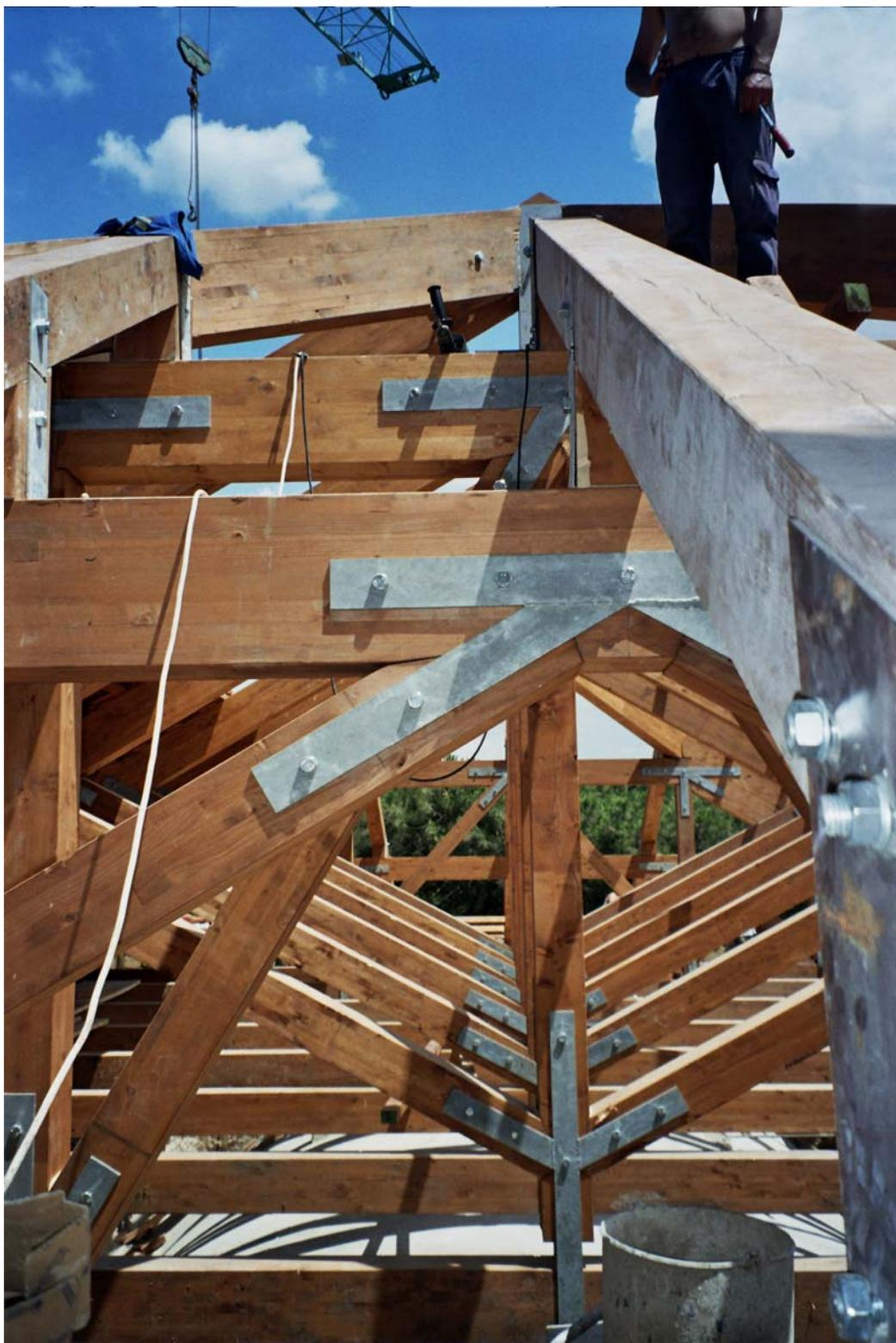
Fig. 48 – Particolare del complesso sistema della struttura del tetto del coro e della sottostante, antica volta a botte
