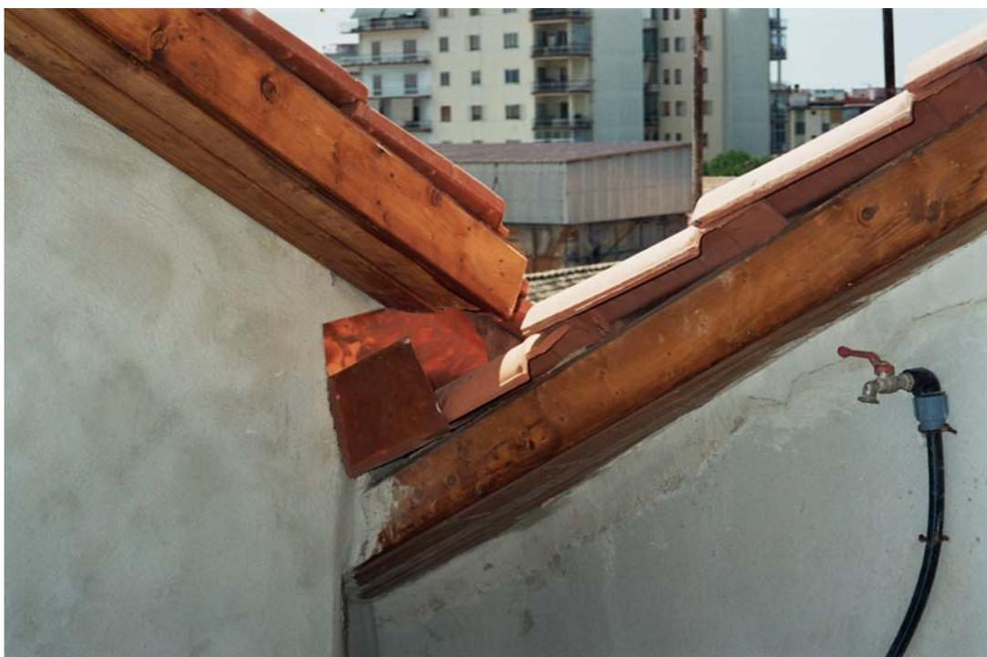
Fig. 50 – Particolare del sistema dei canali di gronda (e delle pluviali) in lamiera di rame
