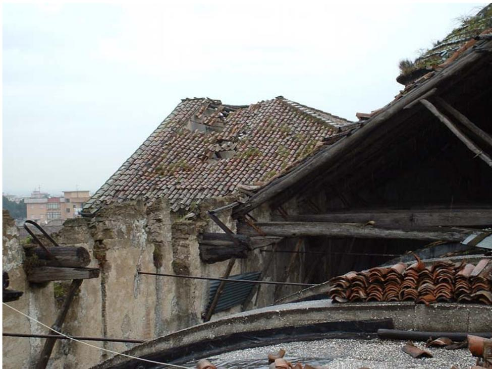
Fig. 33 – Particolare della controvolta novecentesca e di una delle soprastanti capriate in legno, prima degli ultimi interventi. In lontananza il tetto di copertura del braccio sinistro del transetto (archivio G. Fiengo)
