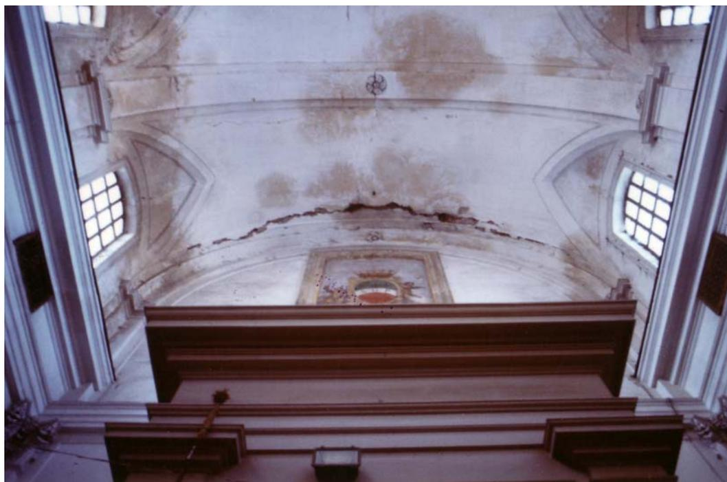
Fig. 35 – La profonda lesione in corrispondenza dell'attacco tra la volta settecentesca ed il timpano frontale causata dal sisma del 1980 (foto d'archivio)
