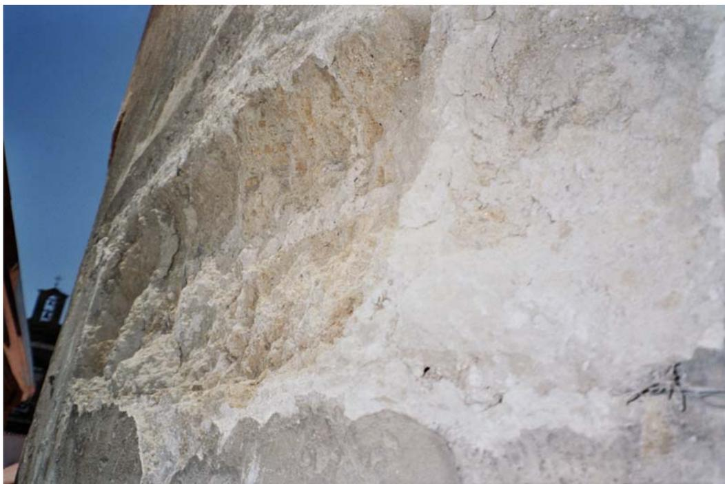
Fig. 54 – Particolare della spicconatura dei brandelli di intonaco residui sulla parete esterna del tamburo
