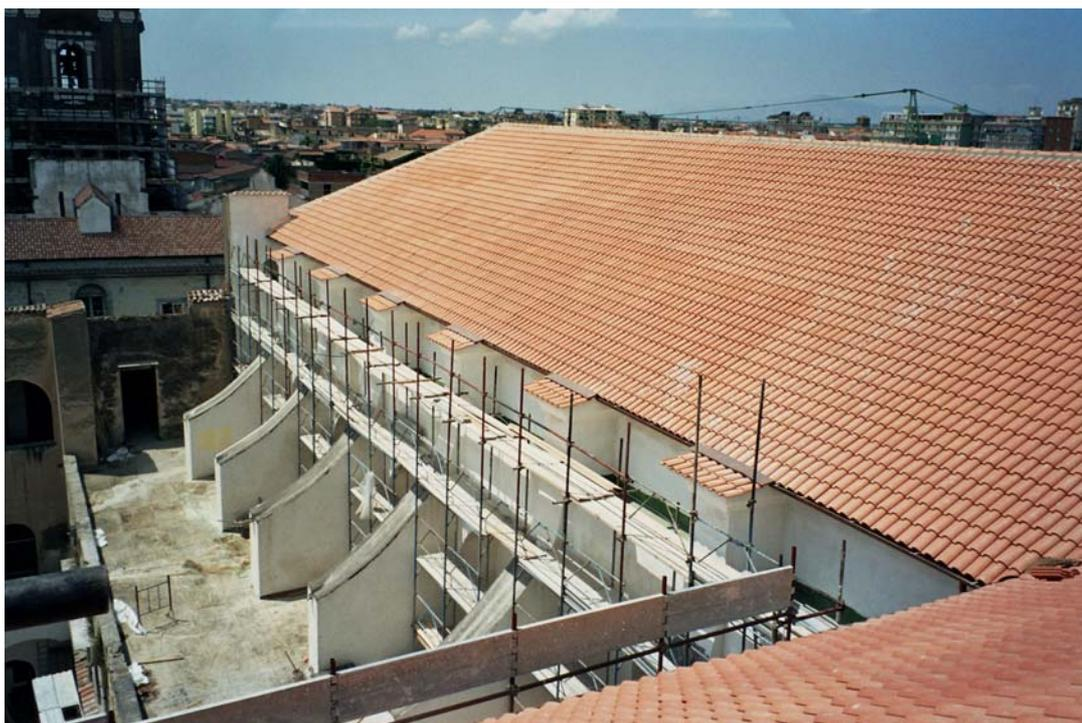
Fig. 49 – Il manto di tegole marsigliesi di uno dei due spioventi del tetto di copertura della navata principale
