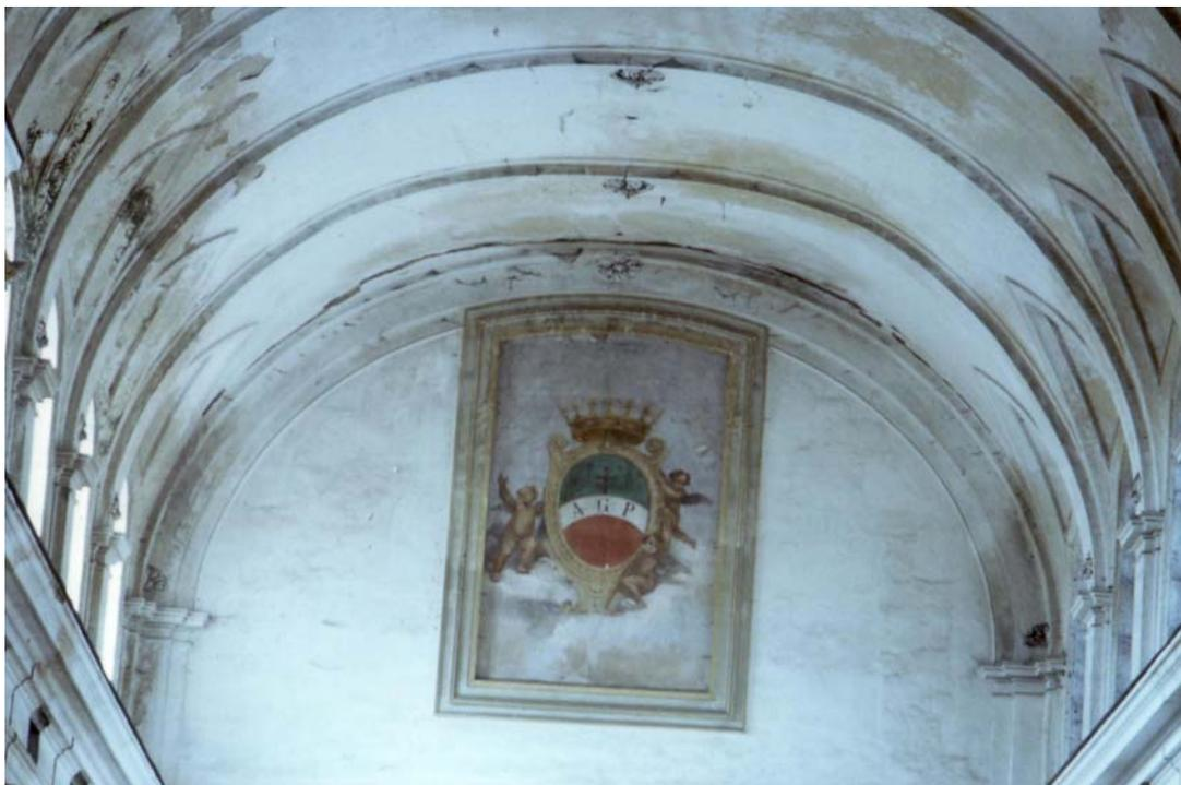
Fig. 37 – Particolare della volta nella zona maggiormente danneggiata dal sisma del 1980 e dalle infiltrazioni di acqua piovana (foto d'archivio)
