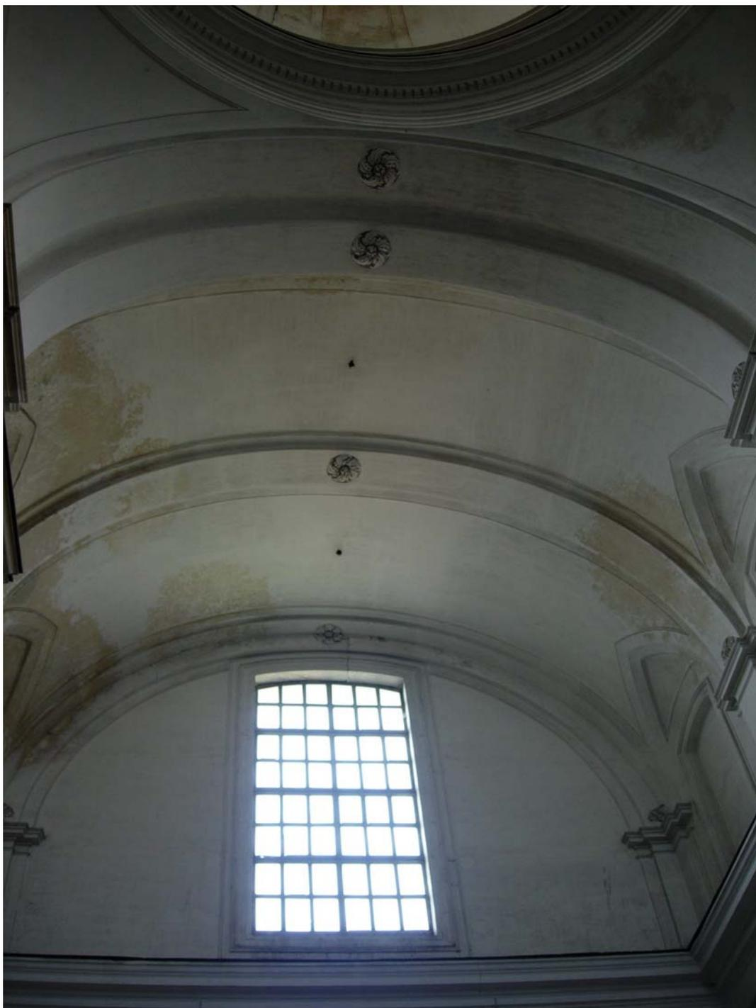
Fig. 22 – La volta di copertura del braccio destro del transetto, trascinata nel crollo dalla cupola a causa delle catene che le tenevano saldamente unite
