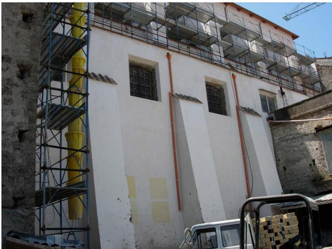
Fig. 53 – Particolare delle buche pontate sulla parete descritta nella figura 52. Sulla destra, in basso, le prove di cantiere del colore per i paramenti murari esterni
