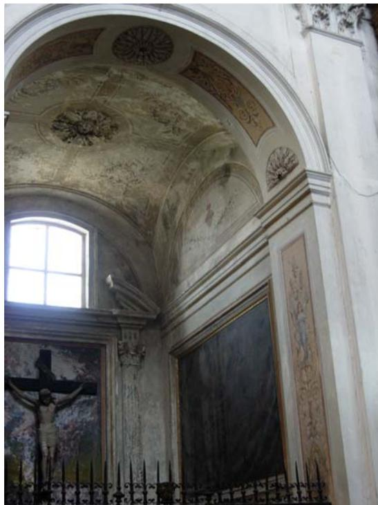
Fig. 12 – Particolari di alcune cappelle laterali del Seicento realizzate in blocchi di piperno di Soccavo. Evidente lo stato di degrado delle volte di copertura e delle pareti laterali, dovuto alla infiltrazione di acqua piovana
