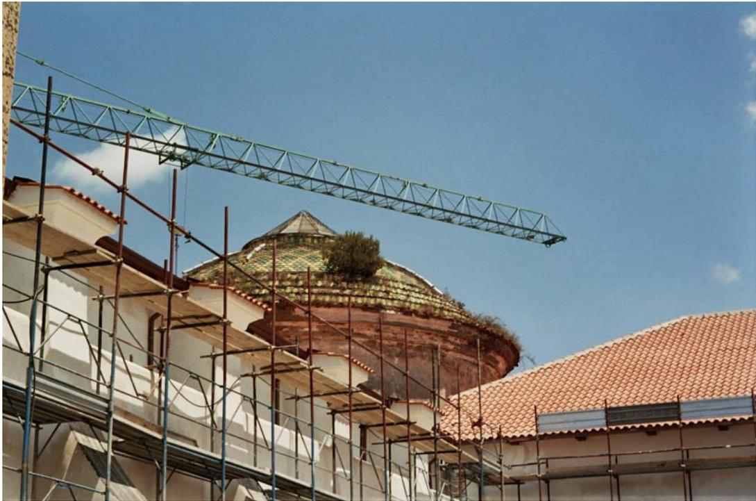
Fig. 42 – Il cantiere del 2005-2006 per la sostituzione delle strutture di copertura delle volte della chiesa
