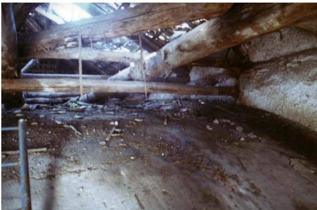
Fig. 38 – Particolare della copertura fatiscente del tetto della navata principale e della volta nella zona ribassata (foto d'archivio)
