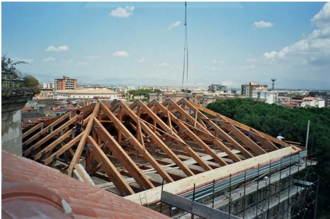
Fig. 46 – La struttura delle capriate in legno lamellare di appoggio agli arcarecci ed al manto di tegole, di copertura per la volta del coro
