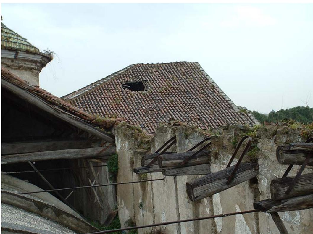
Fig. 34 – Particolare dell'attacco tra le capriate in legno del tetto di copertura della navata principale ed il muro esterno (versante sud) prima degli ultimi interventi di sostituzione (archivio G. Fiengo)
