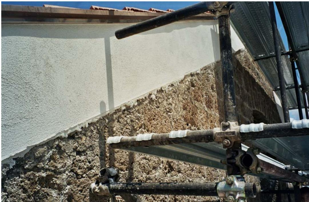
Fig. 43 – Particolare del livellamento degli appoggi dei tetti a due falde, ottenuto con il taglio della testata della muratura
