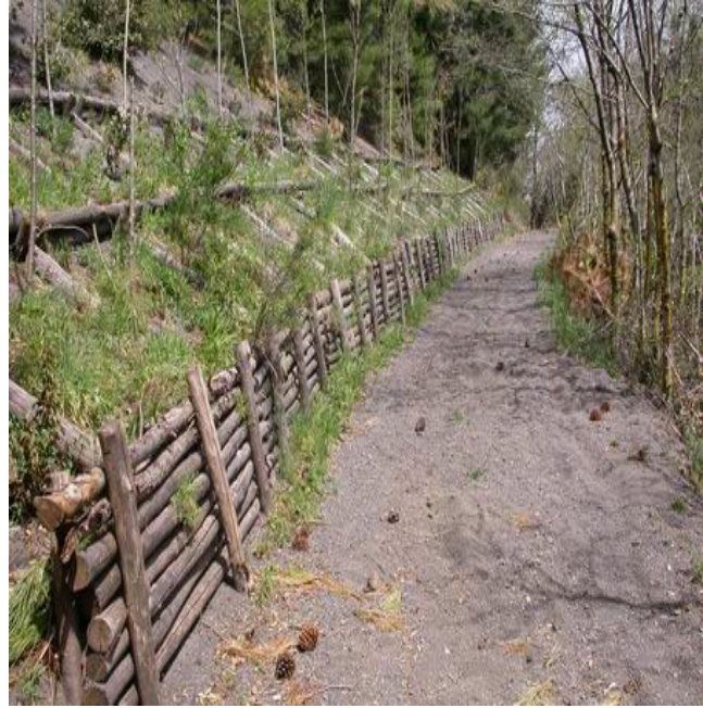
Fig. 6.11 – Esempio di palizzata utilizzata per la sistemazione del sentiero lungo i Cognoli sul Monte Vesuvio.
