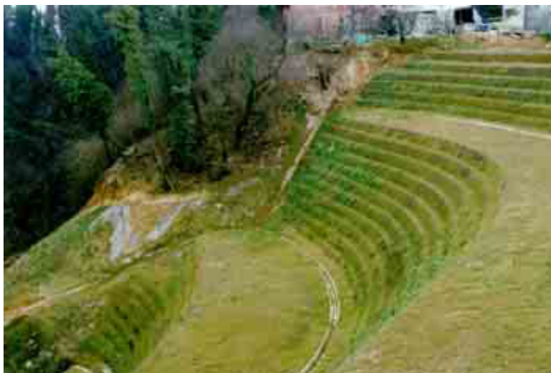
Fig. 6.8 - Inerbimento mediante la tecnica dell'idrosemina di un'opera di sostegno in terra rinforzata (APAT, 2002)
