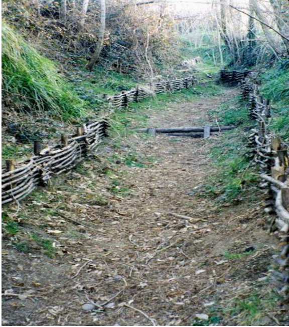
Fig. 6.10 – Esempio di viminata utilizzato negli interventi di sistemazione e messa in sicurezza del Monte Somma.
