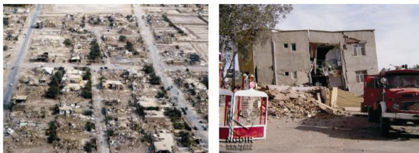
Fig. 5 Effetti del sisma di Bam su edifici contemporanei (Adam et al, 2004)
