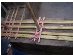
Fig. 41 Rinforzo di pareti in adobe con canne.
