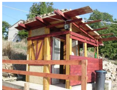
Fig. 13 Costruzione pilota realizzata con pannelli prefabbricati a Casalincontrada (CH) (Foto dell'autore)
