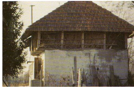
Fig. 28 Edificio in Pisè di Maròn di Brugnera (PN). (Bertagnin, 1999)
