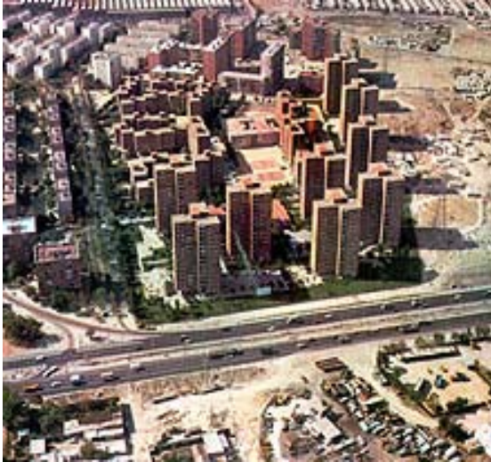
Fig. 3 : Nuovi edifici a torre in Ciudad de Los Angeles, lungo l'asse di connessione con la città.
