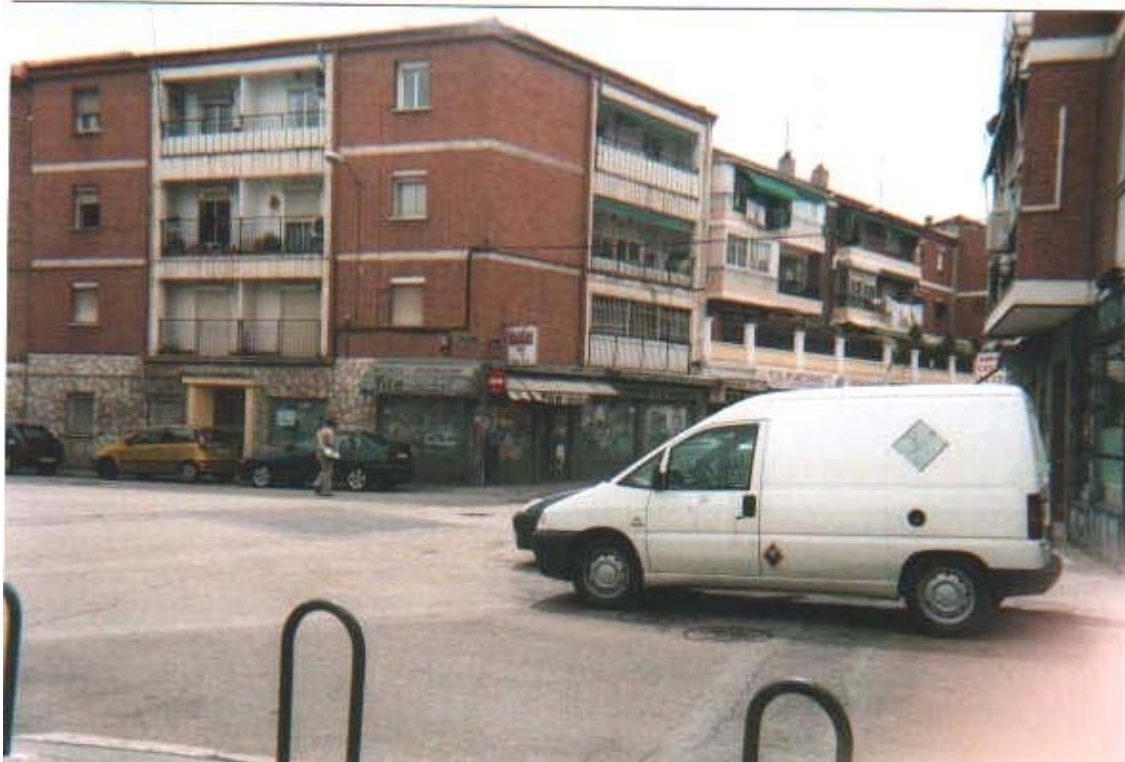
Fig. 7 e 8 : Dall'alto verso il basso: Colonia Boetticher, e l'edilizia che ha sostituito Colonia San Carlo (Villaverde, fotografie aprile 2006).
