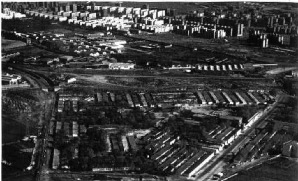
Fig. 1, 2 e 3 : UVA di Villaverde, il primo progetto. Prospetti, piante e foto aerea (3).
